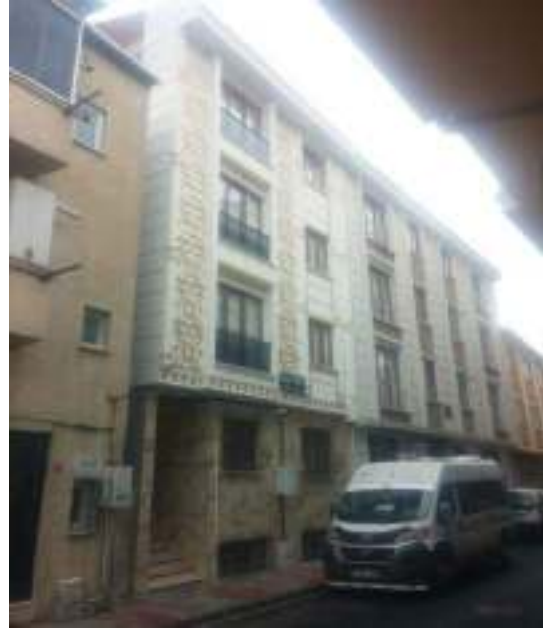
Resim 4: İş Bitirme - İskan Belgesi Aşaması
