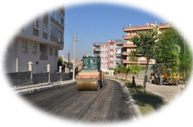
Asfalt yol çalışmaları
