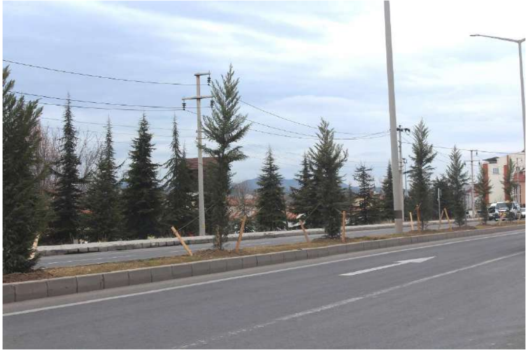
28- Şehit İsmail Düzgün Caddesi Orta Refüj Çalışması : Alanın toprak dolgu ve tesviye çalışması yapılarak ağaç sökme ve dikme makinası ile yaklaşık 200 adet fidanın dikimi gerçekleştirilmiştir.
