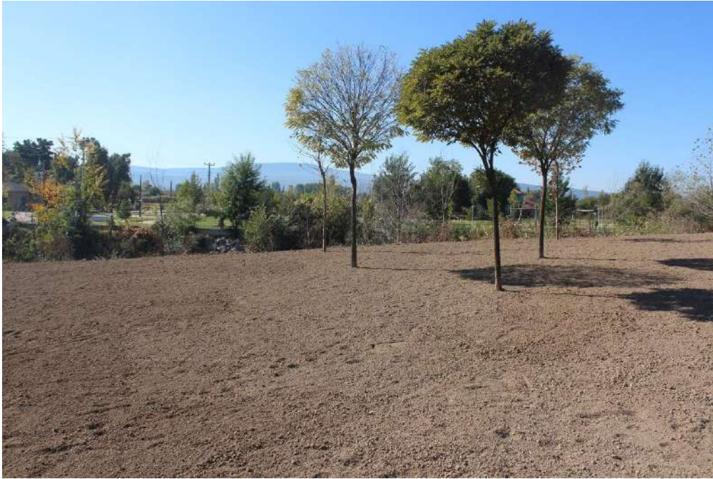
29- Ada Mesire Alanı Tarihi Köprü Önü, Emet Yolu Üzerindeki Alanda Peyzaj Çalışması : Alanın toprak dolgu ve tesviye çalışması yapılarak otomatik sulama sistemi yapılan alan çim ekim işi için hazır hale getirilmiştir.
