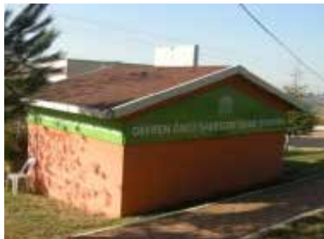
Betonarme yapı Deprem İzleme İst.
