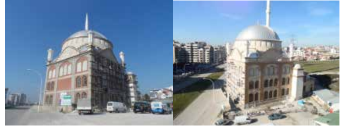
Yüzüncüyıl Camii dış cephe kaplama işi
