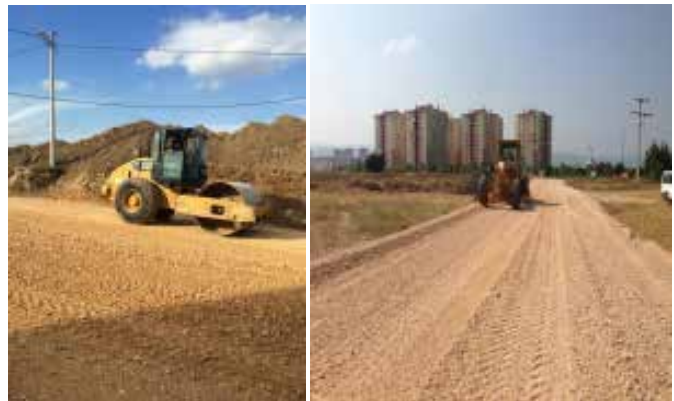
Yol Açma -Malzeme Serme Çalışmaları
