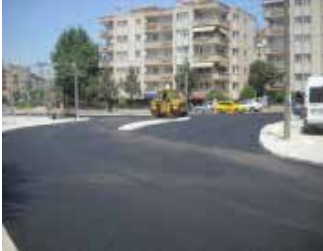
Asfalt Kaplama Çalışmaları
