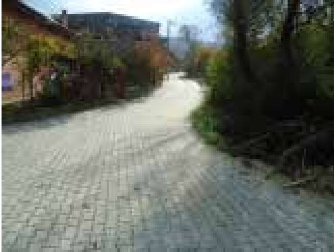
Parke yol çalışması
