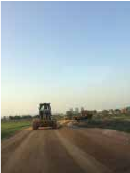
Şantiye Yol açma- malzeme serme çalışmaları
