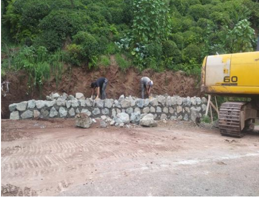
Taş Duvar Çalışması:
