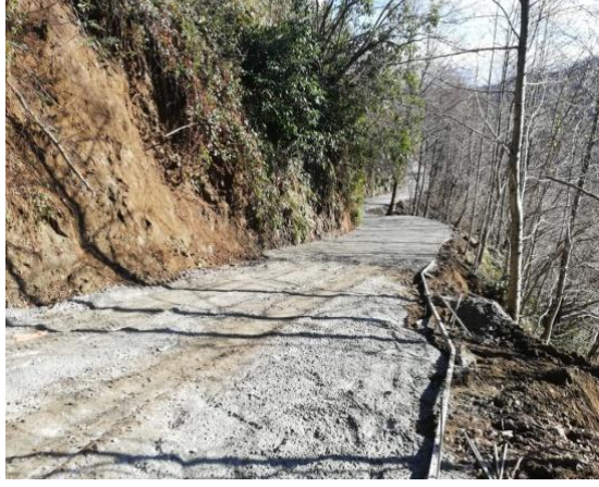
Yol Betonlama Çalışması:
