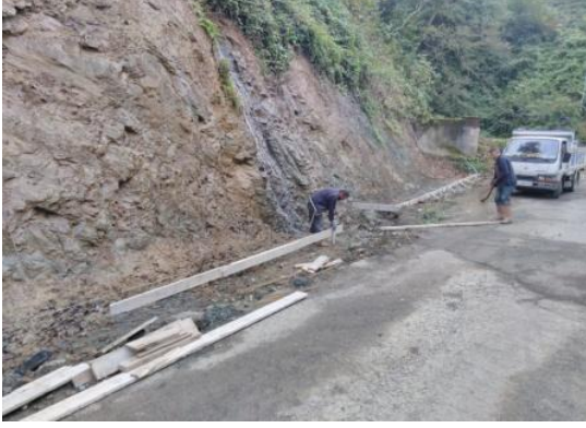
Perde Duvar Çalışması:
