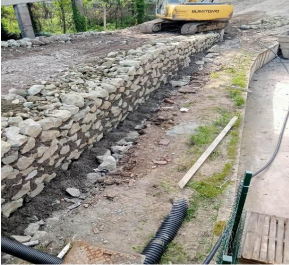
Taş Duvar Çalışması:
