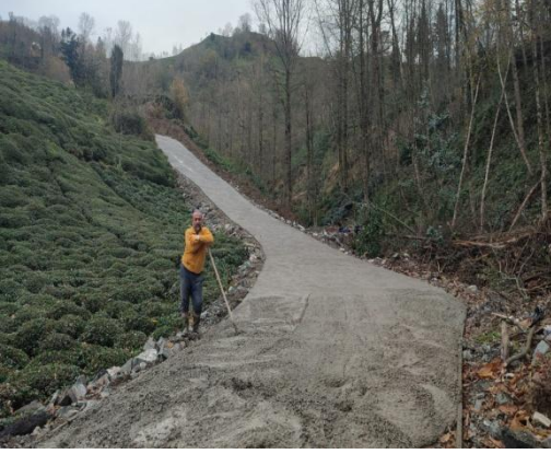
Yol Betonu Çalışması:
