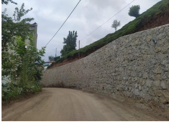
Taş Duvar Çalışması:
