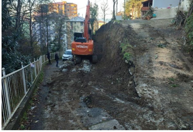
Taş Duvar Çalışması:
