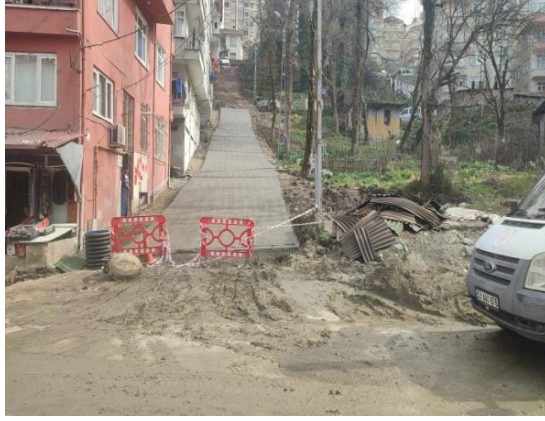
Yol Betonu Çalışması:
