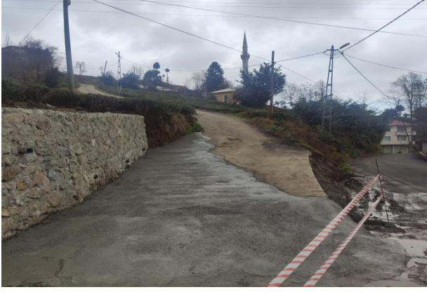
Yama Beton Çalışması:
