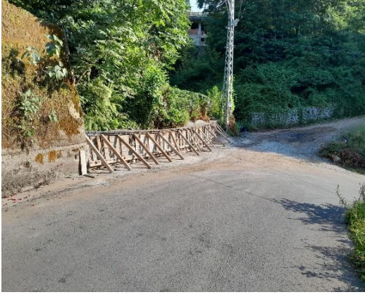
Perde Duvar Çalışması:
