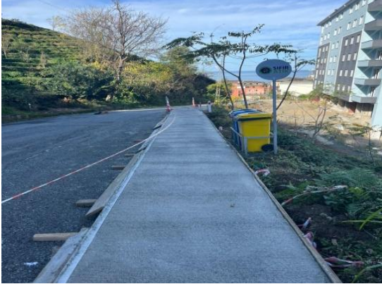
Beton Kaldırım Çalışması:
