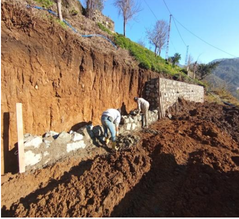
Taş Duvar Çalışması:
