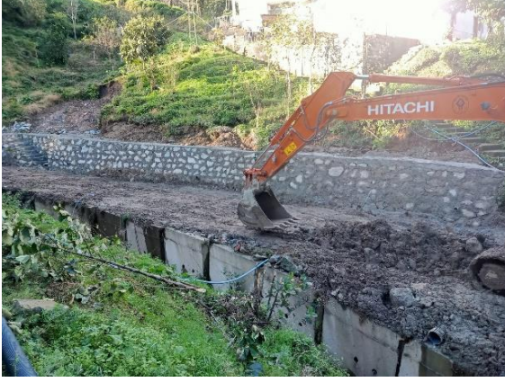
Taş Duvar Çalışması:
