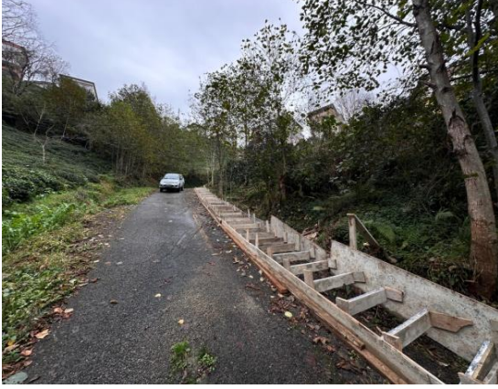
Hatıl Çalışması:
