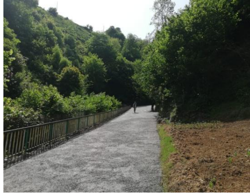
Yol Betonu Çalışması:
