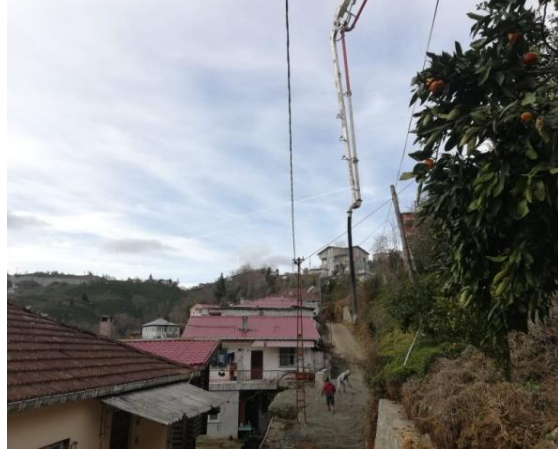
Yol Betonlama Çalışması:
