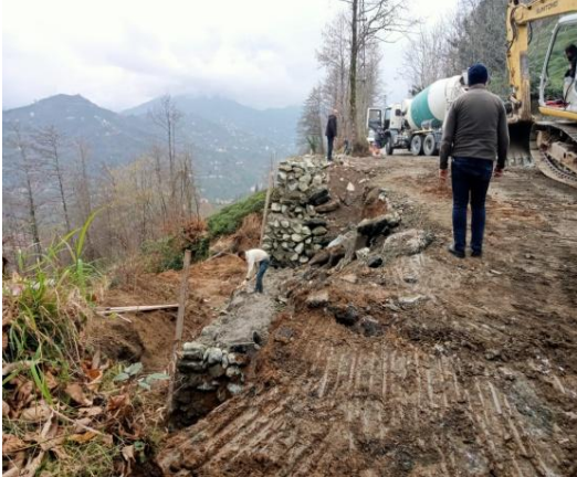
Taş Duvar Çalışması:
