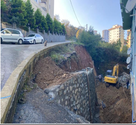
Taş Duvar Çalışması:
