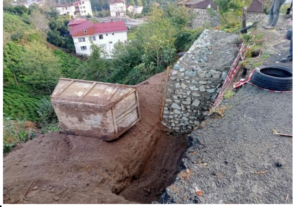
Taş Duvar Çalışması:
