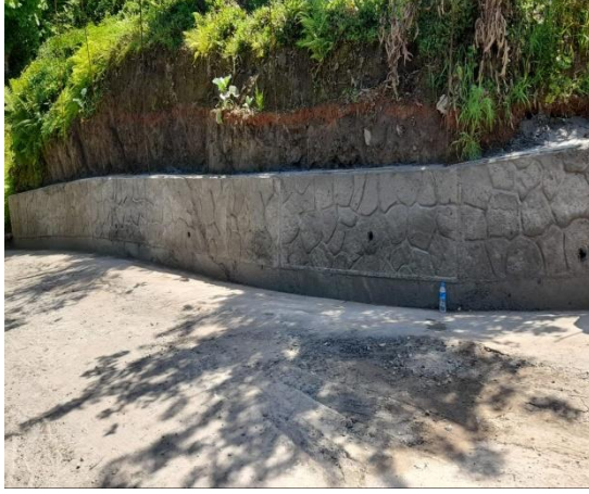
Perde Duvar Çalışması:
