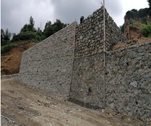
Taş Duvar Çalışması:
