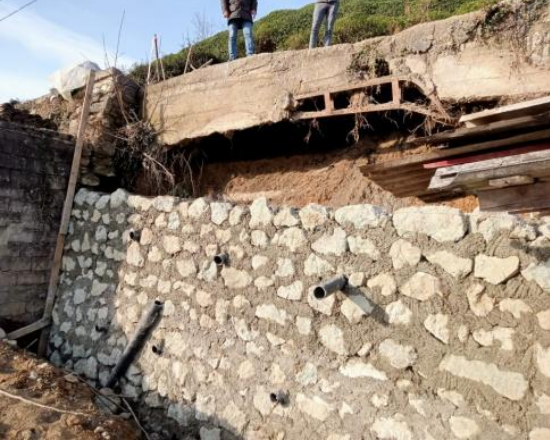
Taş Duvar Çalışması:
