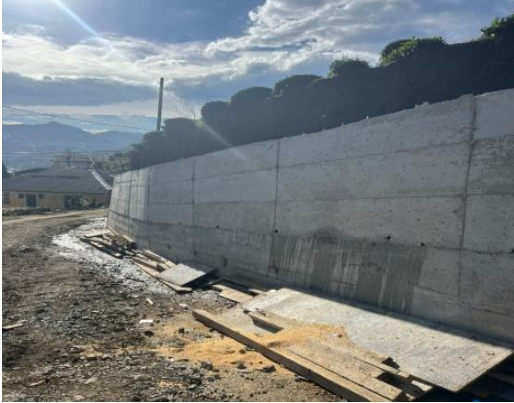
Perde Duvar Çalışması:
