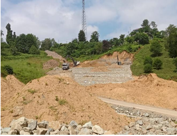
Taş Duvar Çalışması:
