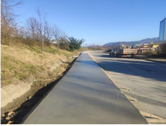
Beton Kaldırım Çalışması:
