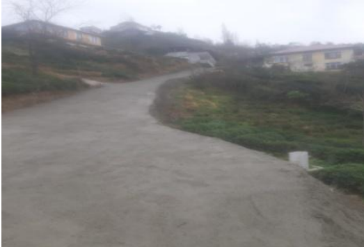
Yol Betonlama Çalışması:
