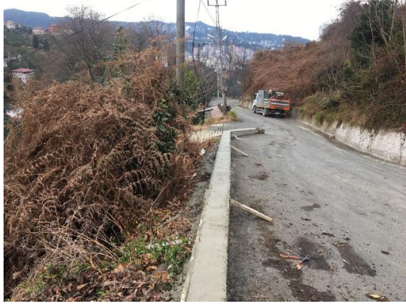
Hatıl Çalışması:
