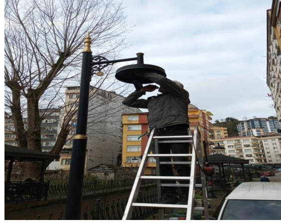
Aydınlatma Bakım Onarım Çalışması:
