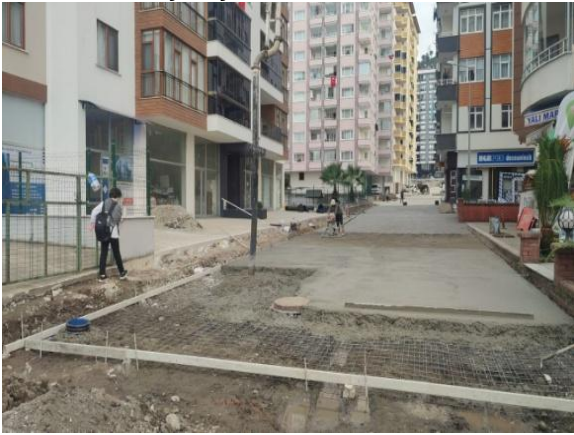
Yol Betonu Çalışması:
