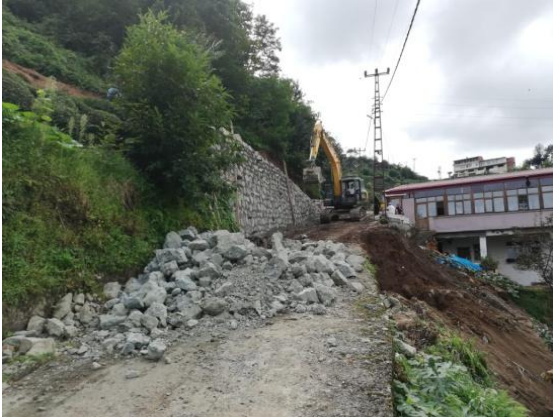
Taş Duvar Çalışması:
