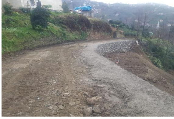
Taş Duvar Çalışması:
