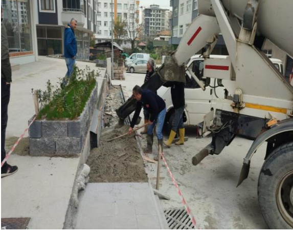
Beton Kaldırım Çalışması:
