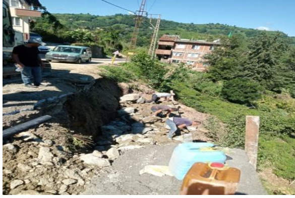
Taş Duvar Çalışması:
