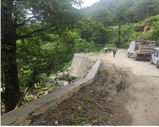
Hatıl Çalışması:
