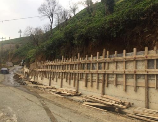
Perde Duvar Çalışması:
