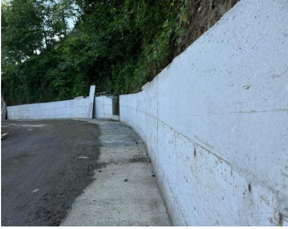
Perde Duvar Çalışması:
