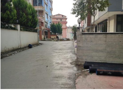
Yol Betonu Çalışması:
