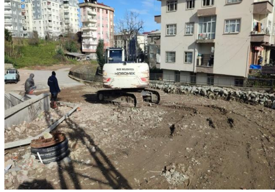
Yol Betonlama Çalışması:
