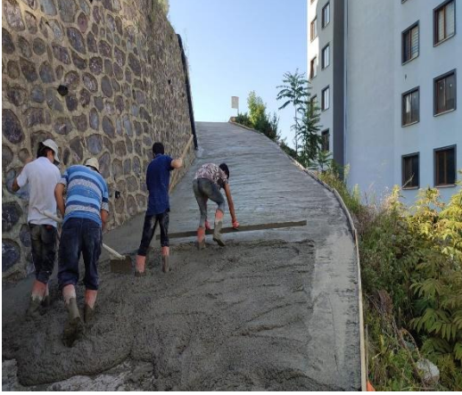
Yol Betonlama Çalışması:
