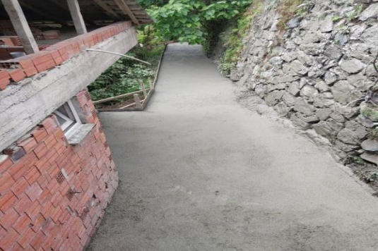
Yol Betonu Çalışması:
