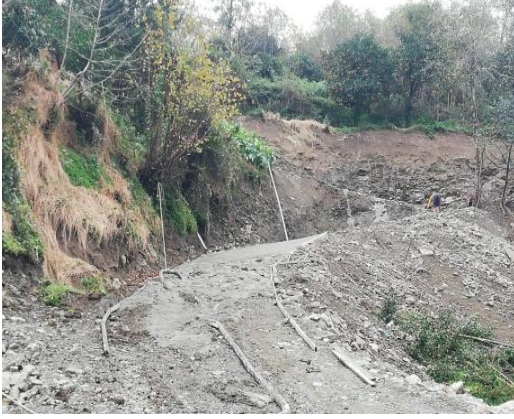
Yol Betonu Çalışması:
