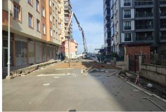
Yol Betonu Çalışması:
