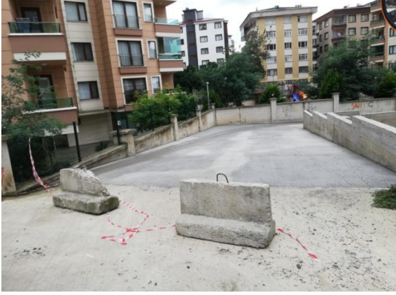
Yol Betonu Çalışması:
