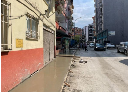
Beton Kaldırım Çalışması:
