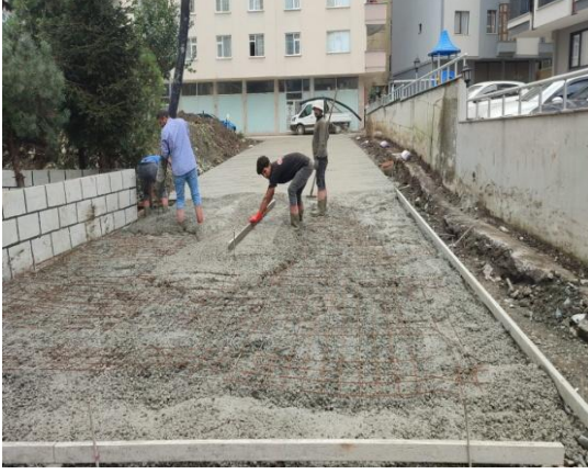
Yol Betonu Çalışması:
