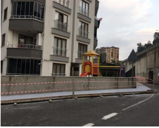
Beton Kaldırım Çalışması:
