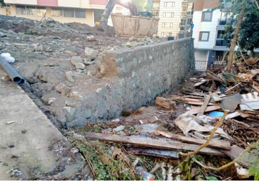
Taş Duvar Çalışması:
