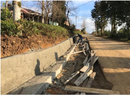
Perde Duvar Çalışması:
