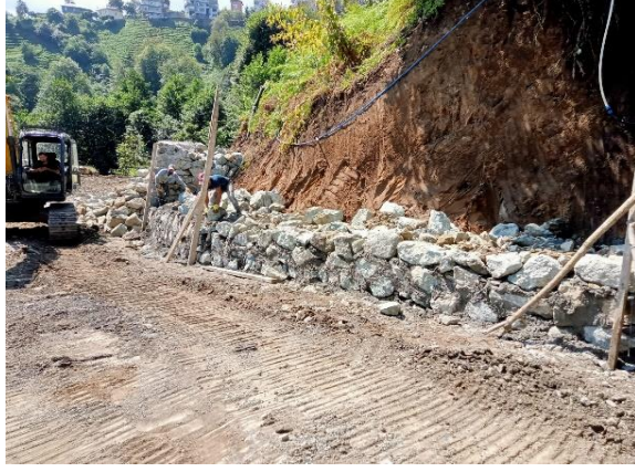
Taş Duvar Çalışması:
