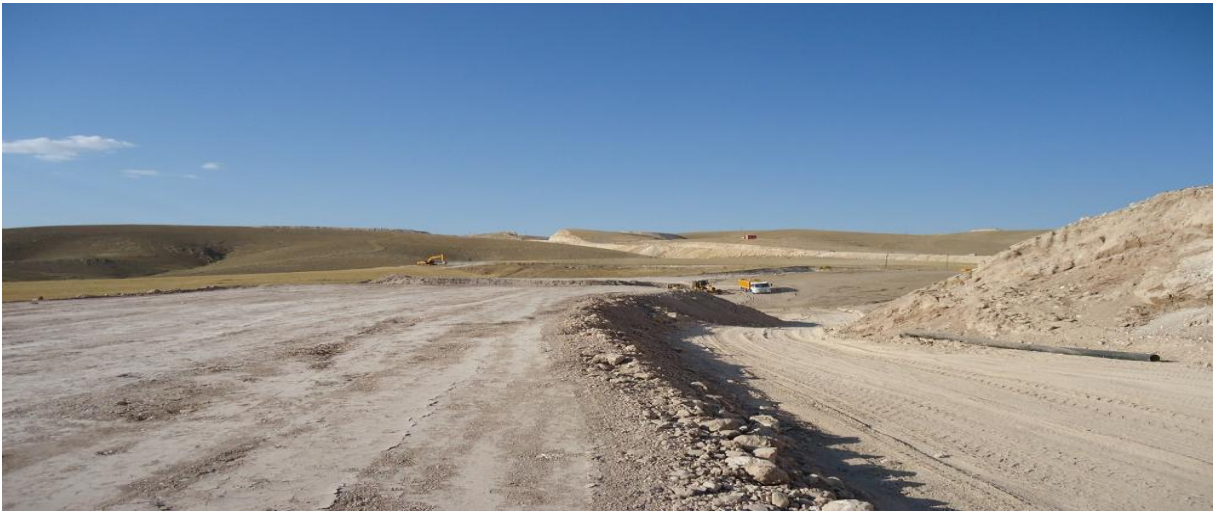
Batı Raman Kampüs Altyapı (1.Etap)
