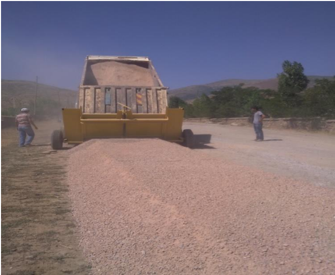
* Hasköy ilçesi köy yolları asfalt kaplama için temel malzeme temini ve figürel nakli.
