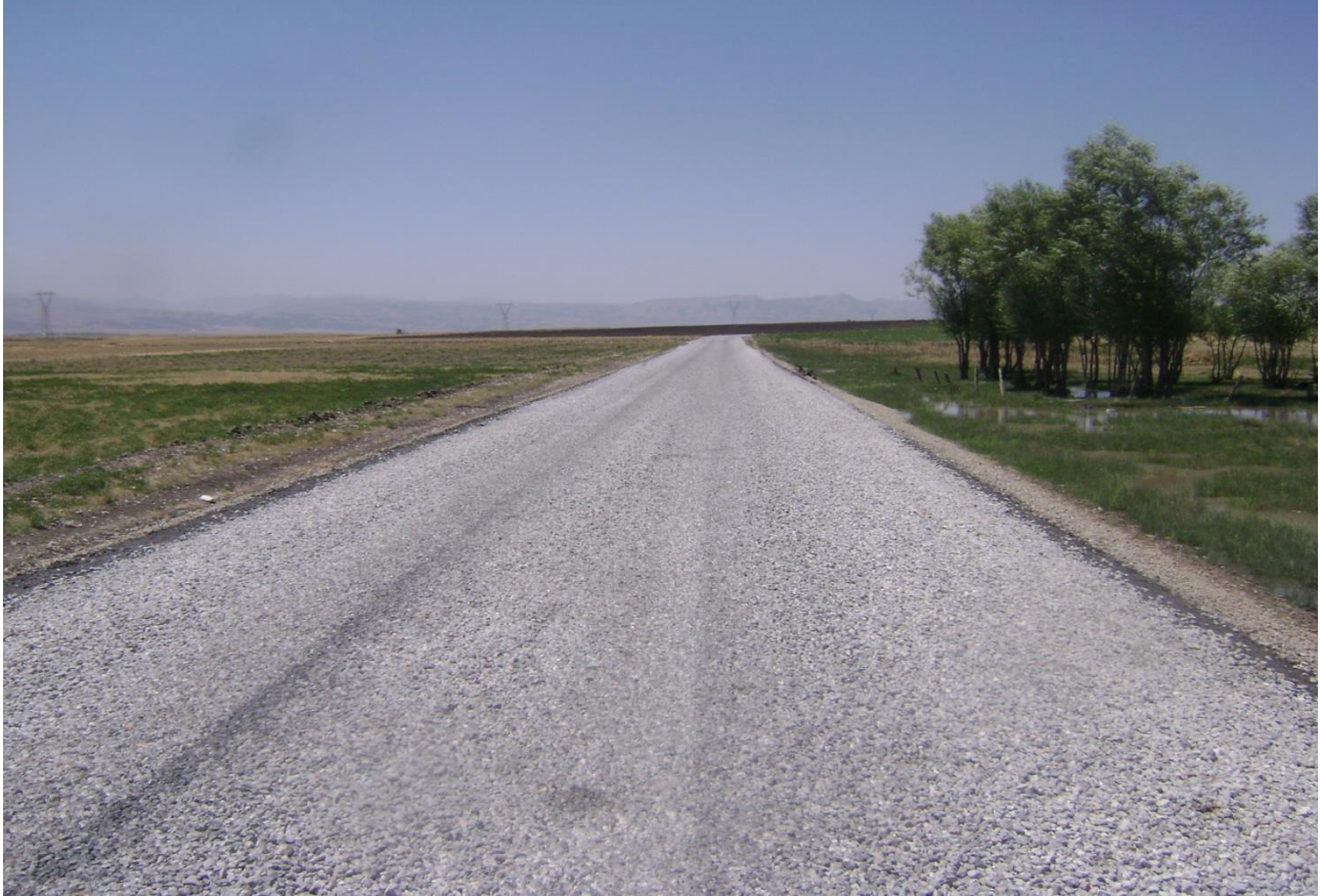
Merkez Bozbulut-Yeroluk arası Köy yolu I.Kat asfalt kaplama işinden bir görüntü.
