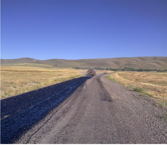
Bulanık Söğütlü Köy yolu II.Kat asfalt kaplama işinden görüntüler.
