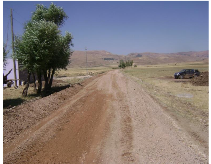
* Merkez asfalt kaplama için temel malzeme serme-sulama ve sıkıştırma yapımı
