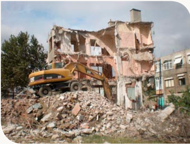
Metruk Bina Yıkımı ve Moloz Kaldırma Çalışmaları
