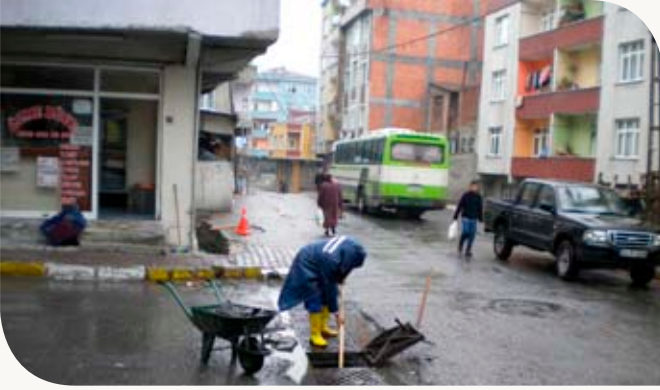
Yağmur Suyu İzgarası Temizleme Çalışmaları
