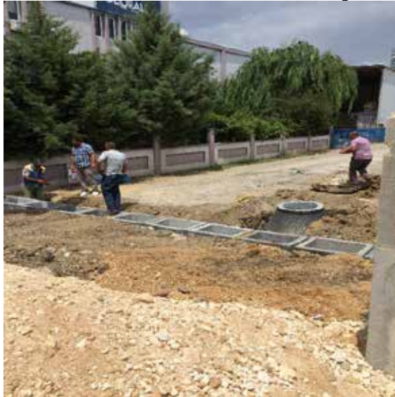
Yağmur suyu ızgara yapımı
