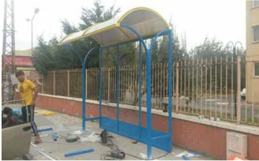
Selimpaşa Devlet Hastanesi Yanı-Durak Montajı
