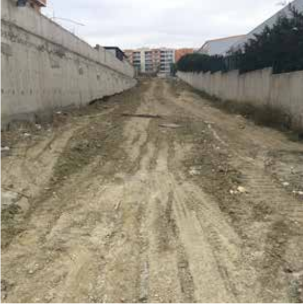
Selimpaşa Mah. 6068 Sokak (Eski hali)
