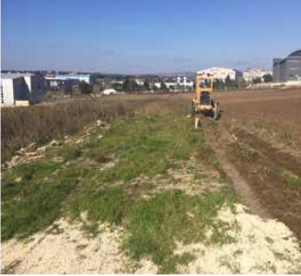
Selimpaşa Mah. 6068 Sokak (Eski hali)
