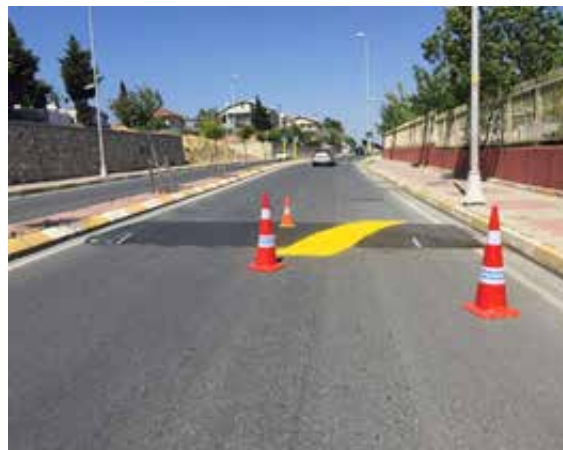
Hız Kesici Set Yapımı
