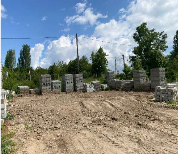
Resim 5 Tespit Edilen Kaçak Yapının Kaldırılması
