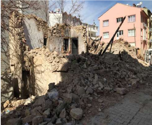
Resim 7 Metruk Yapı Örneği
