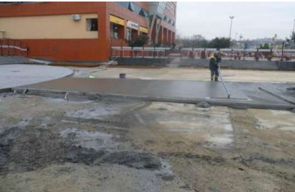
İlçe tören alanı baskı beton uygulması
