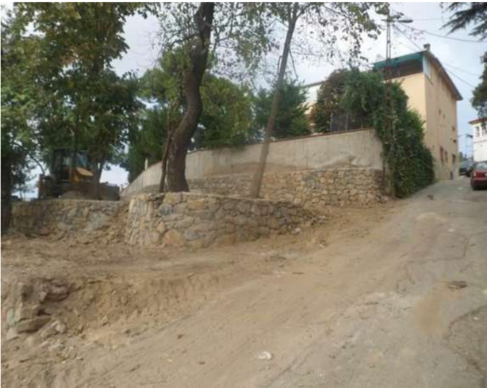
Kanlıca Mah. Fıstıklı Yokuşu Taş Duvar Yapımı
