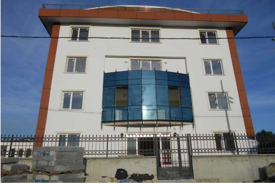
Yenimahalle Hizmet Binası
