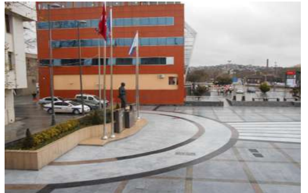
İlçe tören alanı baskı beton uygulması
