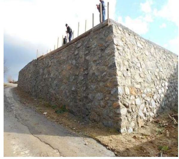
Bozhane–Ek Hizmet Binası Taş Duvar
