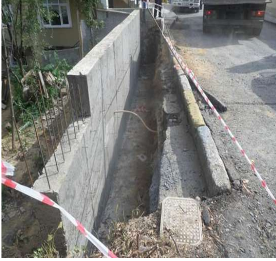
Çubuklu Mah.–NazımTurCad.Betonarme Duvar Yapımı Yapımı
