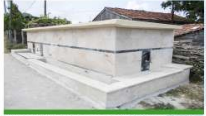
Bağlıca Mahallesi Toramanlar Mevkii Çeşme Tadilatı
