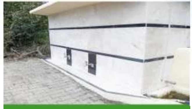
Düğmeciler Mahallesi Ekin Sokak Çeşme Tadilatı
