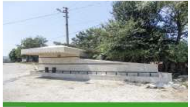
Nebihocalar Mahallesi Gökçeler Mevkii Çeşme Tadilatı
