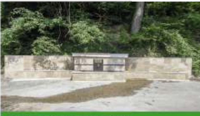
Zeytinburnu Mahallesi Cıvcıoğlu Mevkii Çeşme Tadilatı
