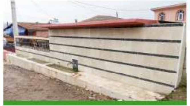
Emirhan Mahallesi Hasanoğlu Mevkii Çeşme Tadilatı
