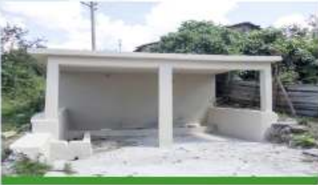
Kaynarca Mahallesi Merkez Çeşme Tadilatı
