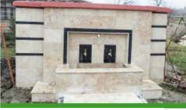
Yassıbağ Mahallesi Mandıra Mevkii Çeşme Tadilatı
