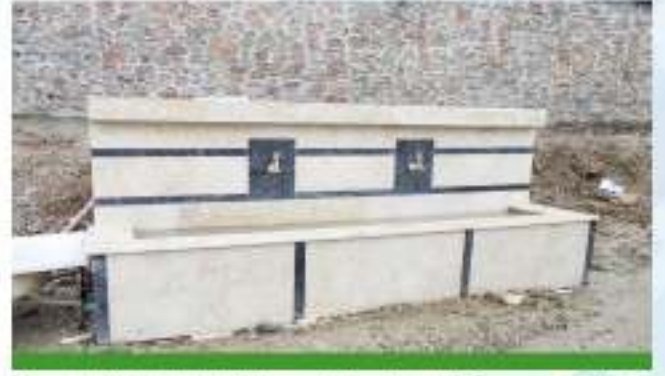
Yassıbağ Mahallesi Kargaköy Mevkii Çeşme Tadilatı
