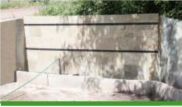
Arpalık İhsaniye Mahallesi Çeşme Tadilatı
