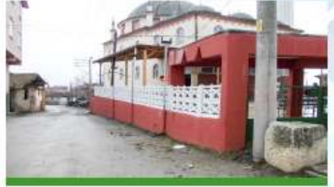
Durhasan Mahallesi Çeşme Tadilatı
