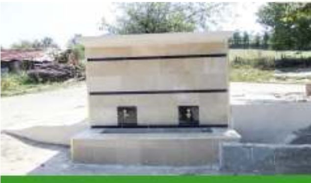
Böğürgen Mahallesi Şahbazlar Mevkii Çeşme Tadilatı
