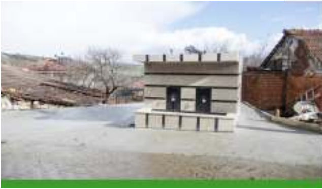
Sekbanlı Mahallesi Çeşme Tadilatı
