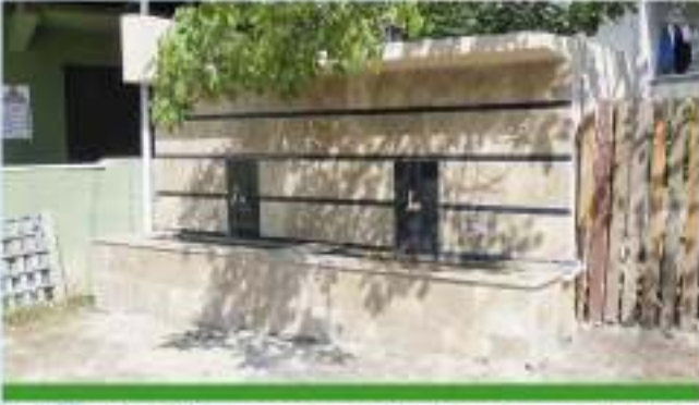
Gedikli Mahallesi Mancarcı Mevkii Cami Yanı Çeşme Tadilatı
