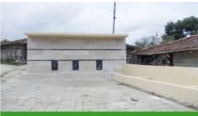
Düğmeciler Mahallesi Merkez Çeşme Tadilatı
