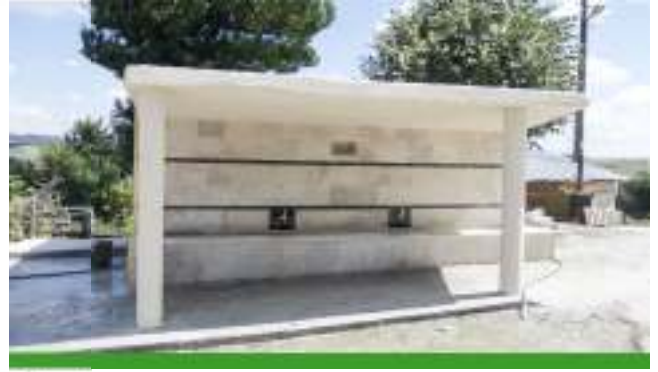
Gökçeören Mahallesi Sadıklar Mevkii Çeşme Tadilatı
