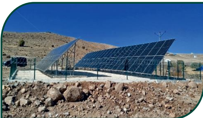
Çemişgezek Doğan köyü GES Yapımı İşi
