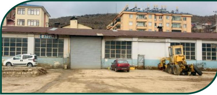
MERKEZ TAMİR ATÖLYESİ
