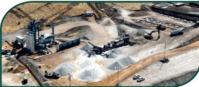
ASFALT PLENTİ ÇALIŞMA ALANI
