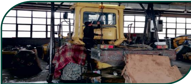
MERKEZ TAMİR ATÖLYESİ
