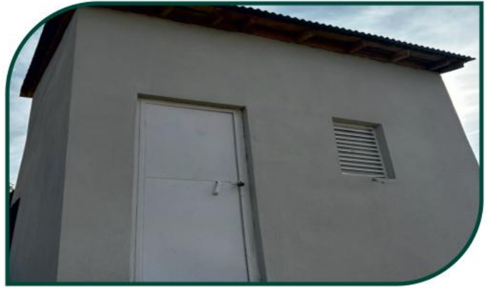
Mazgirt-Akyünlü İçmeSuyu Deposu Onarımı
