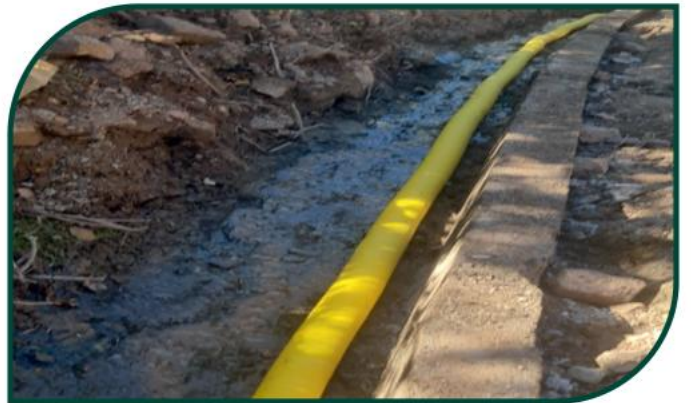
Merkez-Gömemiş-Aş.Kavacık Drenaj Çalışması İşi
