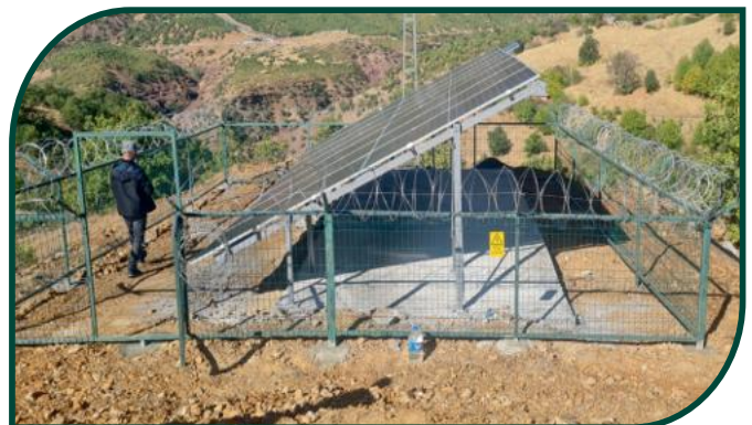
GES Yapımı İşi
