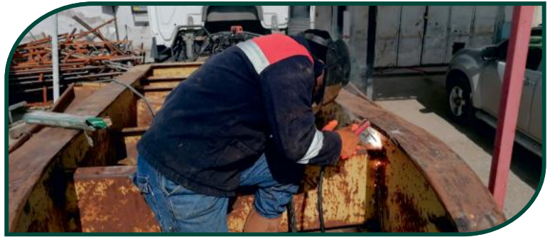
MERKEZ TAMİR ATÖLYESİ
