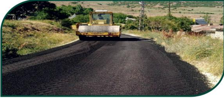
Karşıkonak - Demirci Grup KYY.'da 3 Km Asfalt Yama Çalışmamız Tamamlanmıştır
