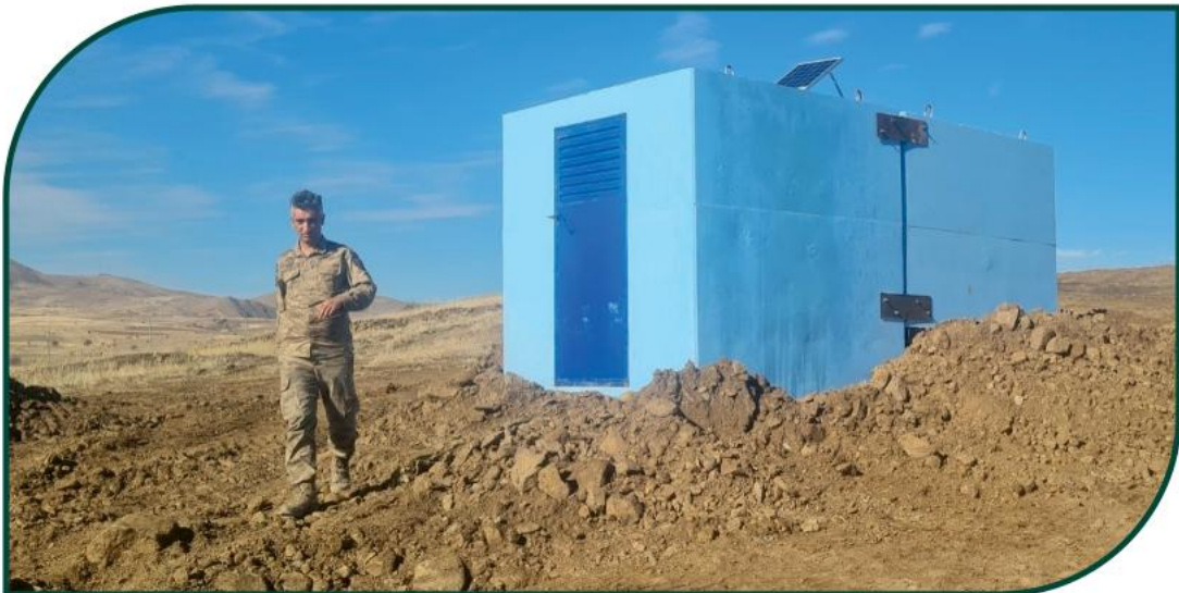
Pınarlar Jandarma Karakolu İçme Suyu Yapım İşİ
