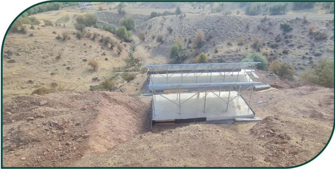
Toratlı GES Yapımı İşİ
