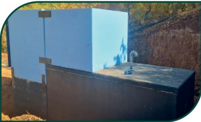
Merkez-Uzuntarla-Tarlabası Mz. 25 Ton Modüler Depo Yapımı İşi
