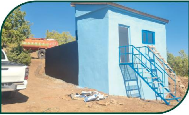
Merkez-Güleç-Erdemli Mz. İçme Suyu Dep. Onarımı
