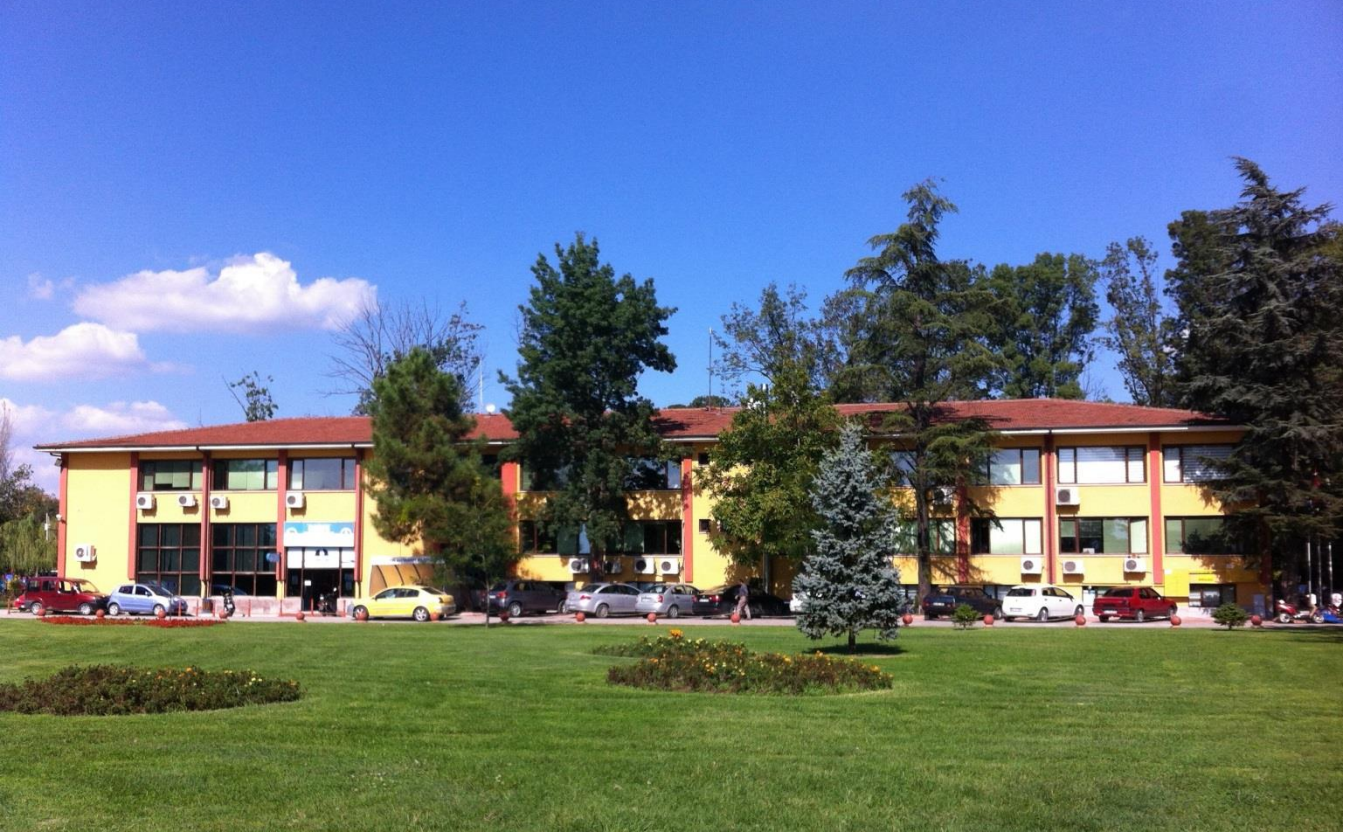
SASKİ Genel Müdürlük Binası
