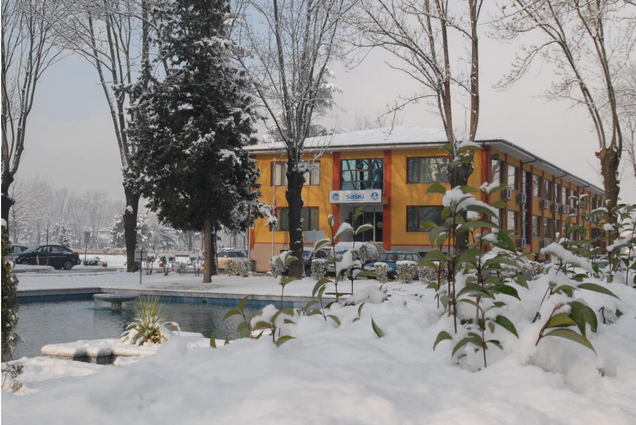
SASKİ Genel Müdürlük Binası
