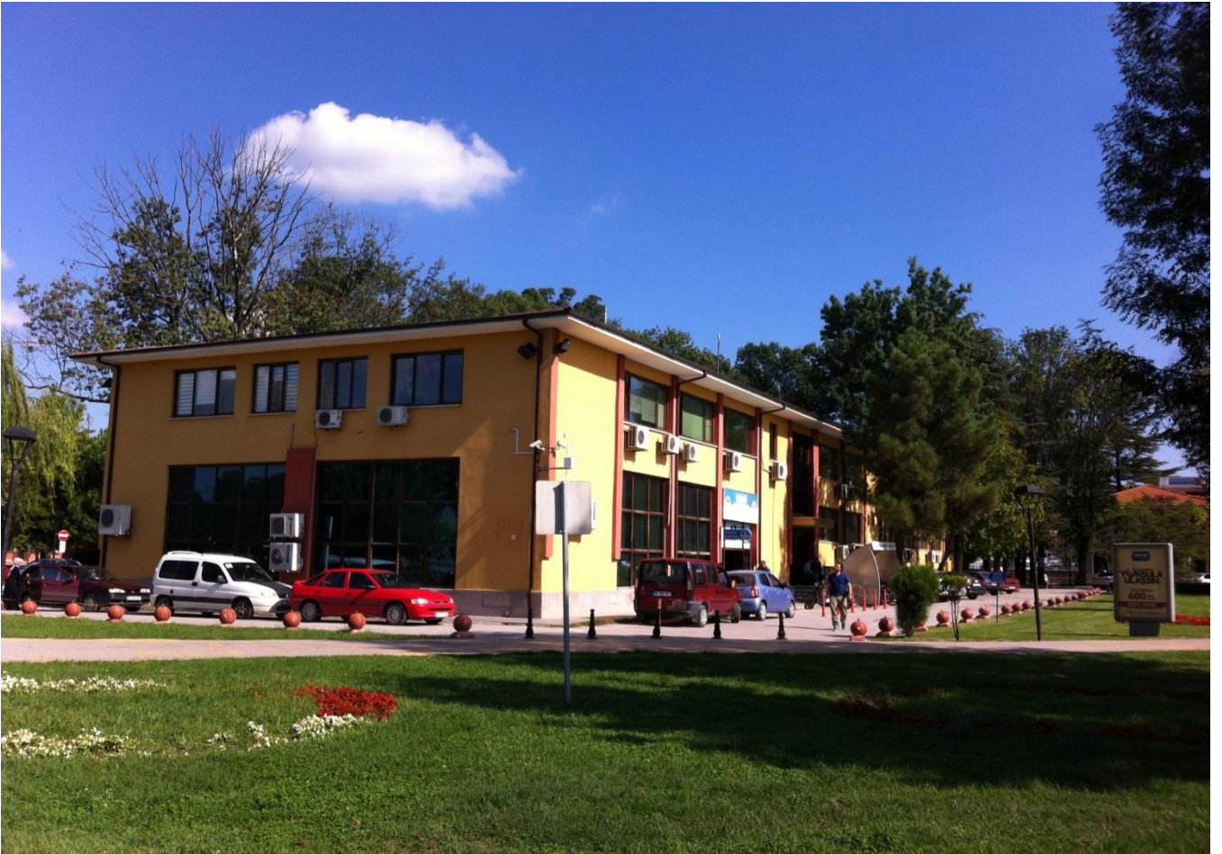
SASKİ Genel Müdürlük Binası
