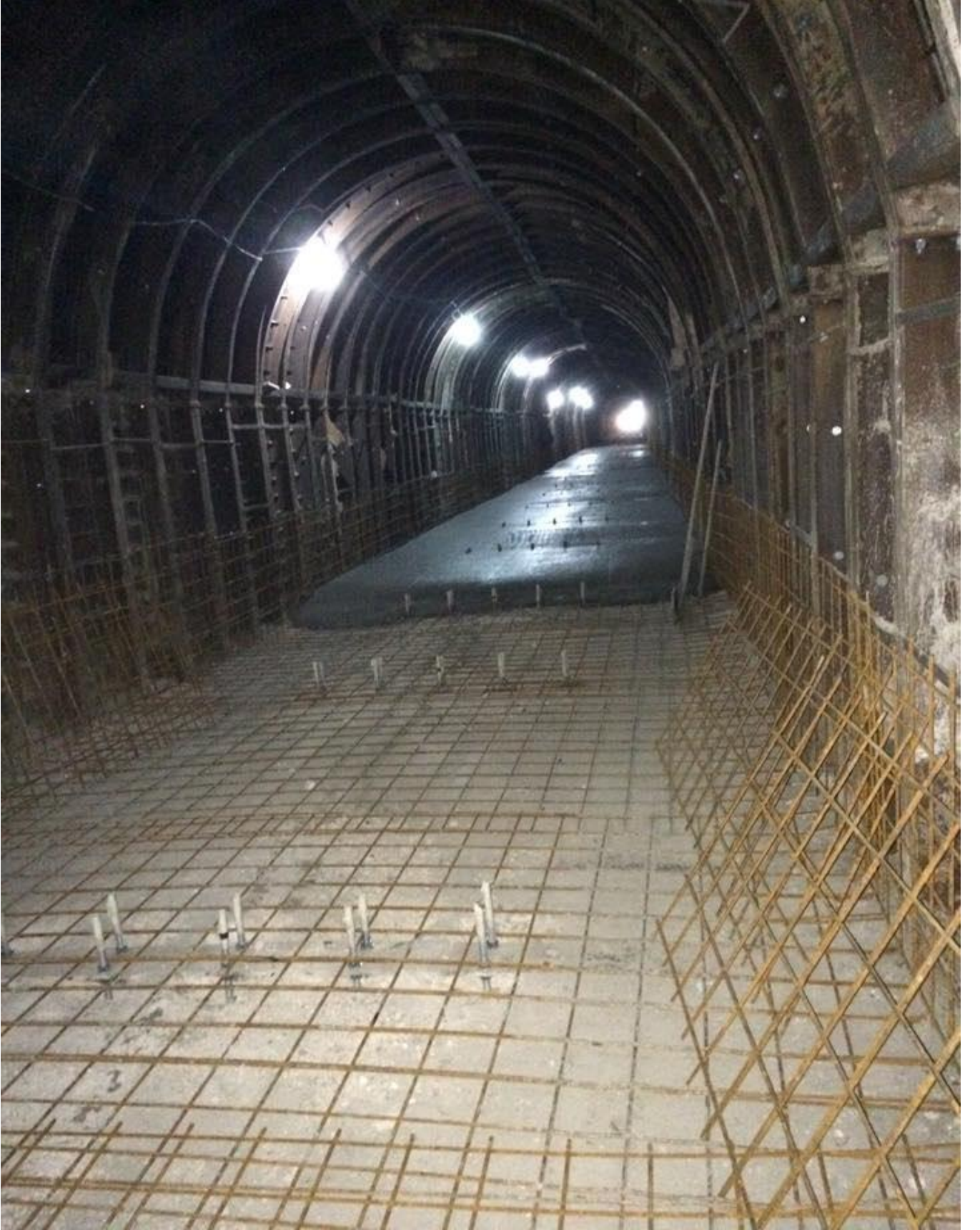
4. İsale Hattı Tünel İnşaatı
