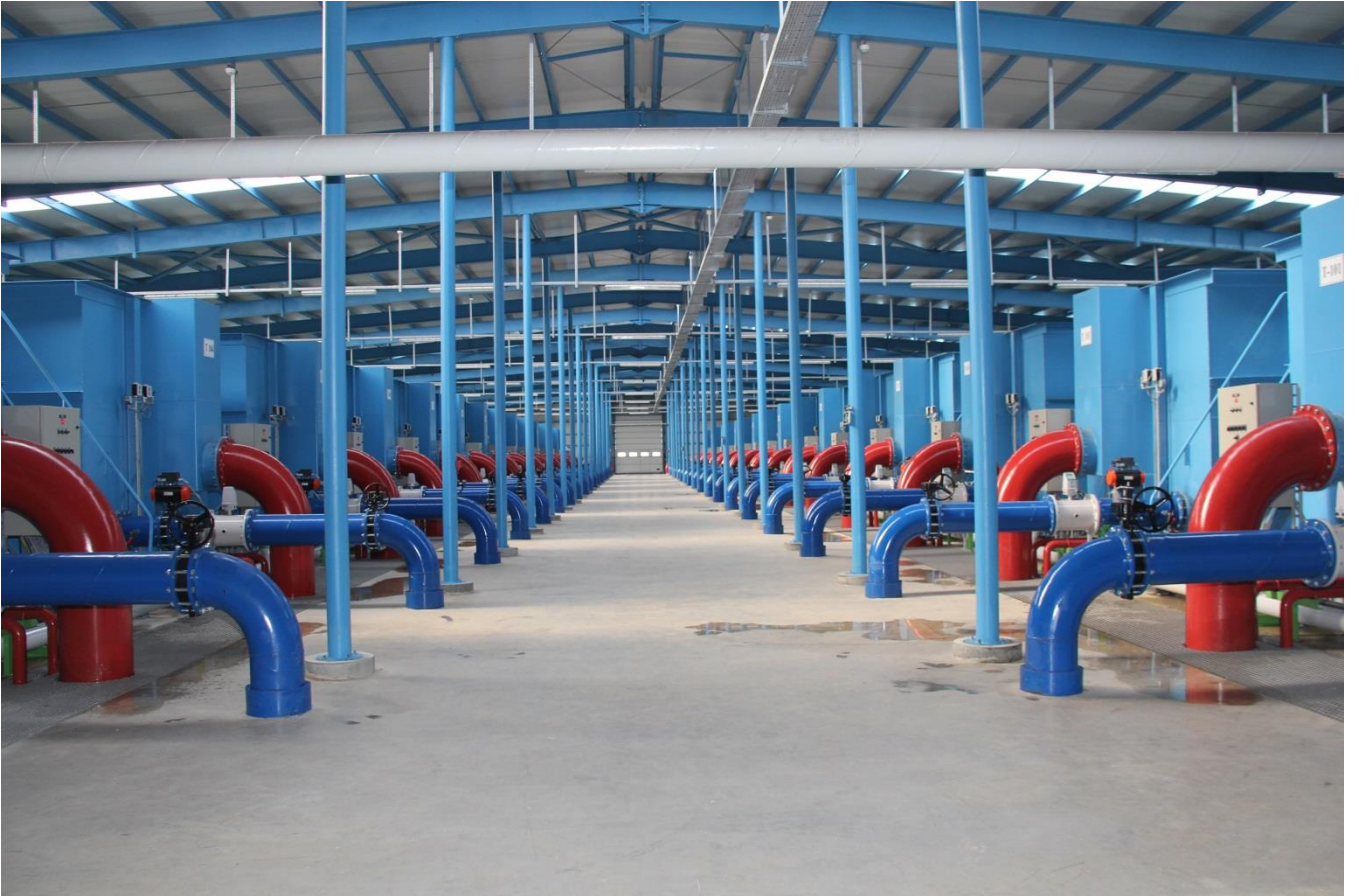
Hızırilyas Arıtma Tesisi
