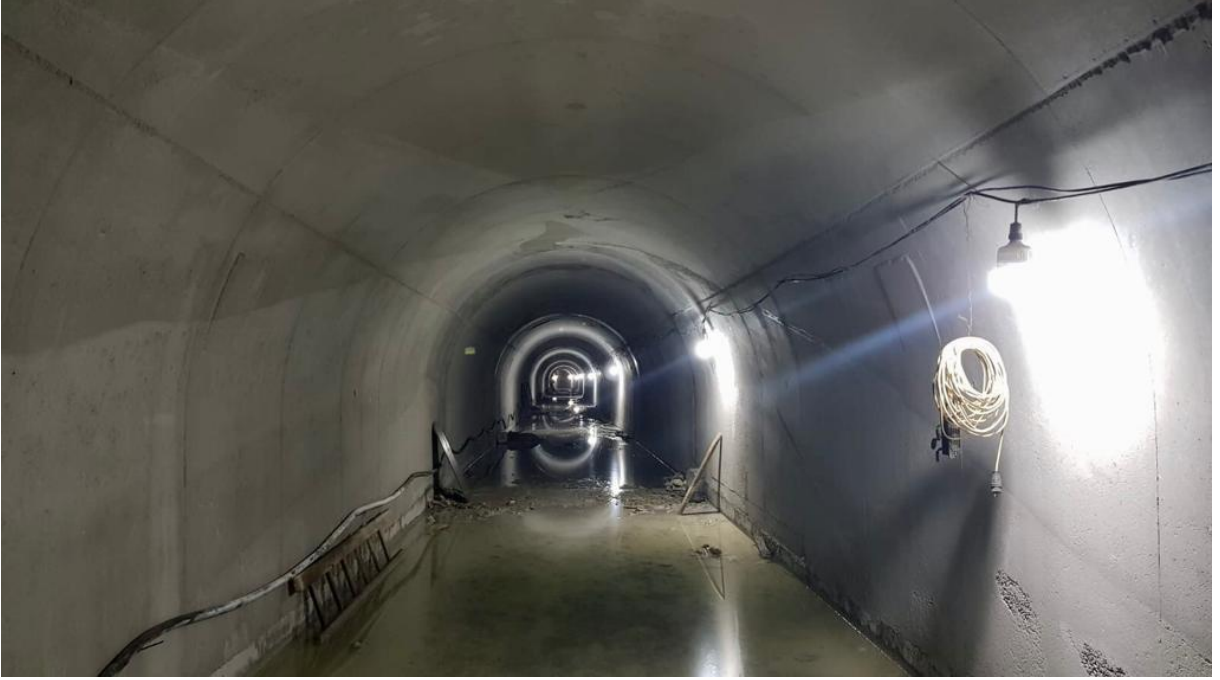
Tünel Kaplama Betonu Görünümü
