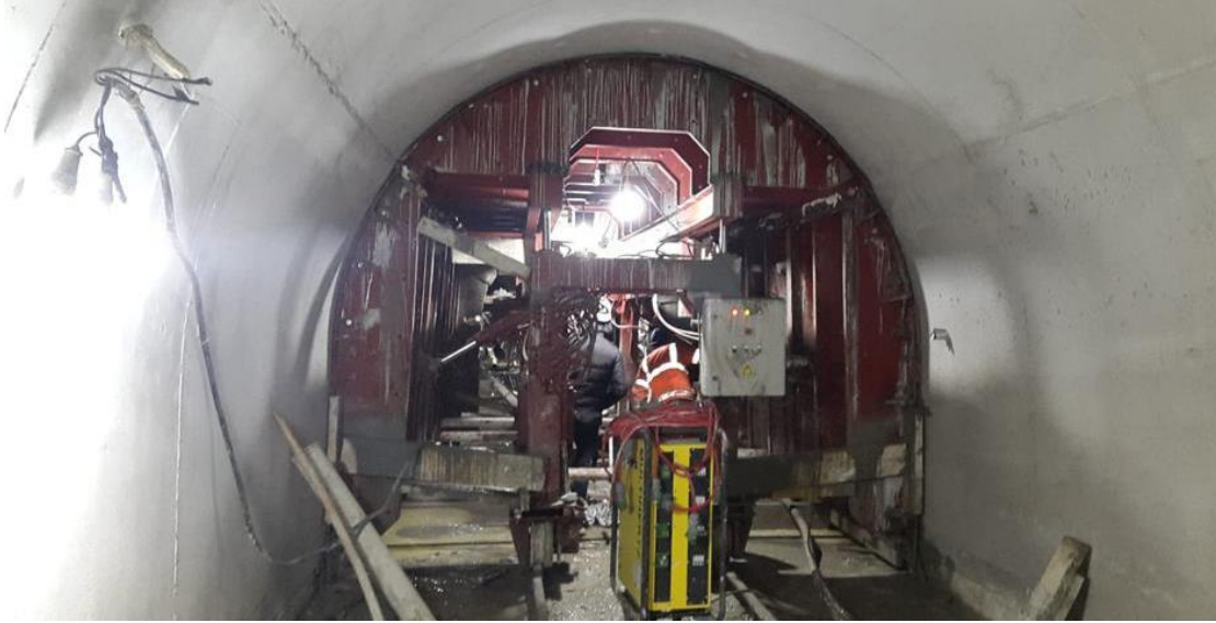
Tünel Kemer Betonu
