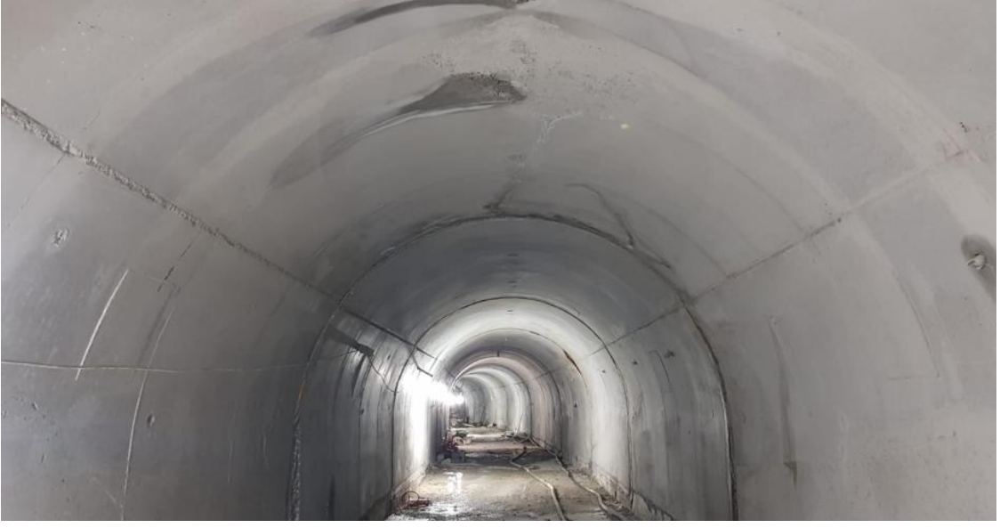
Tünel Kurp Bölgeleri Kaplama Betonundan Görünüş
