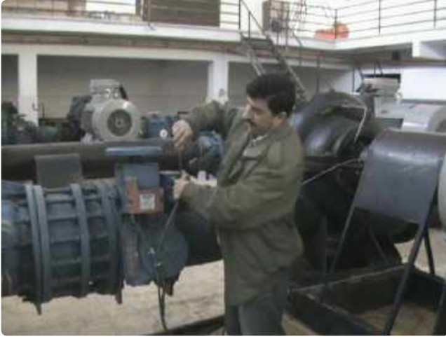
Hasanköy Pompa istasyonumuzda pompa revizyon çalışmaları
