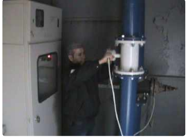
Debimetre sensör ve transmitteri
