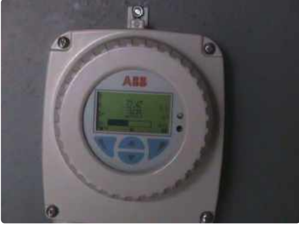
Debimetre sensör ve transmitteri
