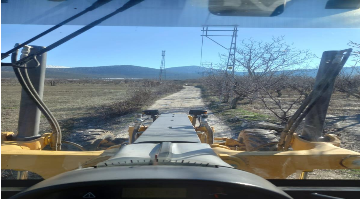
İlçemiz Mahallelerinde Yapılan Reglaj Ve Stabilize Çalışmaları
