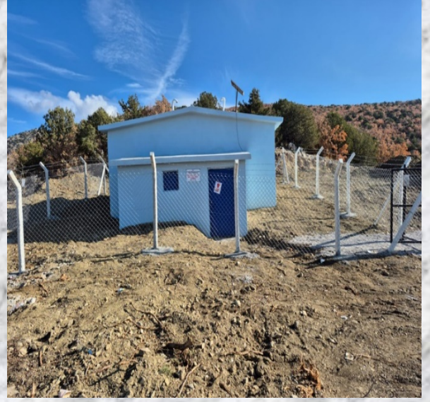
KURTAĞILI KÖYÜİÇME SUYU DEPOSU YAPIM İŞİ
