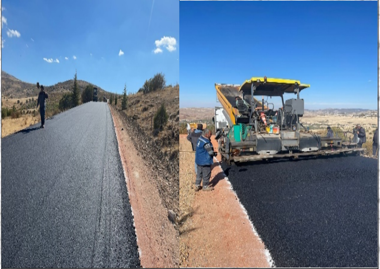
ELÇİ KÖYÜ BSK YOL YAPIM İŞİ
