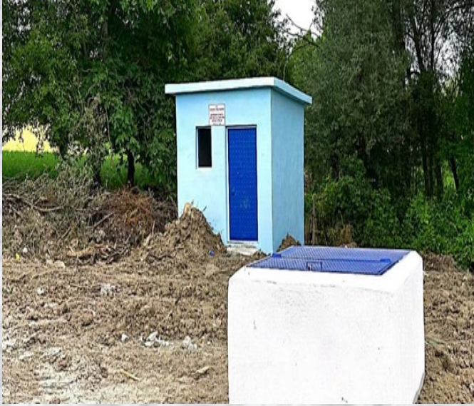
BAYINDIRHÜYÜK KÖYÜ İÇME SUYU DEPOSU YAPIM İŞİ
