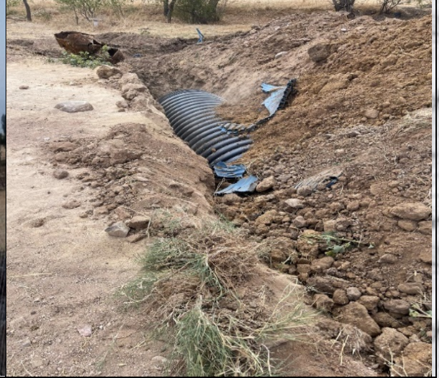
OSMANLI KÖYÜ KANALİZASYON YAPIM İŞİ
