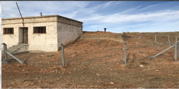
İĞDELİ KÖYÜ İÇME SUYU DEPO ÇALIŞMASI
