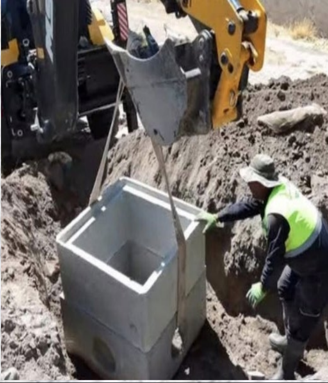
BALTASARILAR KÖYÜ İÇME SUYU HATTI ÇALIŞMALARI YAPIM İŞİ
