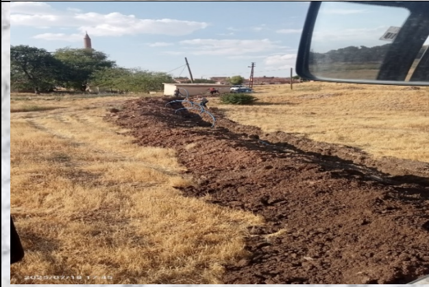
BELÖREN KÖYÜ İÇME SUYU TERFİ HATTI YAPIM İŞİ
