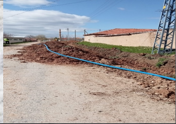
DEVECİPINAR KÖYÜ İÇME SUYU TERFİ HATTI YAPIM İŞİ
