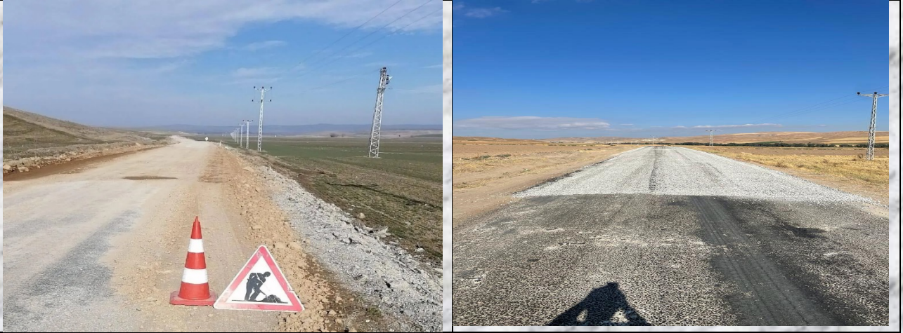
I.KAT ASFALT KAPLAMA YOL ÇALIŞMASI
