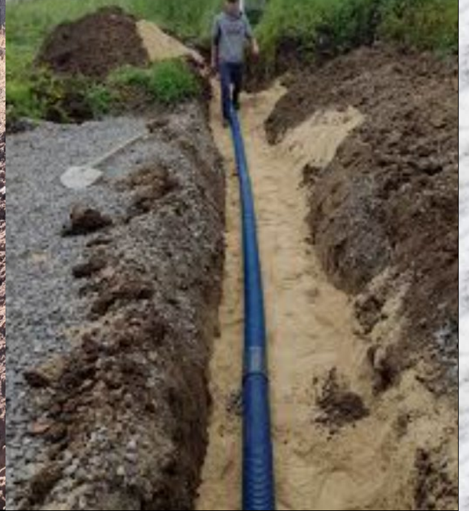
DARICI KÖYÜ TERFİLİ İÇMESUYU TESİSİ YAPIM İŞİ
