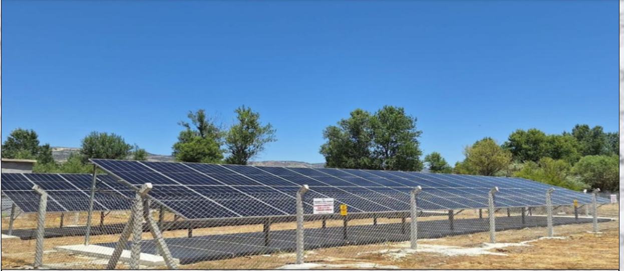
KABALI KÖYÜ GES YAPIM İŞİ
