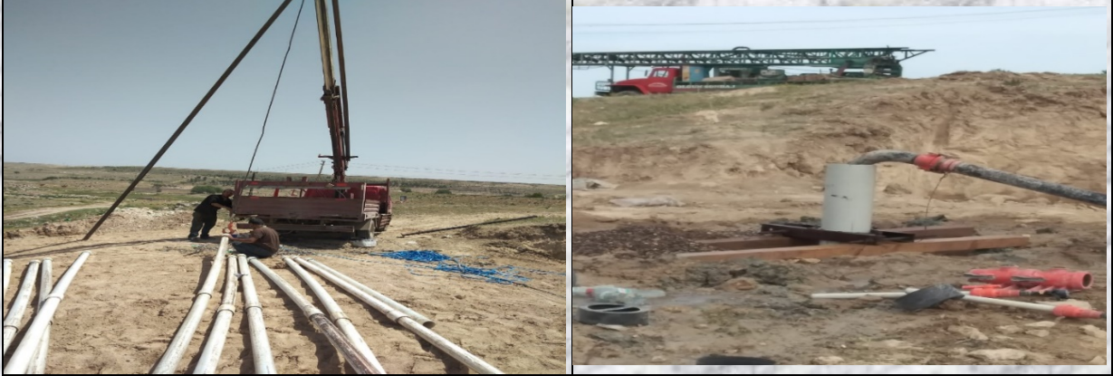
FEHİMLİ KÖYÜNE İÇME SUYU AMAÇLI SONDAJ KUYUSU ÇALIŞMASI
