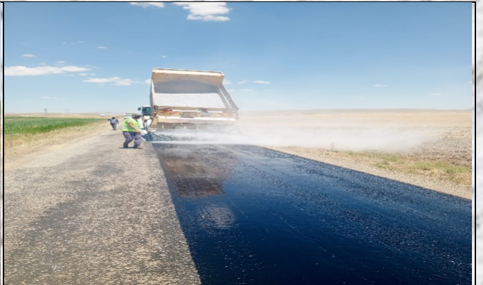
KÖMÜŞÖREN ve AYDINGÜN KÖYLERİ ARASINDA 2. KAT ASFALT ÇALIŞMALARI
