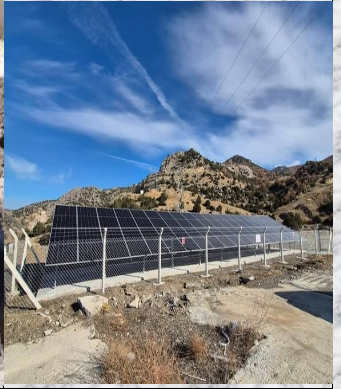
KURTAĞILI KÖYÜ İÇME SUYU GES YAPIM İŞİ
