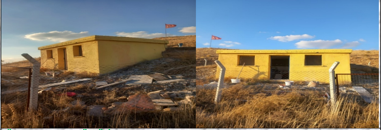
ÜÇ OBALAR KÖYÜ İÇME SUYU DEPO BAKIM ONARIM ÇALIŞMASI
