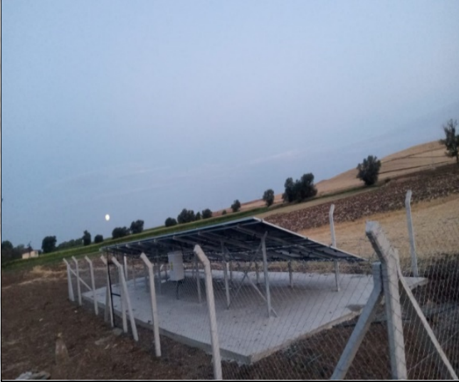
KABAKİNE KÖYÜ İÇME SUYU- GES BAKIM ONARIM YAPIM İŞİ
