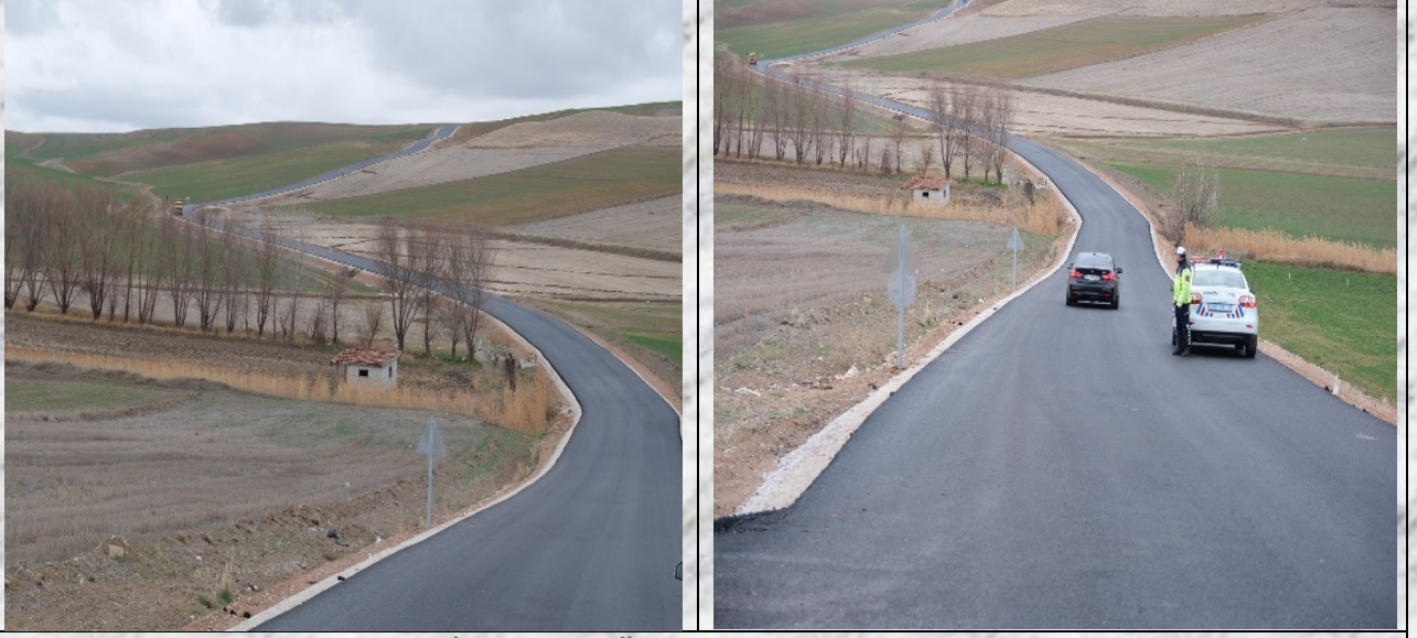
ŞEFAATLİ-PAŞAKÖY BSK YOL YAPIM ÇALIŞMASI
