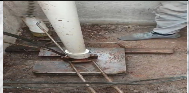
GÜLPINAR KÖYÜ İÇME SUYU SONDAJ ÇALIŞMASI
