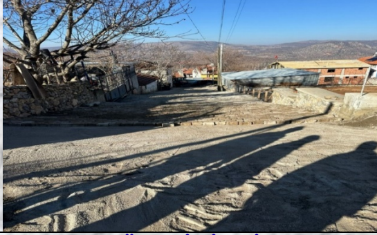
SARIKÖY KİLİTLİ PARKE YAPIM İŞİ
