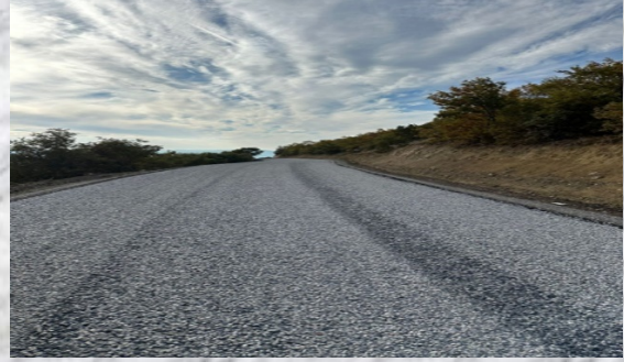
FAKIDAĞI KÖYÜ 1.KAT ASFALT YAPIM ÇALIŞMALARI
