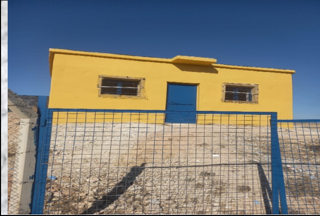
YAZIÇEPNİ KÖYÜ İÇME SUYU DEPO YAPIM İŞİ
