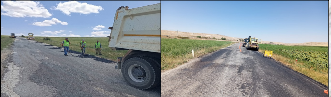
KÖY YOLLARINA ASFALT-YAMA ÇALIŞMASI
