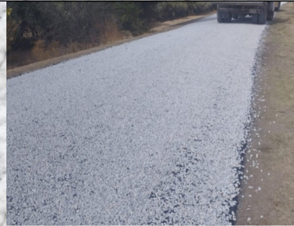
KEMALLI KÖYÜ 2. KAT ASFALT KAPLAMA ÇALIŞMALAR
