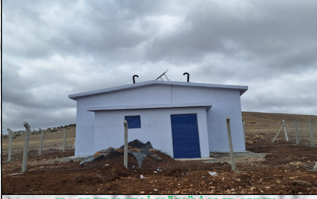
HACIÇEŞMESİ KÖYÜ İÇME SUYU DEPOSU YAPIMI
