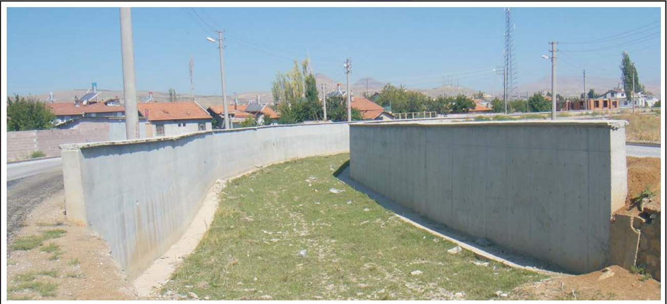
2006 Yılında 534.900 TL'na yaptırılan 1200 m'lik kanal görünüşü
