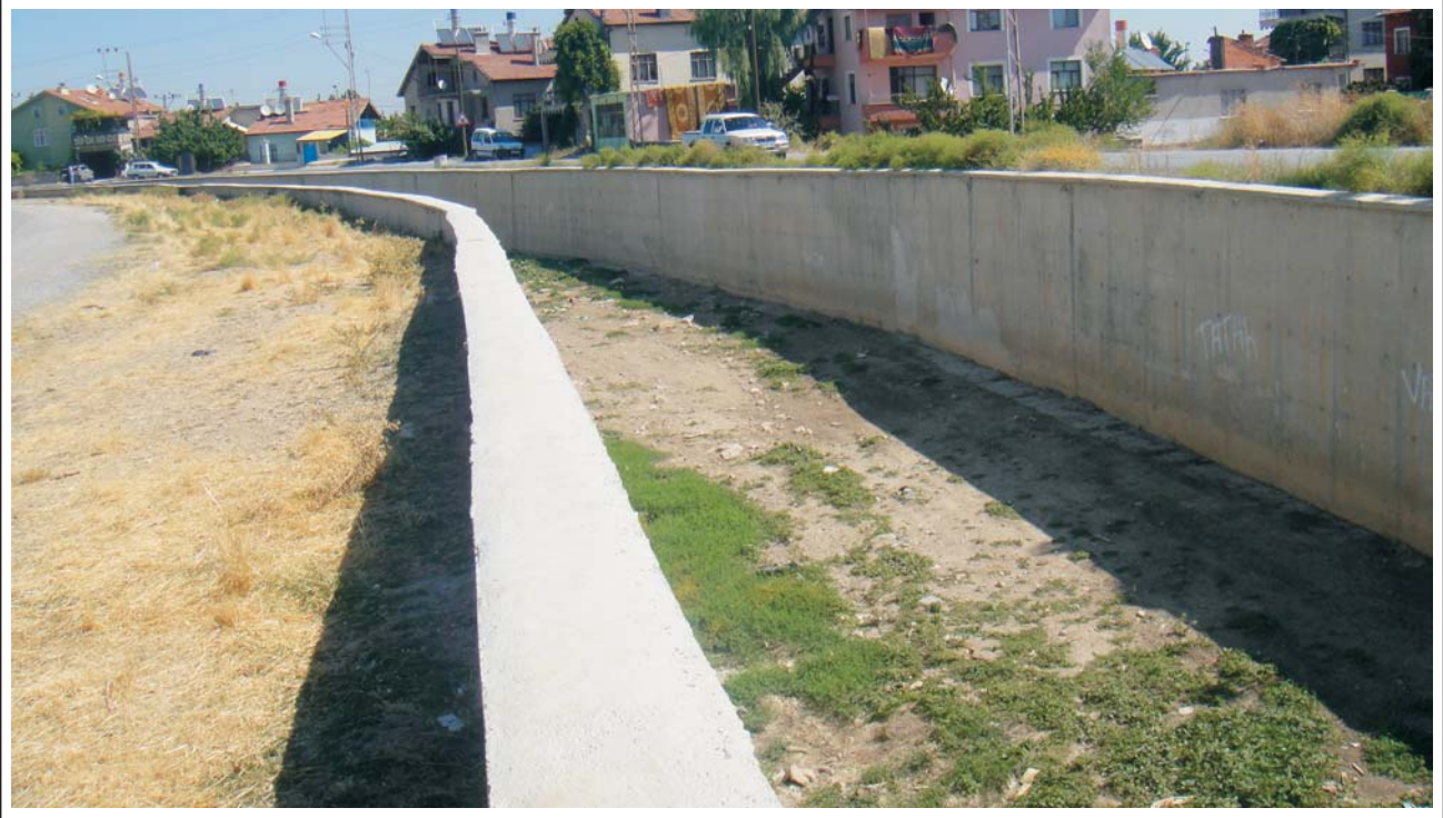
2007 Yılında 2.432.000 TL'na yaptırılan 1300 m'lik kanal görünüşü
