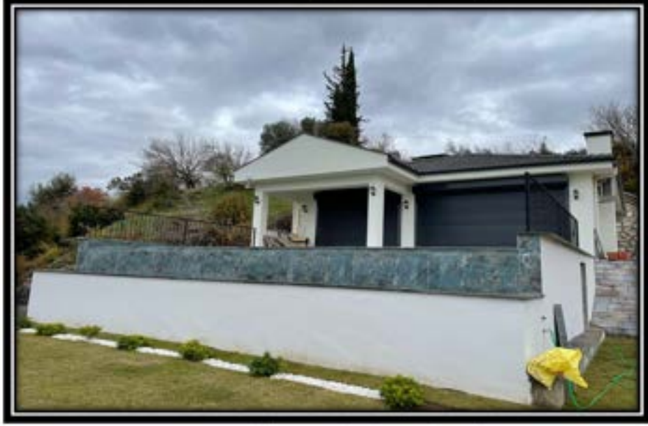
Foto-5: Yapı Kullanma Belgesi Düzenlenmiş Yapı
