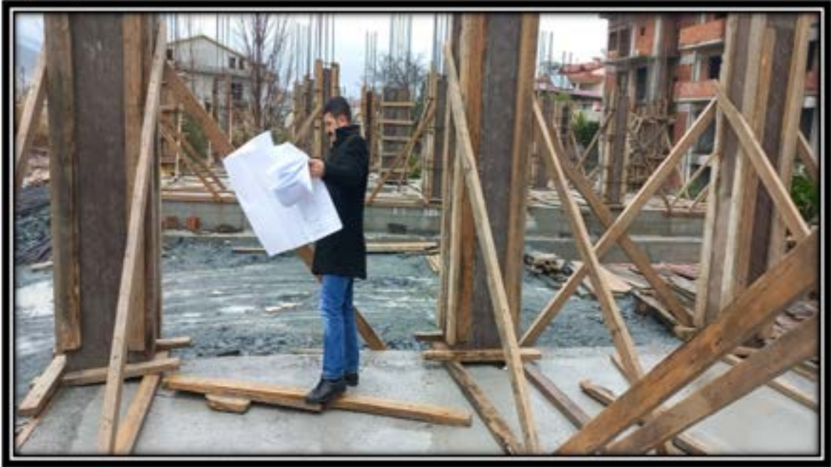
Foto-4: Proje Kontrollerinden Bir Görünüm
