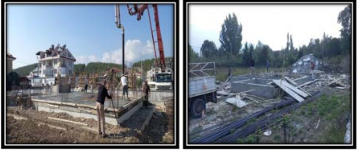
Foto-1: Subasman Kontrolünden Bir Görünüm
