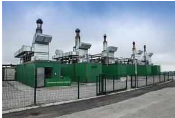
Resim: Metan Gazından Elektrik Üreten Makinalar
