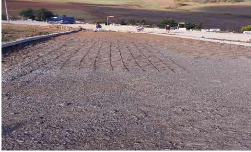
Resim: Mezarlık yolları betonlama çalışmaları
