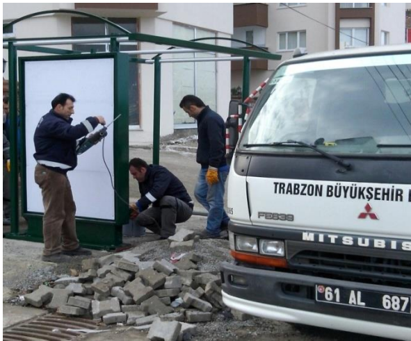
Otobüs Güzergahlarına Cam Durak montajı
