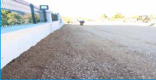
Ocak Taşı ile Yol Yapım ve İyileştirme Çalışması
