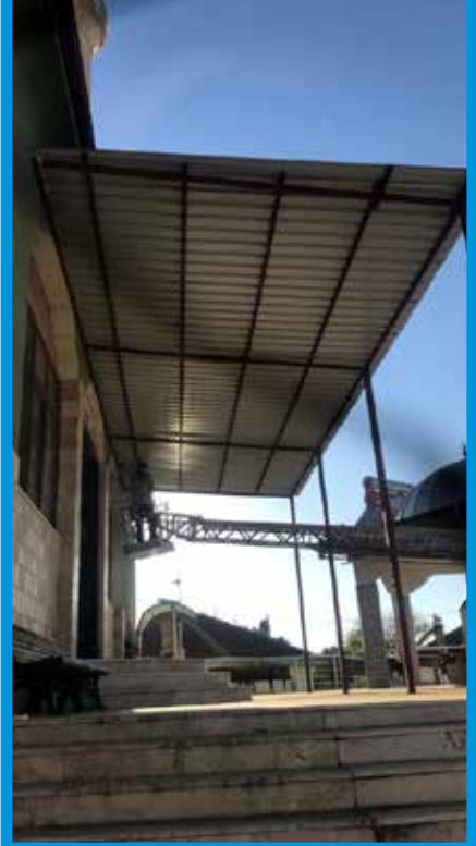
Küçükdere Mahallesi Küçükdere Cami Önü Sundurma Yapımı
