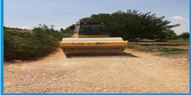
Ocak Taşı ile Yol Yapım ve İyileştirme Çalışması
