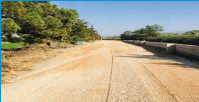
Ocak Taşı ile Yol Yapım ve İyileştirme Çalışması
