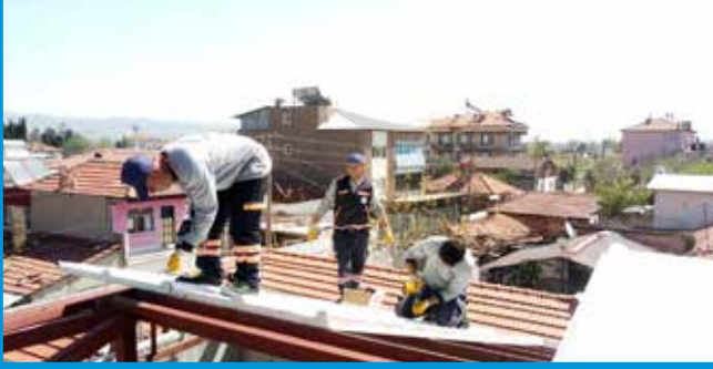
Korucuk Mahallesi Yangında Zarar Gören Evin Sıva - Çatı Tadilatının Yapılması
