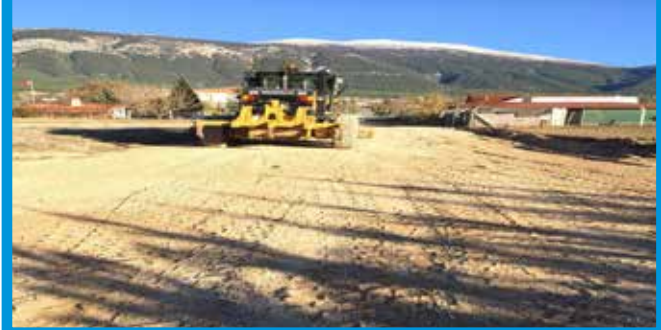
Ocak Taşı ile Yol Yapım ve İyileştirme Çalışması
