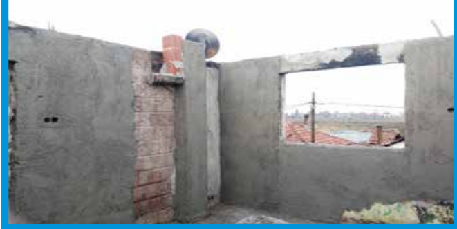
Korucuk Mahallesi Yangında Zarar Gören Evin Sıva - Çatı Tadilatının Yapılması
