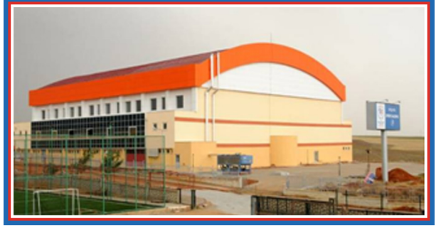
Kırşehir Merkez Spor Salonu
