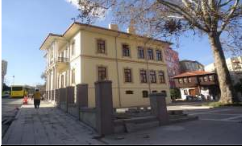
TARİHİ BELEDİYE BİNASININ RESTORASYONU ASLINA UYGUN ŞEKİLDE YAPILMIŞTIR.
