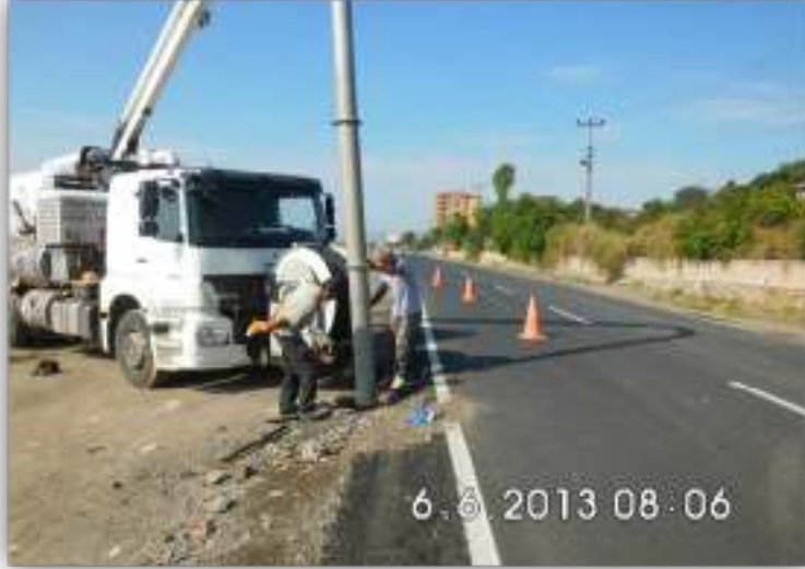
Sahil dolgu sahada bulunan \varnothing 1000 - \varnothing 1200 mm \varnothing aplarında atıksu kollektör hattının temizlik işlemleri kombine araçla yapıldı.
