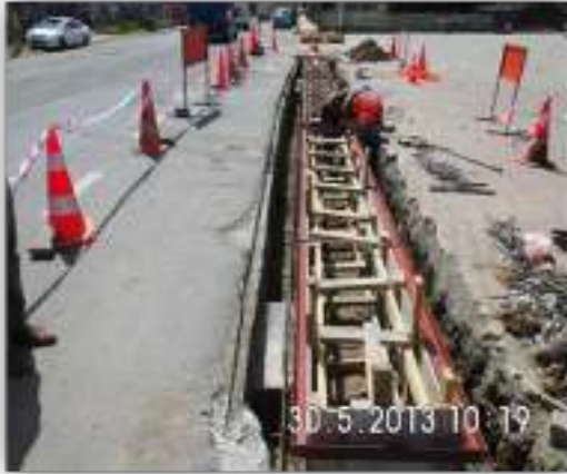
Şehrin ihtiyaç duyulan yerlerinde yağmursuyu alıcı mazgal imalatları yapıldı.
