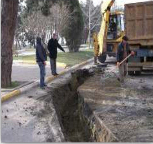
Hürriyet mahallesi otogar yanı içme suyu şebeke ilave çalışmaları yapıldı.
