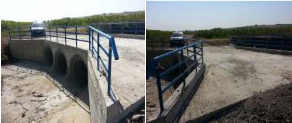
Şehrimizin içme suyu ihtiyacının bir bölümünü karşılayan çorlu, sağlık mahallesi sarılar mevkiinde bulunan çorlu su kuyularına ulaşımı sağlayan yol üzerinde, menfez imalatı gerçekleştirilmiştir.
