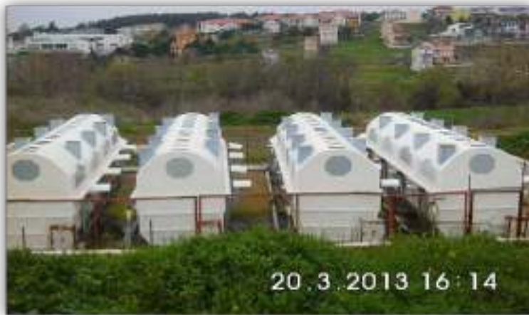
Toki 1. bölge konutlarındaki paket arıtma tesisi bakım ve onarım çalışmaları yapıldı.
