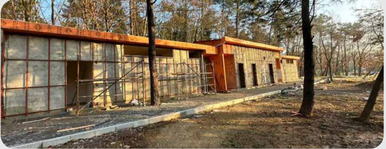
Fotoğraf 12: Güngören Sosyal Tesisleri, Mescit ve WC Yapım İşi
