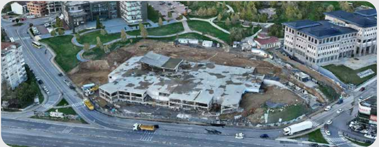
Fotoğraf 17: Kapalı Otopark Yapım İşi
