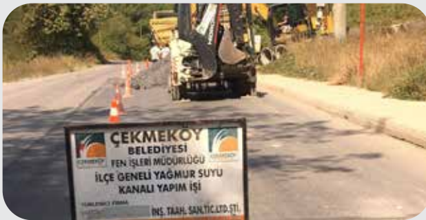
Fotoğraf 25: Yağmur Suyu Kanal Yapımı
