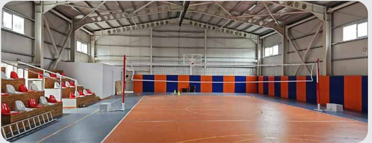
Fotoğraf 13: Kapalı Spor Salonları Yapım İşi
