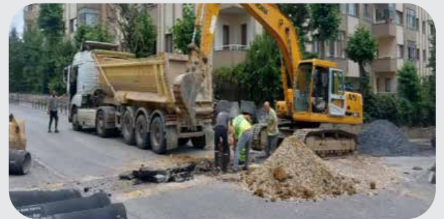
Fotoğraf 25: Yağmur Suyu Kanal Yapımı
