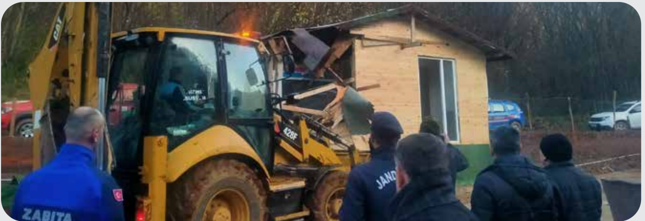
Fotoğraf 94: Kontrollü Yıkım Çalışması
