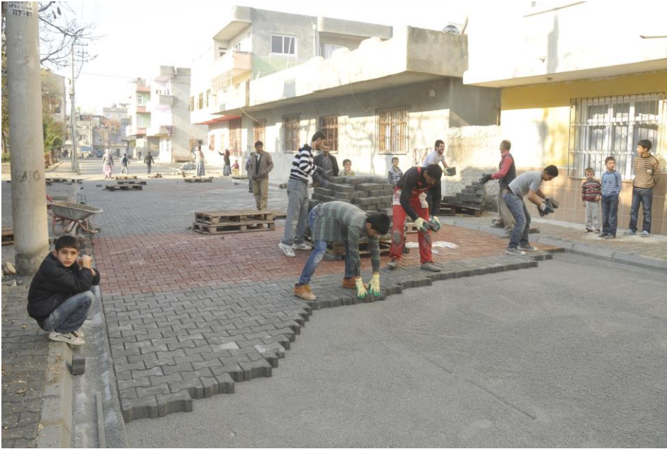
Yol ve Kaldırım Düzenleme çalışması
