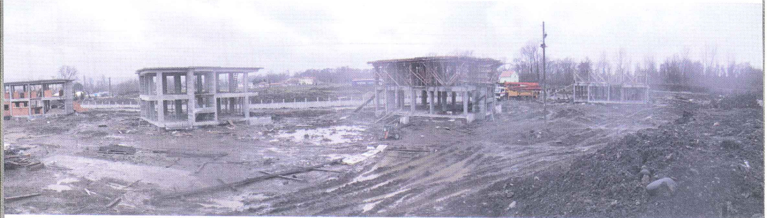
Sevgi Evleri İnşaatı
