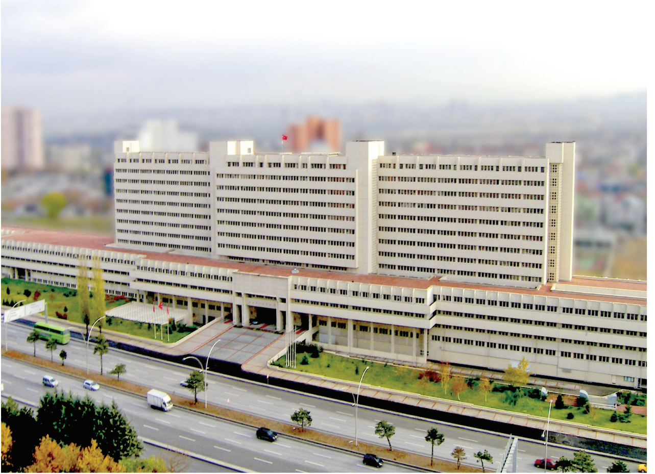
Sayıřtay Hizmet Binası
