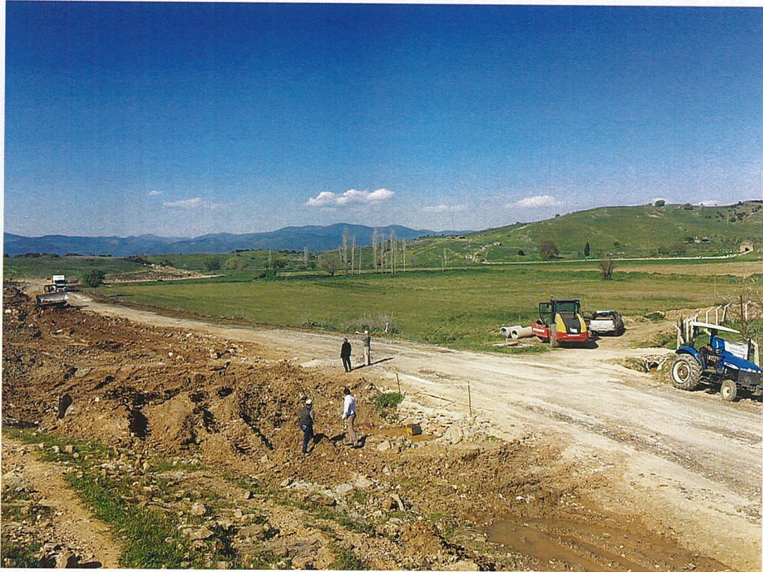
Işıklar ve Ayaklıkırı Arası Asfalt Yenileme Çalışmaları 3 Nisan
