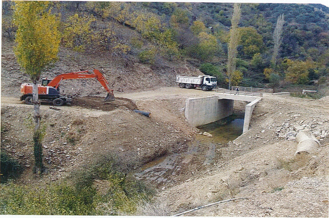
Köy (Mahalle) Yolları Çalışmaları 26 Kasım 2015
