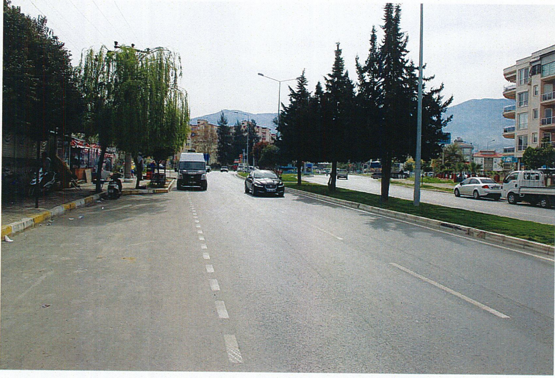
İstasyon Caddesi Asfaltlama Çalışmaları 22 Nisan
