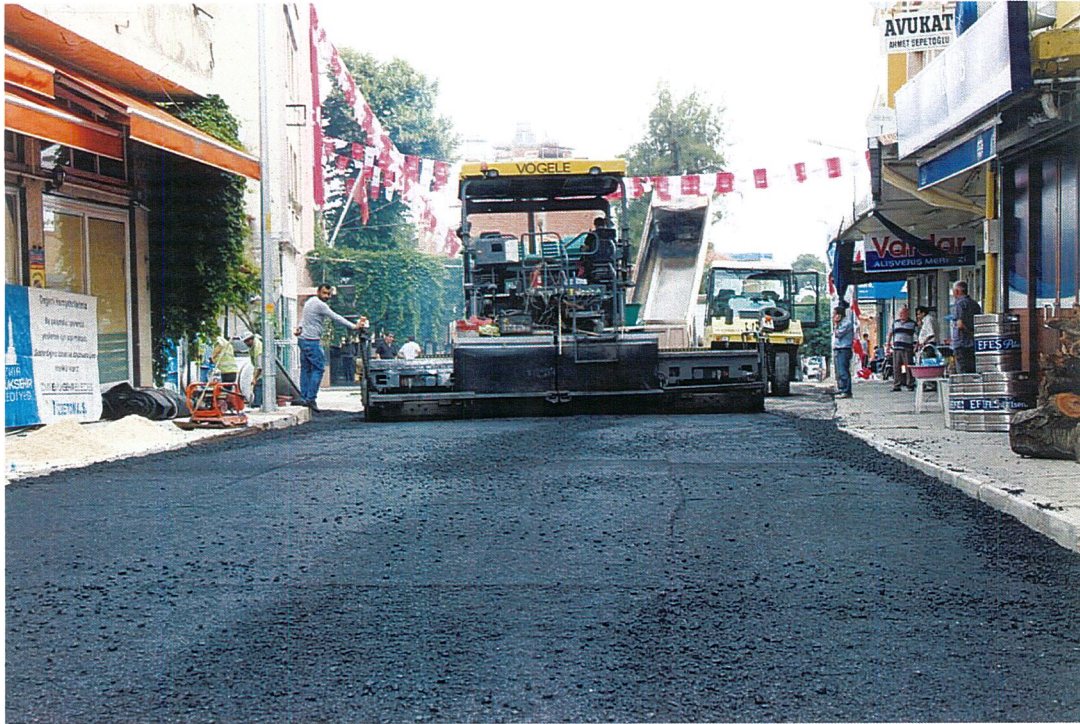
Fevzi Paşa Caddesi Asfaltlama Çalışmaları 4 Haziran 2015
