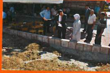
29.07.2011 Eski Buğday Pazarı Pazarı Yapımı İncelemeleri
