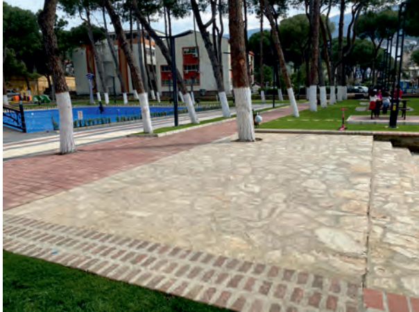
■ Atatürk Parkı-İstasyon Caddesi Yapımı
