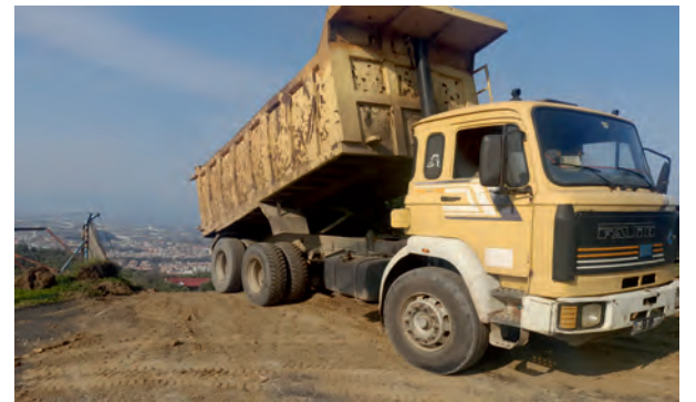
■ Bahariye Mahallesi Kaplan Yolu Arası Yol Düzenlemesi
