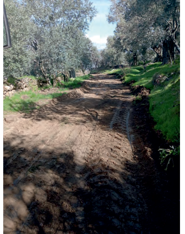
■ Alaylı Köy Yolu Yapımı 2 15.03
