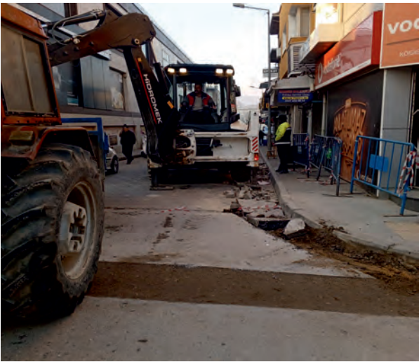
■ Beldiye Hanı Kazı İşlemi (elektrik için)
