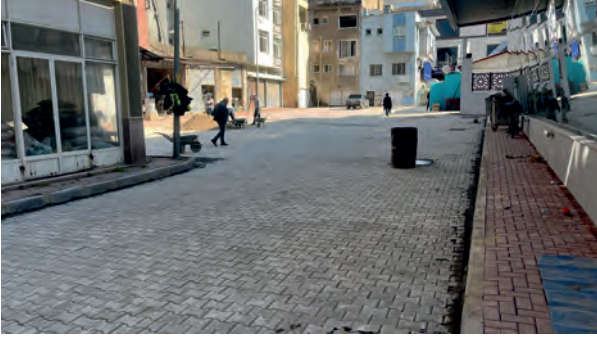
■ Balık Hali Arkası Taş Döşemesi.
