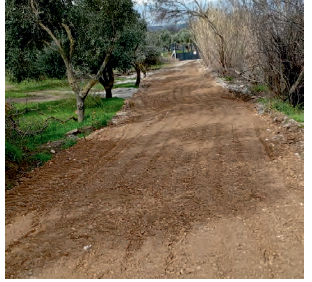
■ Balım Sultan Yan Yol Dolgusu Tesviye İş.
