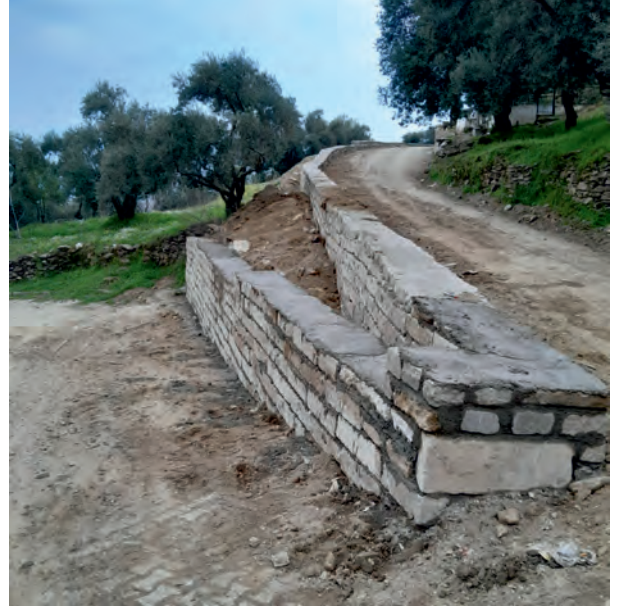
■ Buğday Dede Mahallesi Duvar İş.
