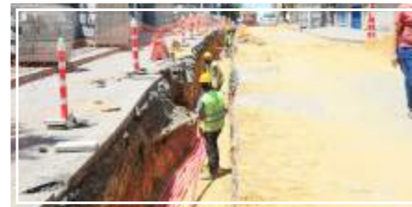
Yeraltı Kablo İmalatı
