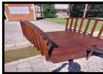
DEĞİRMEN KAFE AHSAP KÖPRÜ BOYAMASI YAPILDI.
