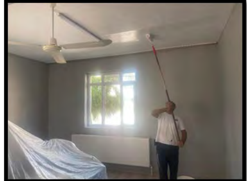
AĞAKÖY ANAOKULU İÇ DUVAR BOYAMASI
