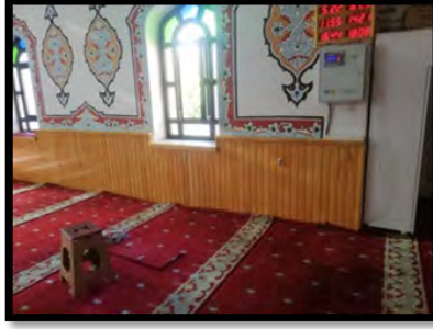
KARAHIDIR CAMİ AHŞAP SIRTLIK YAPIMI VE MONTAJI YAPILDI.
