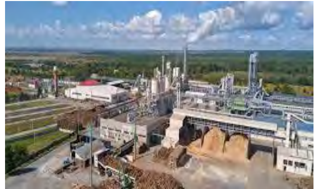
RESİM 4: Faal Olarak Çalışan Örnek Biyogaz Tesisi
