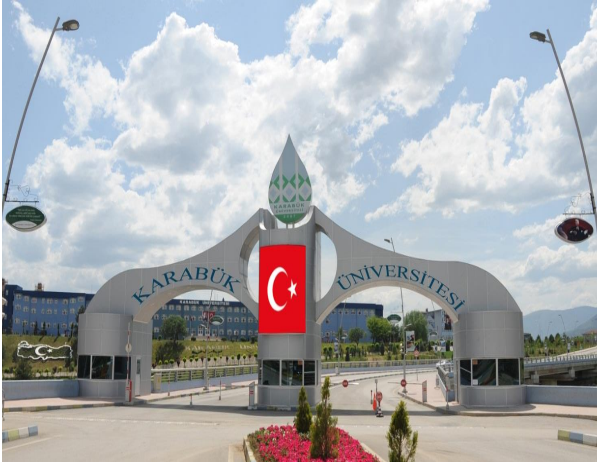
Resim 1. Karabük Üniversitesi Demir Çelik Yerleşkesi
