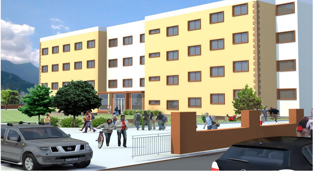
Resim 6. Yapımı Devam Yenice Meslek Yüksekokulu Binası
