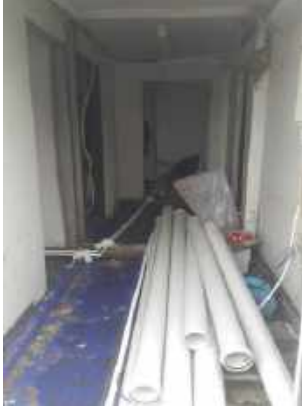
Kalıcı Konutlar Müfreze; Su Tesisatı Döşeme İşi
