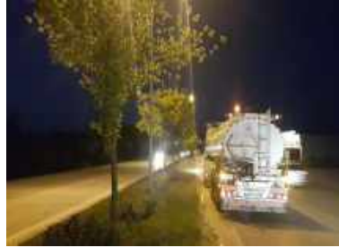
Bağlantı Yolu Sulama Çalışması
