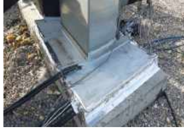
Terminal Çatı Baca Dibi Lokal Poliüretan Uygulaması
