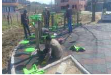
Çakırlar Mahallesi Fitness Aleti Montajı
