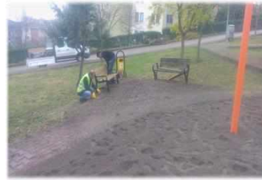
Kalıcı Konutlar Genelinde Bank Montajı
