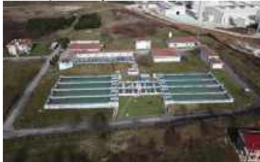
İçme Suyu Arıtma Tesisi
