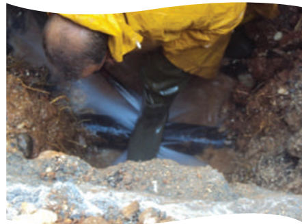
3.03.2012 PORTAKAL MAHALLESİ 80009 SOKAK
