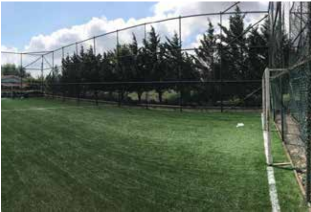
Yeşiltepe Parkı halı saha zemini yenilenmesi
