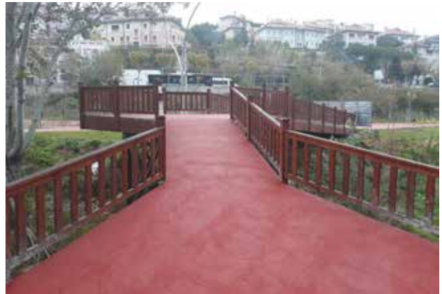
Gölet Köprüsü EPDM kaplama işi
