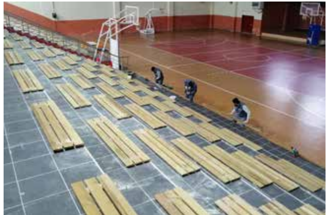
Ahşap Oturak İmalat ve Montaj
