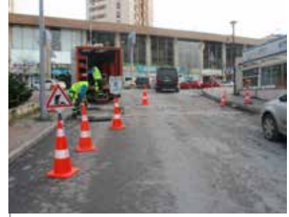
Başakşehir Temmuz Sokak kauçuk hız kesici imalatı
