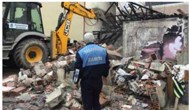
Metruk Yapı Yıkım Çalışması
