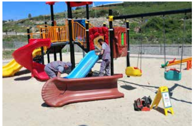
Çocuk Oyun Grubu Bakım/Onarım Çalışması
