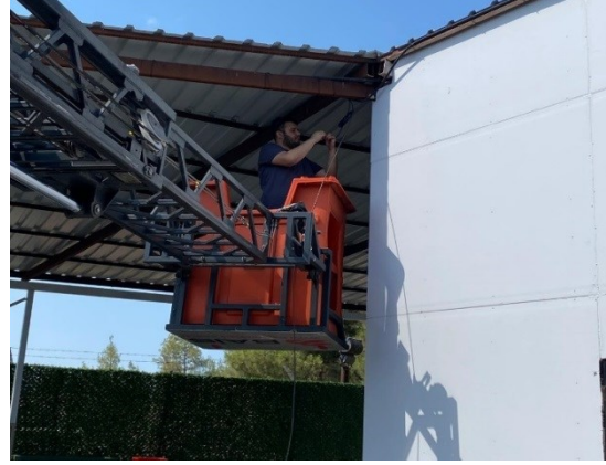
Atık Getirme Merkezi
