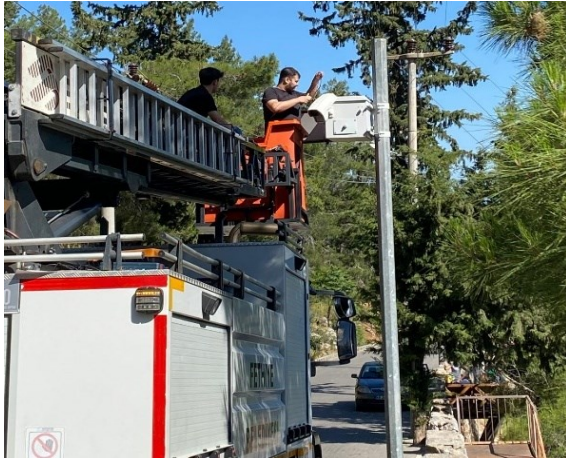
Mevcut Kameraların Bakım ve Onarımı
