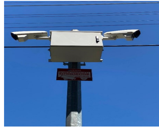
Mevcut Kameraların Bakım ve Onarımı
