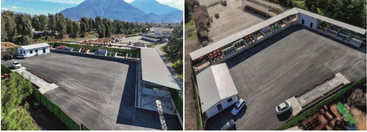
Atık Getirme Merkezi
