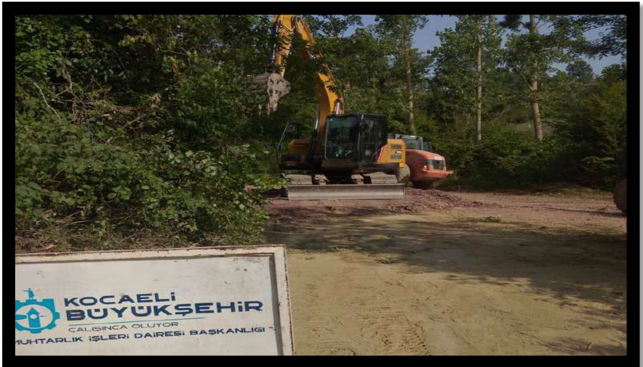
Sepetçi Mahallesi Sakallar Mevkii Stabilize İmalat Çalışması
