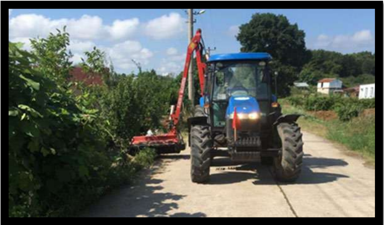
Çamkonak Mahallesi Çalı Canavarı Çalışması
