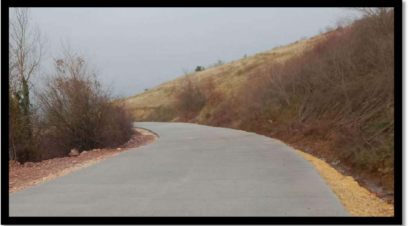
Pirceler Mahallesi Beton Yol İmalat Çalışması
