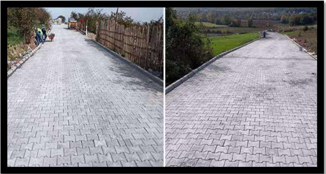
Kefken Mahallesi Parke İmalat Çalışması
