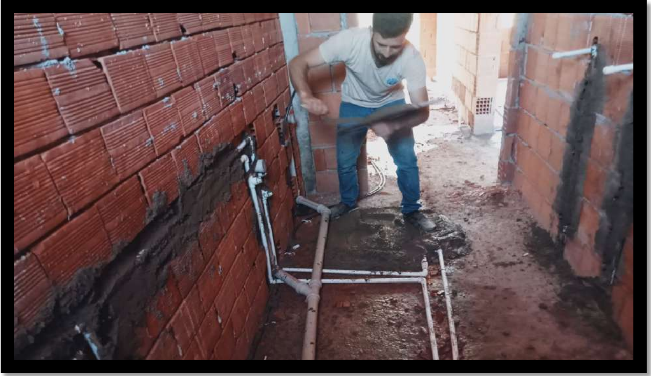
Akbal Mahallesi Köy Konağı Su Tesisatı Çalışması
