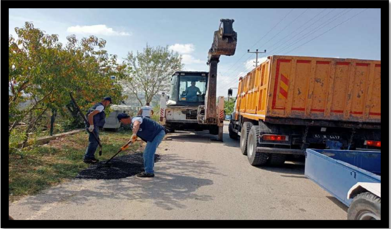
Hacıseyh Mahallesi Asfalt Bakım Onarım Çalışması
