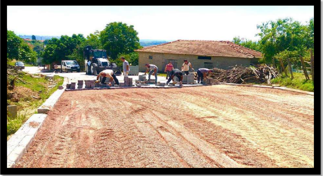
Alefli Mahallesi Parke İmalat Çalışması
