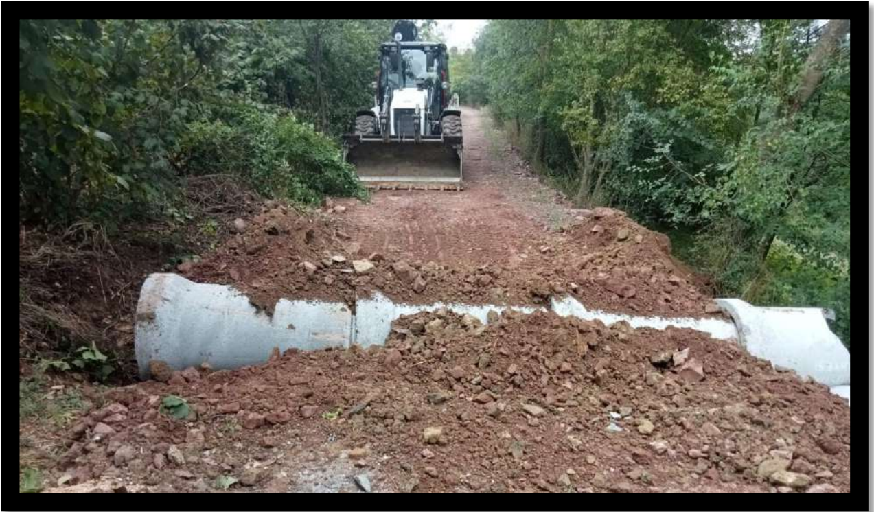
Sinanlı Bilalli Mahallesi Büz Koyma Çalışması
