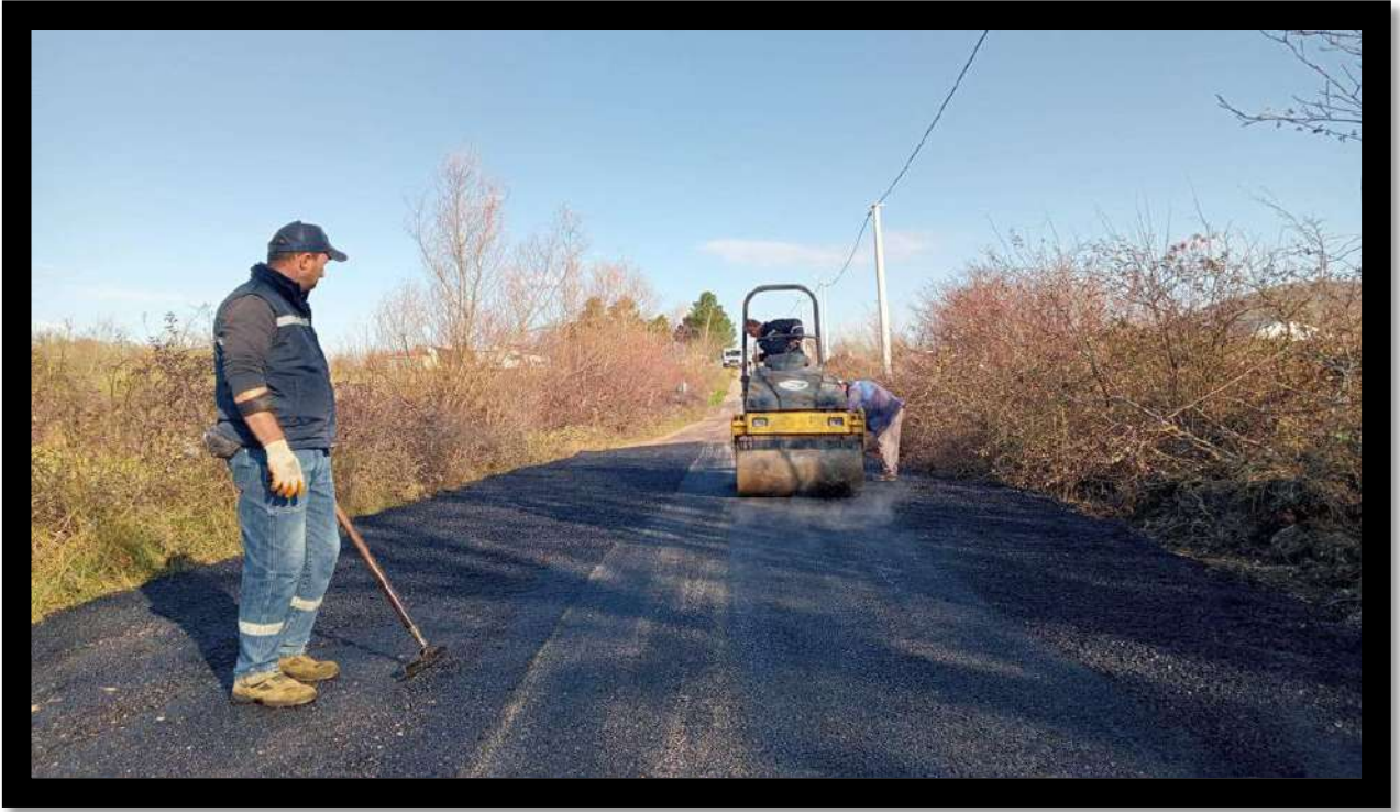
Topluca Mahallesi Asfalt Bakım Onarım Çalışması
