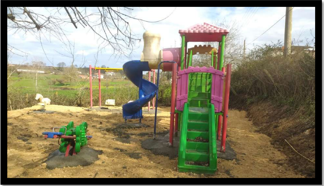
Duraklı Mahallesi Oyun Grubu Montaj Çalışması
