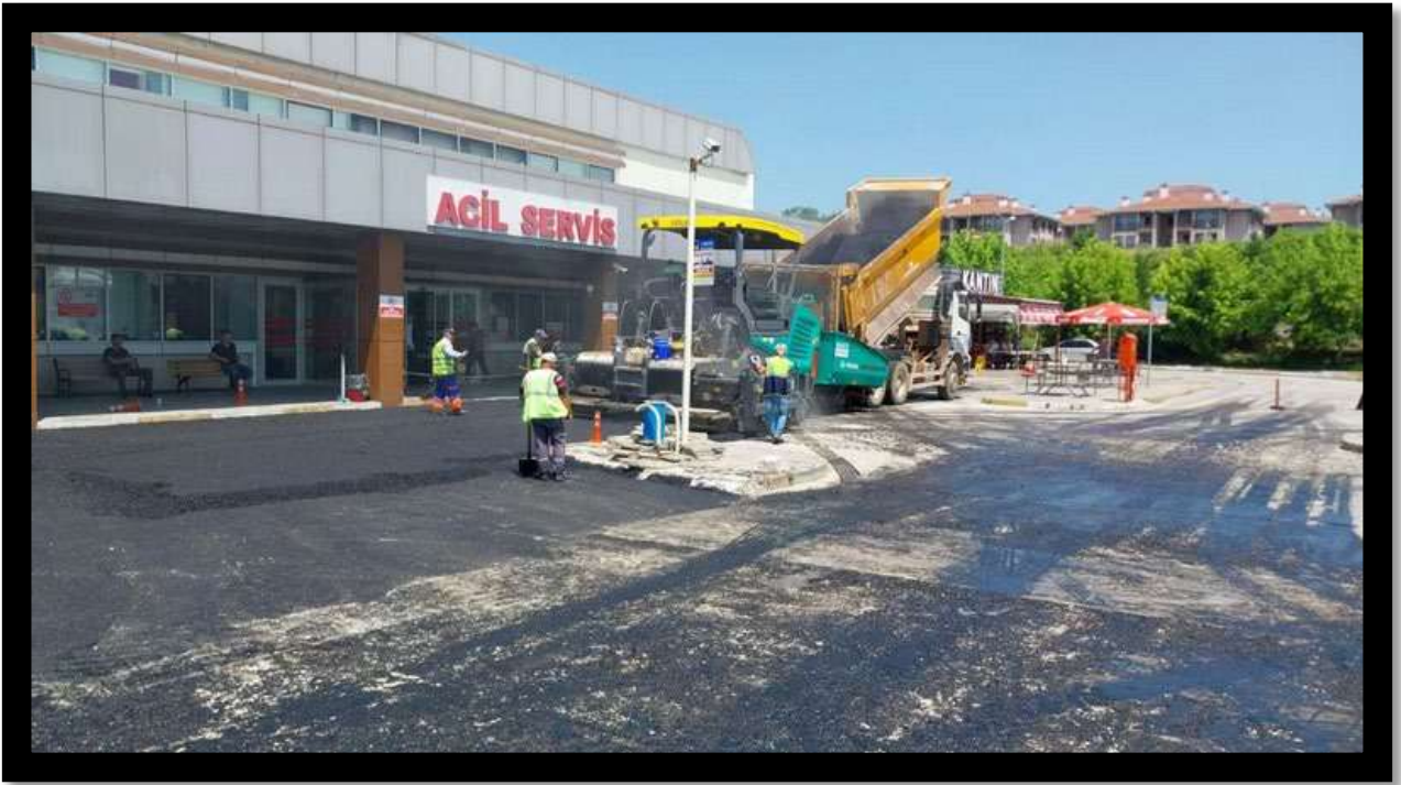
Kandıra Devlet Hastanesi Önü Asfalt İmalat Çalışması
