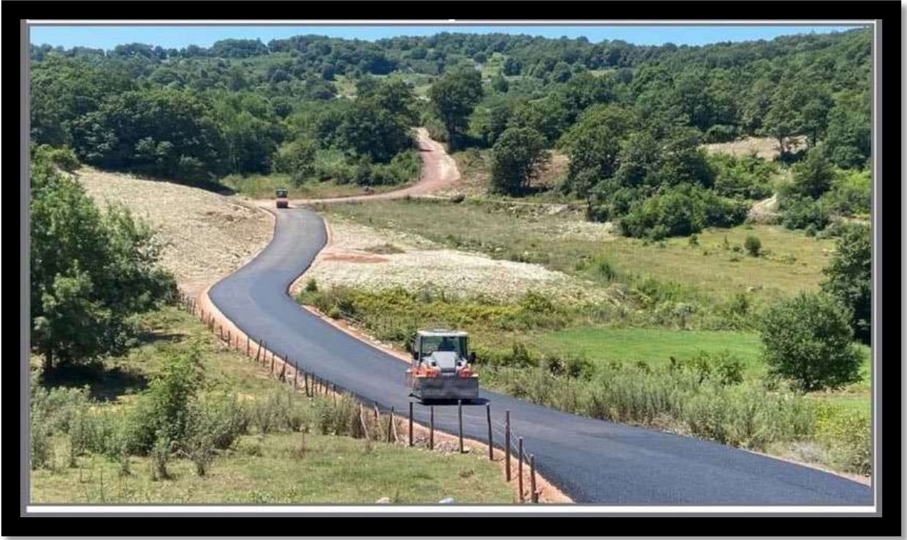
Akıncı-Cerçili Mahalleleri Arası Asfalt Yol İmalat Çalışması
