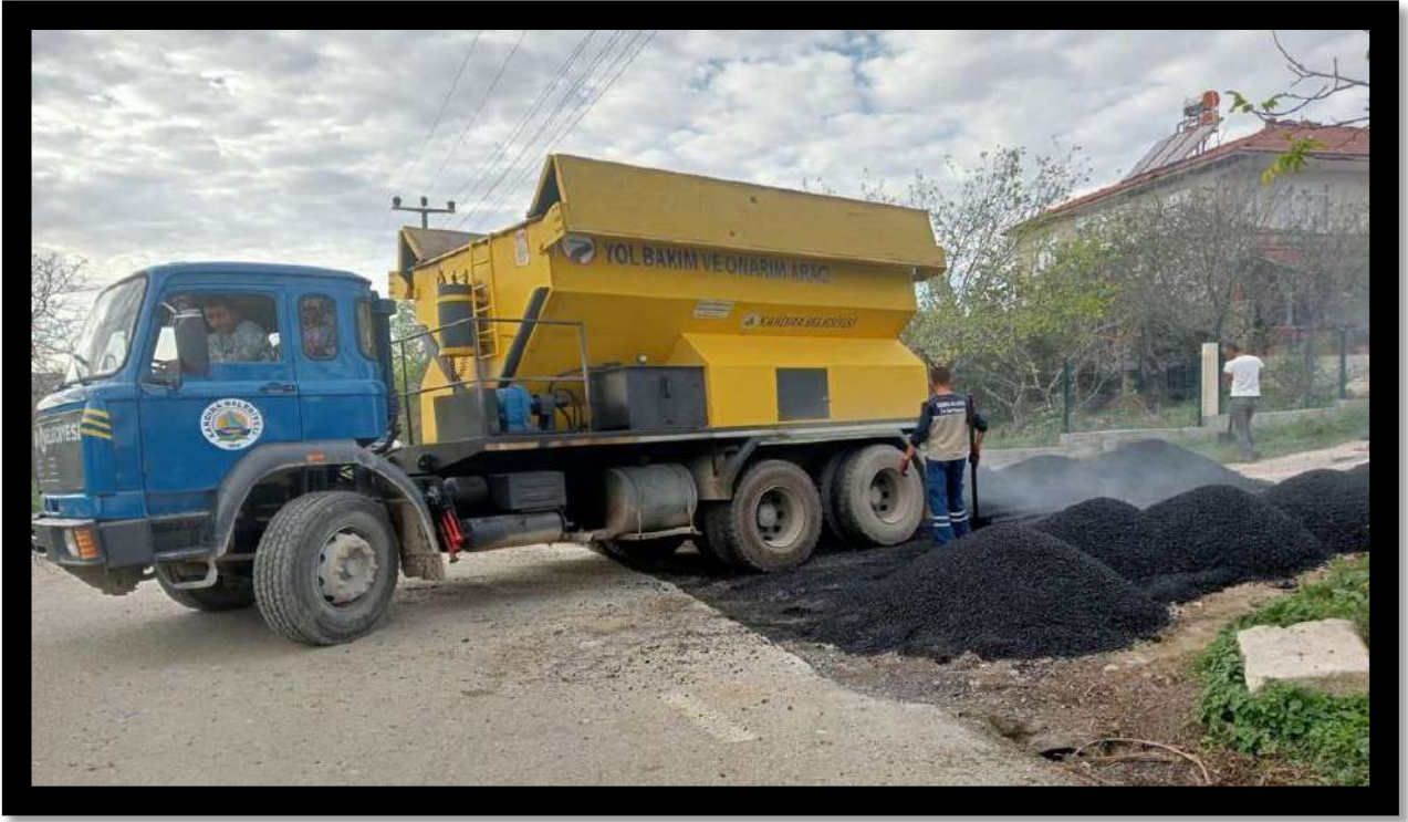
Özbey Mahallesi Asfalt Bakım Onarım Çalışması
