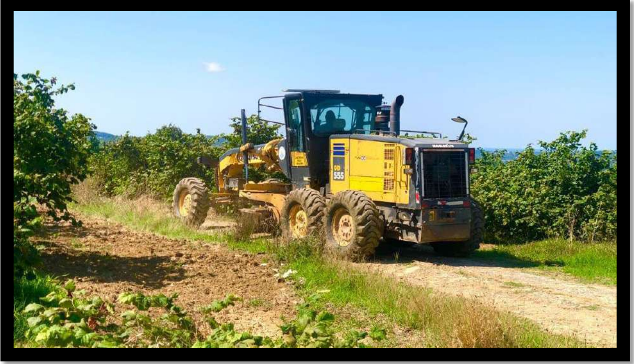
Safalı Mahallesi Arazi Yolu Tesviye Çalışması
