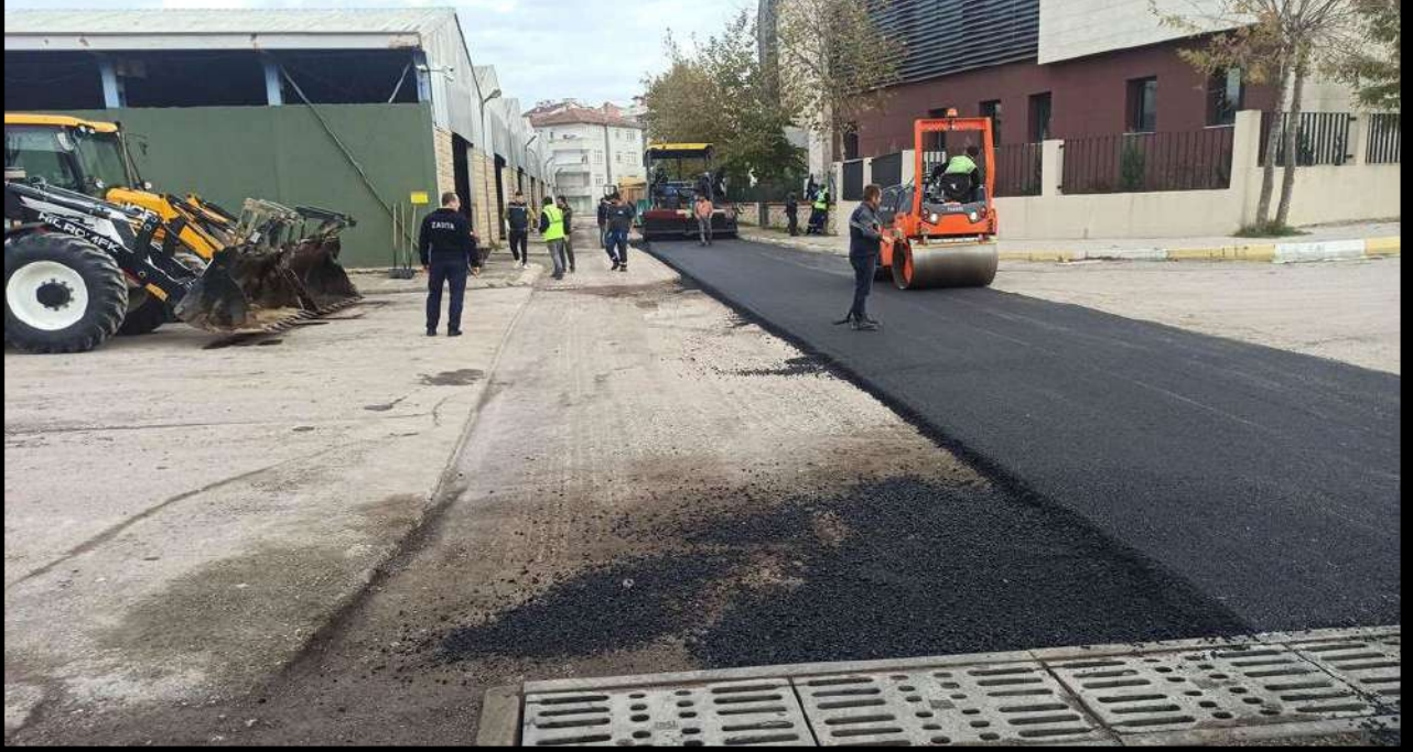
İlçe Merkezi Asfalt Yol İmalat Çalışması
