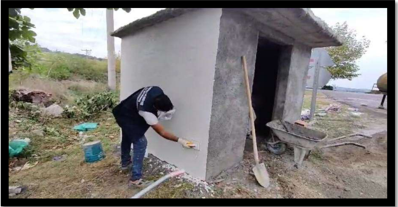
Çakırcaali Mahallesi Cicili Mevkii Durak Sıva Çalışması
