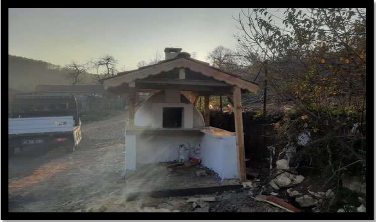
Balaban Mahallesi Çıraklı Mevkii Fırın İmalat Çalışması
