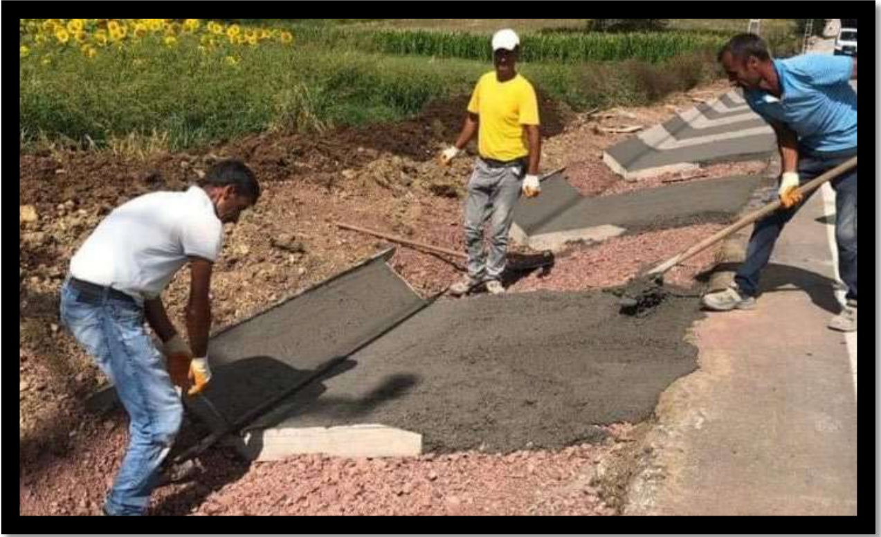
Kırkarmut Mahallesi V Kanal İmalat Çalışması
