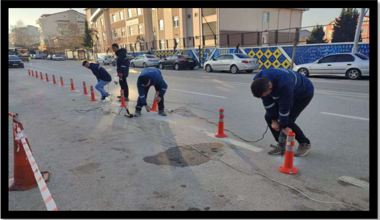
Çarşı Mahallesi Delinatör Montaj Çalışması
