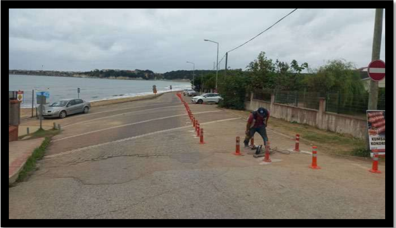
Kurtyeri Mahallesi Kumcağz Mevkii Delinatör Montaj Çalışması
