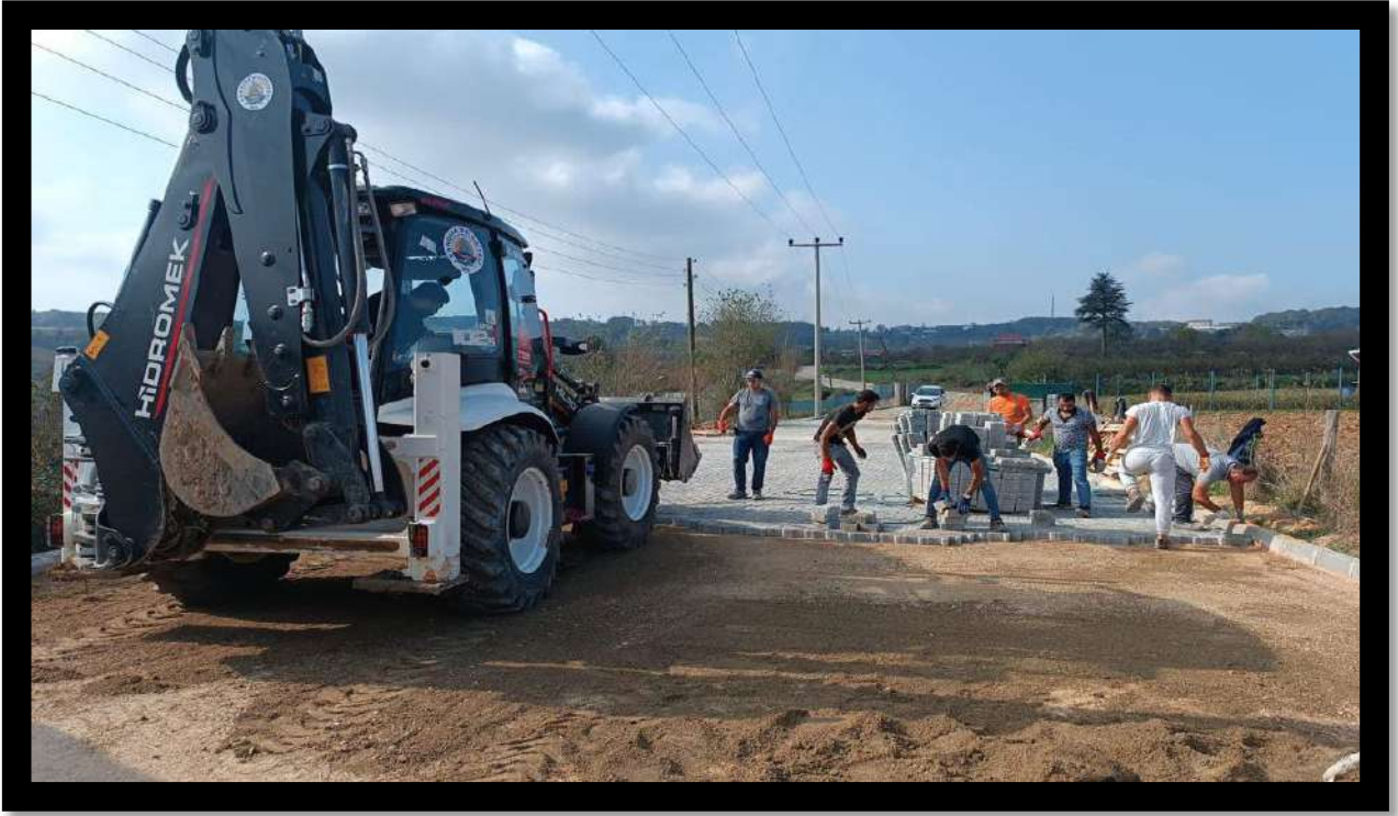
Dalca Mahallesi Parke İmalat Çalışması
