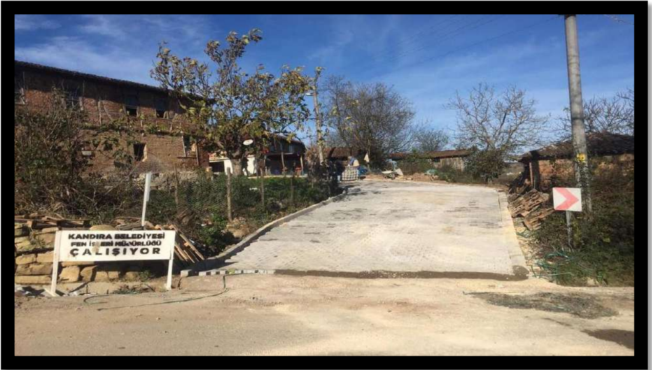
Sinanlı Bilalli Mahallesi Parke İmalat Çalışması
