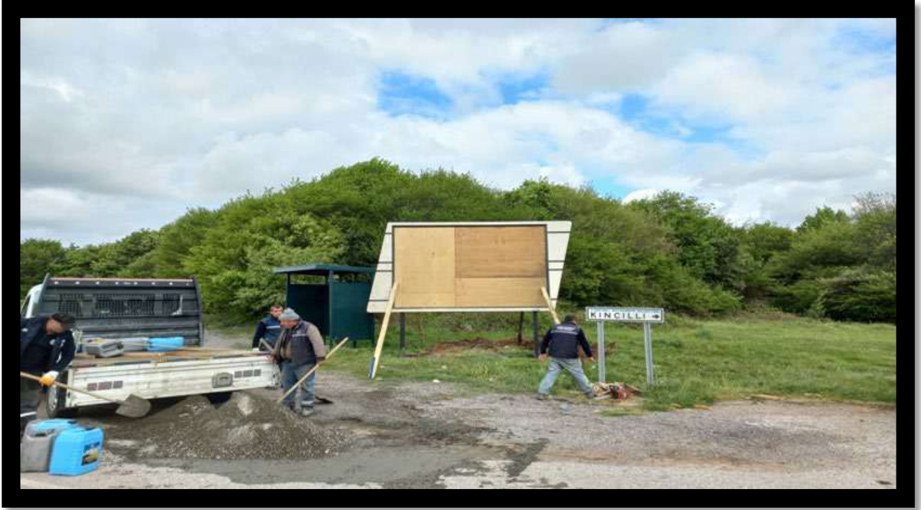
Kerpe Mahallesi Kincilli Mevkii Bilboard İmalat Çalışması
