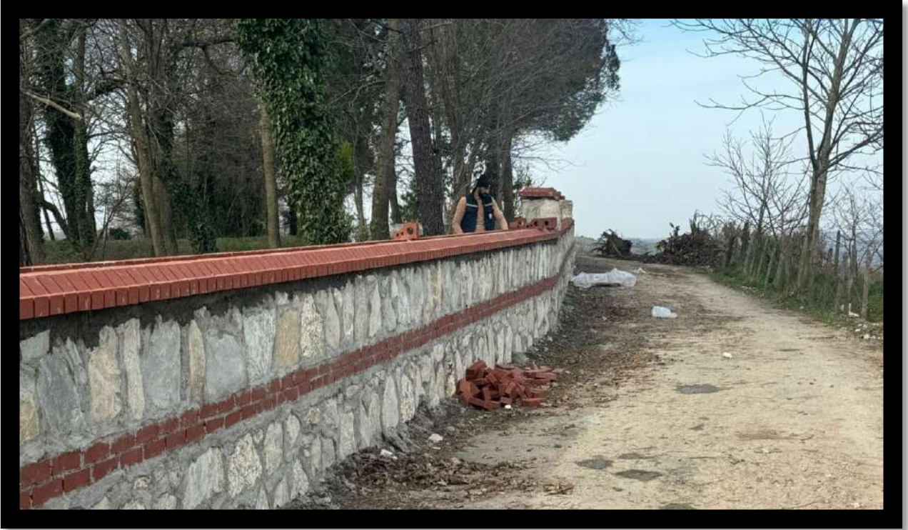
Balcı Mahallesi Mezarlık Taş Duvar İmalat Çalışması
