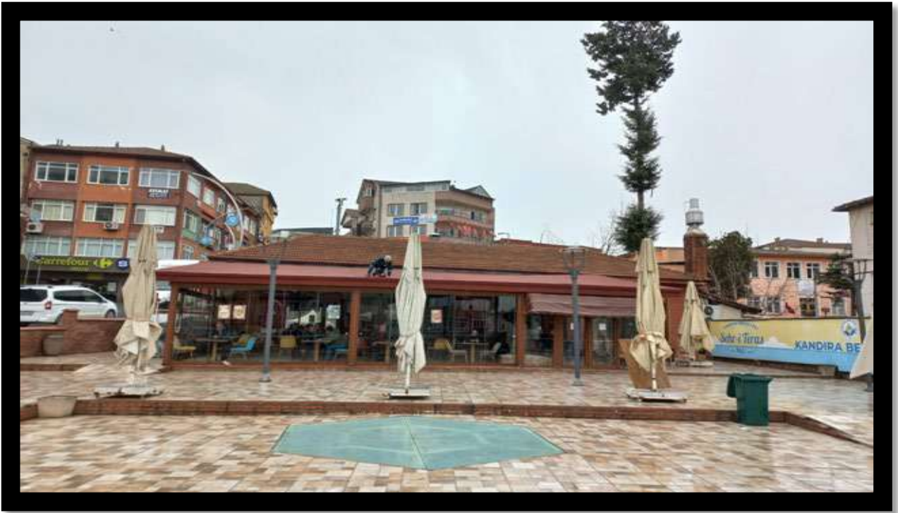
Akdurak Mahallesi Teras Kafe Çatı İmalat Çalışması
