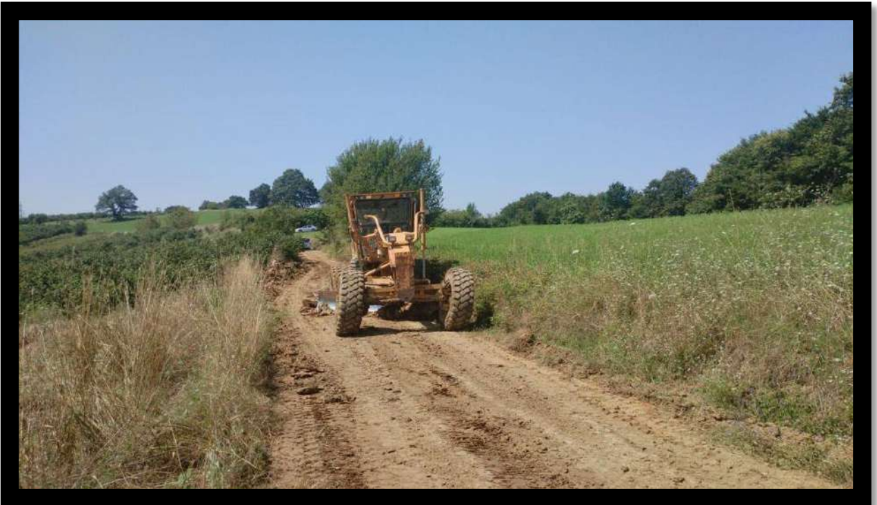
Sepetçi Mahallesi Arazi Yolu Tesviye Çalışması
