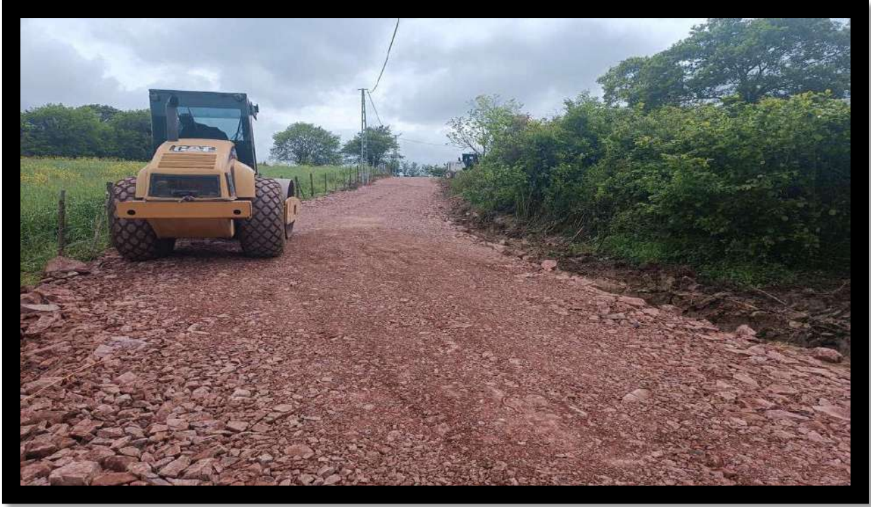
Çalköy Mahallesi Stabilize Serim ve Bakım Çalışması
