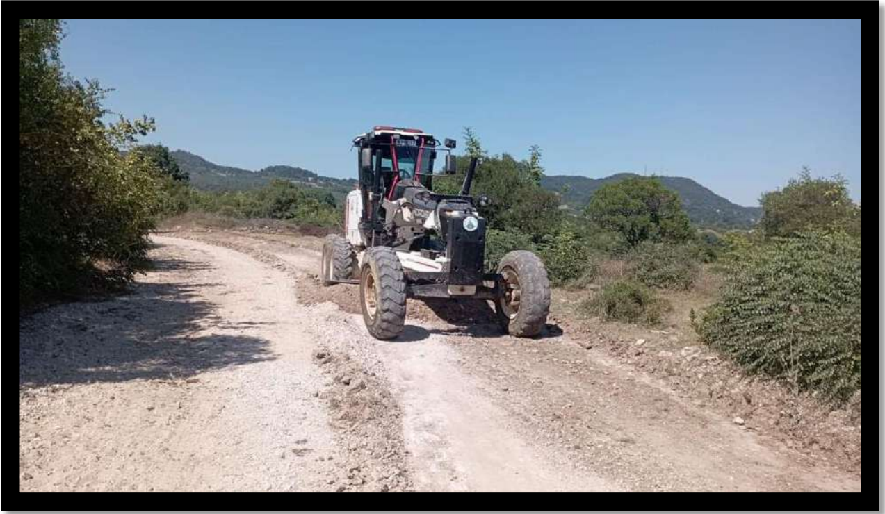
Kızılcapınar Mahallesi Arazi Yolu Tesviye Çalışması
