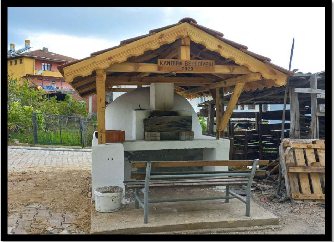
Bollu Mahallesi Fırın İmalat Çalışması
