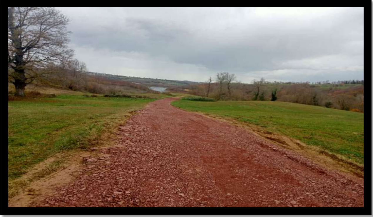
Sarnıçlar Mahallesi Stabilize Serim ve Bakım Çalışması
