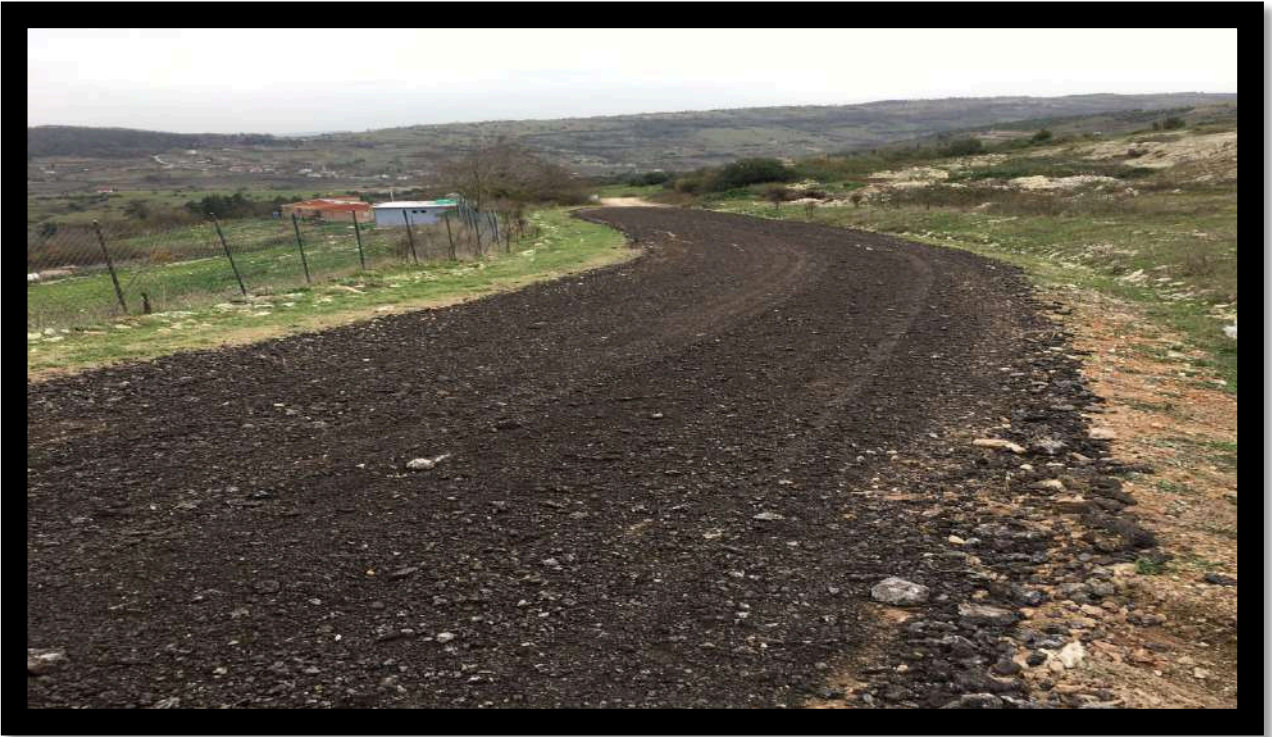
Selametli Mahallesi Malzeme Serim Çalışması
