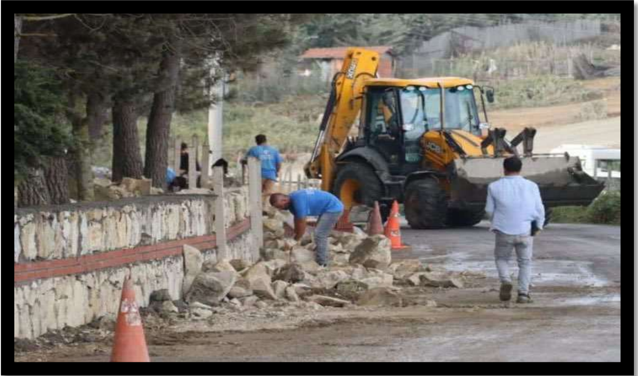
Bağrganlı Mahallesi Mezarlık Taş Duvar İmalat Çalışması
