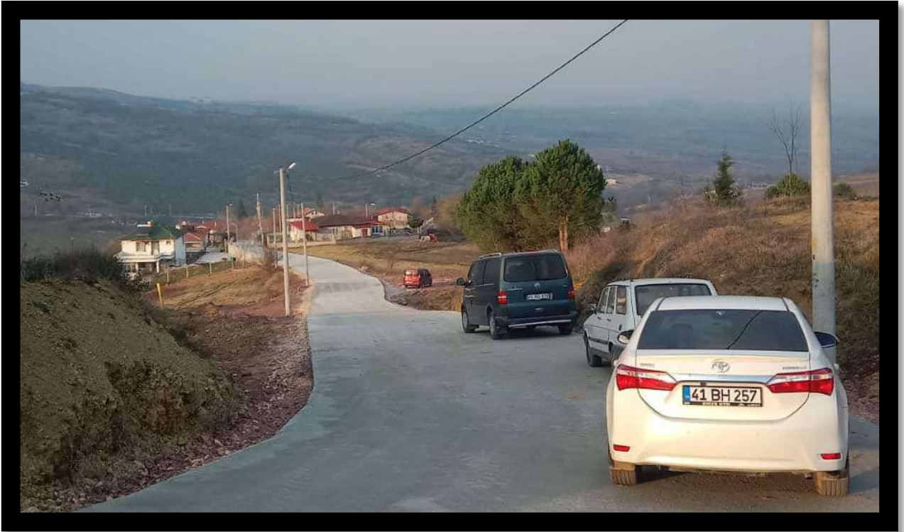
Pirceler Mahallesi Beton Yol İmalat Çalışması
