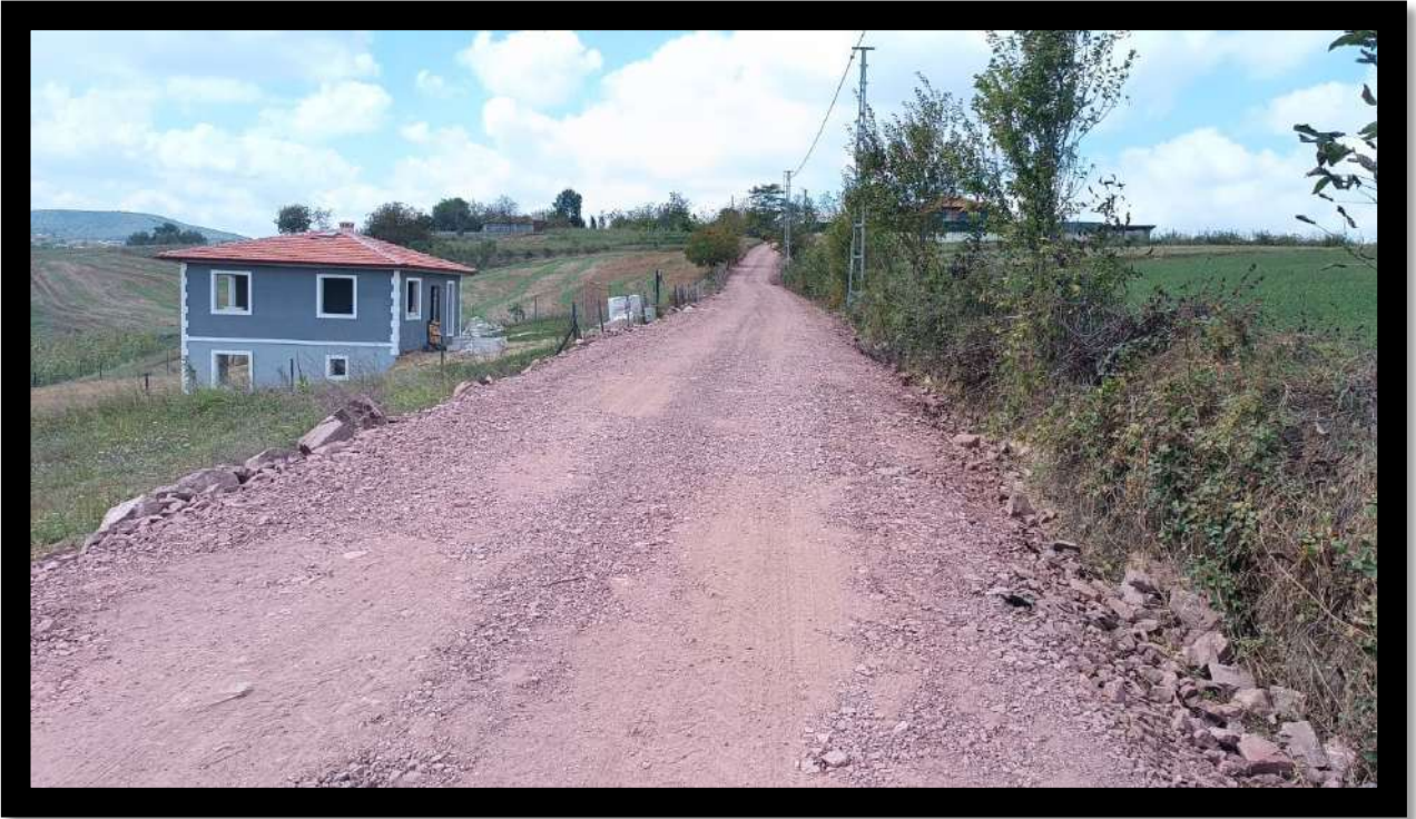
Sarıcaali Mahallesi Malzeme Serim Çalışması
