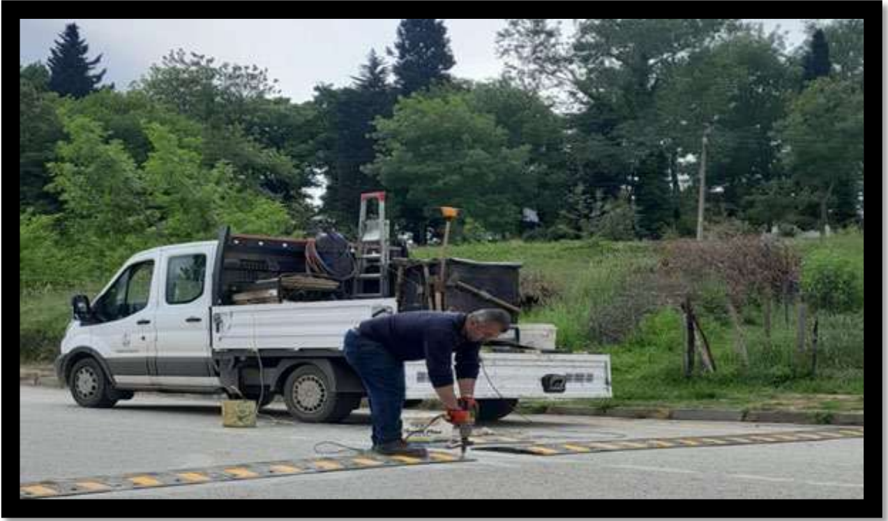
Akdurak Mahallesi Ilıca Caddesi Kasis Montaj Çalışması
