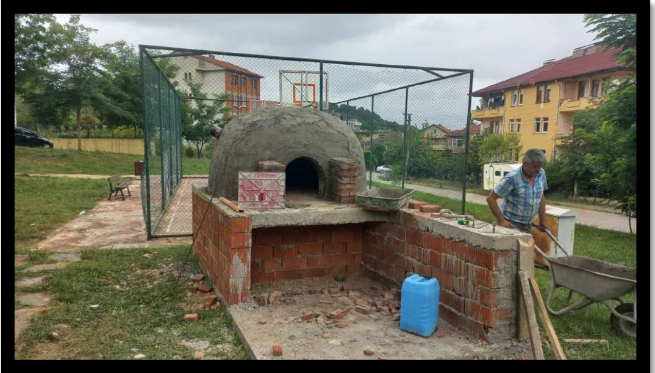
Çarşı Mahallesi Fırın İmalat Çalışması
