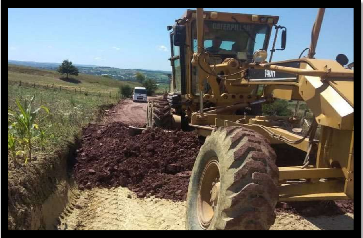
Lokmanlı Mahallesi Stabilize İmalat Çalışması
