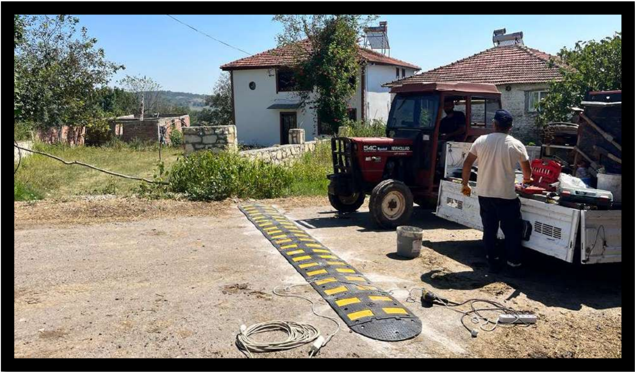
Eğercili Mahallesi Güvenler Mevkii Kasis Montaj Çalışması
