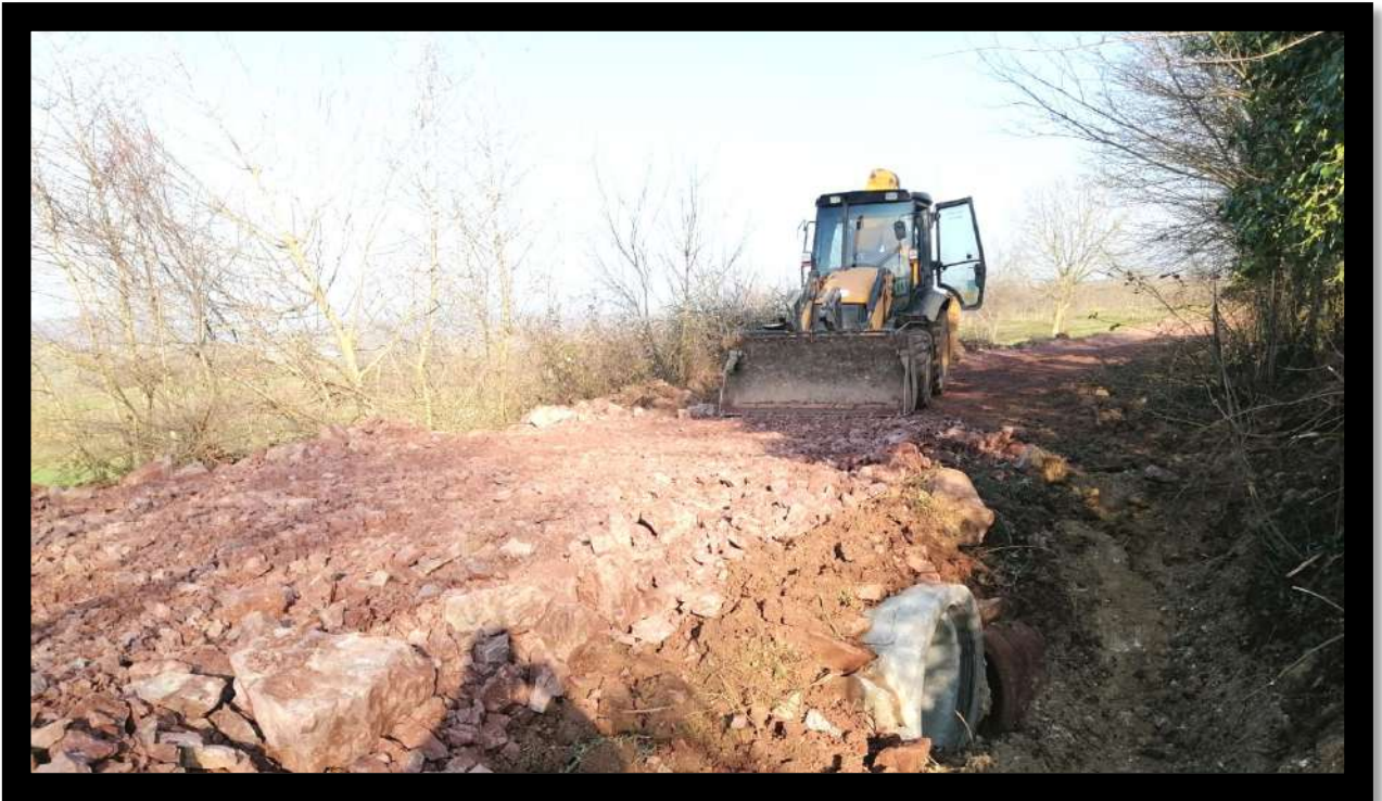
Üğümce Mahallesi Büz Koyma Çalışması
