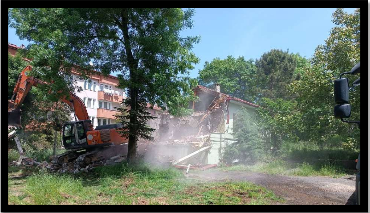
Carsı Mahallesi Metruk Bina Yıkım Çalışması
