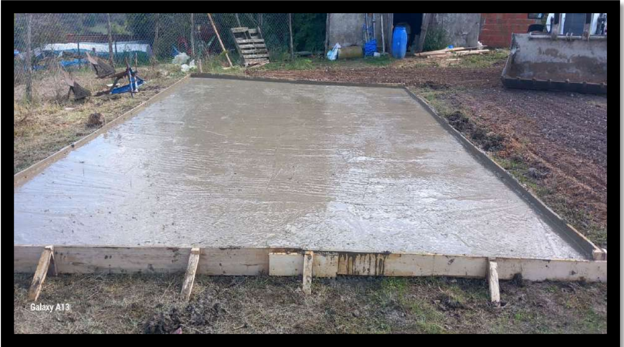
Calyer Mahallesi Yanan Gariban Evi Temel Beton Çalışması
