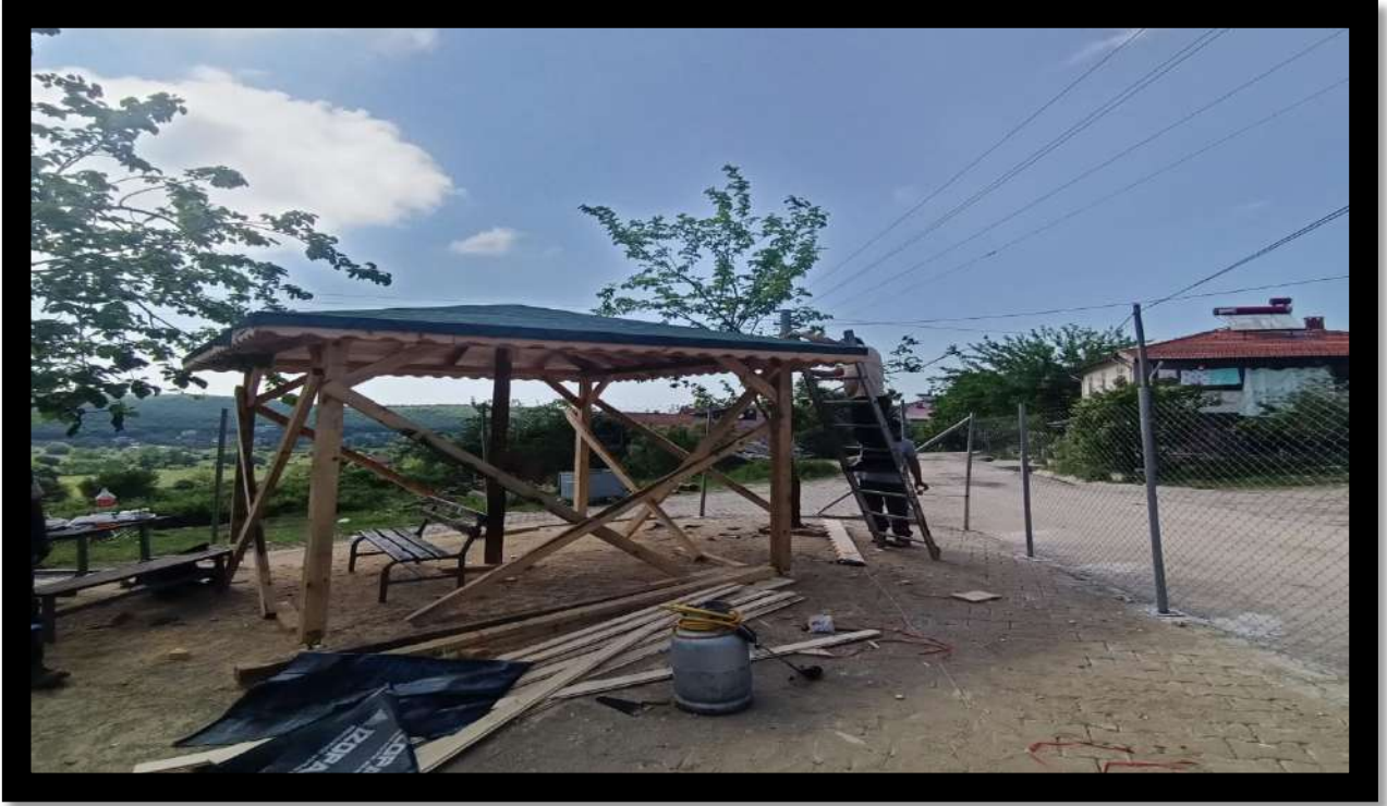
Ballar Mahallesi Rıdvanlar Mevkii Kamelya İmalat Çalışması
