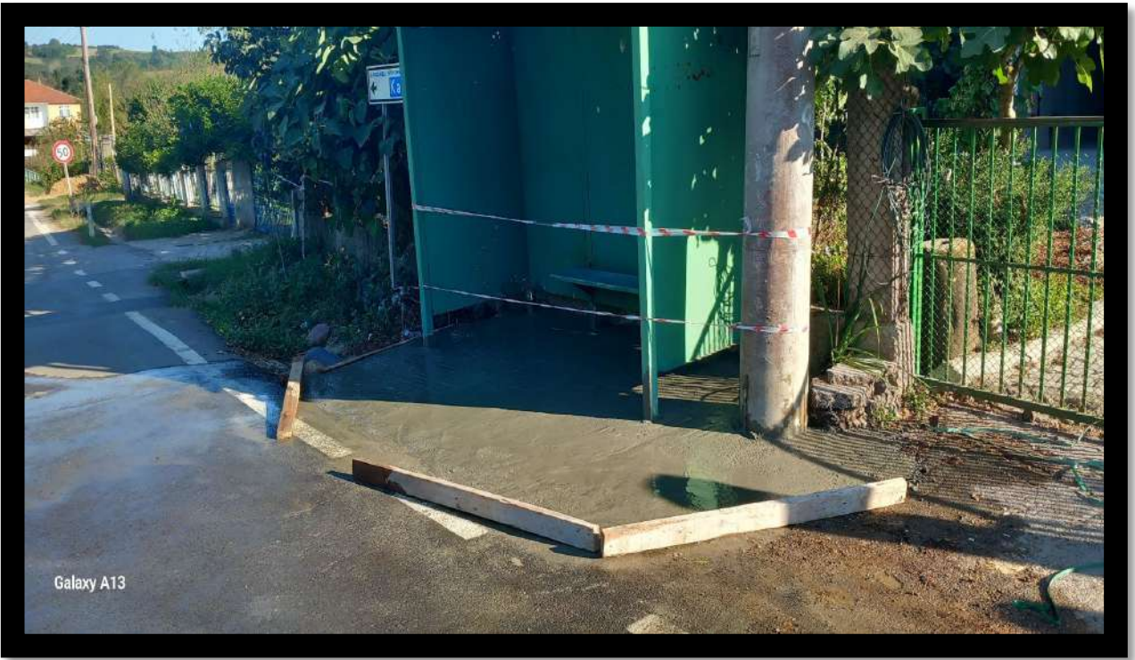
Safalı Mahallesi Durak Yeri Zemin Betonu Atma Çalışması
