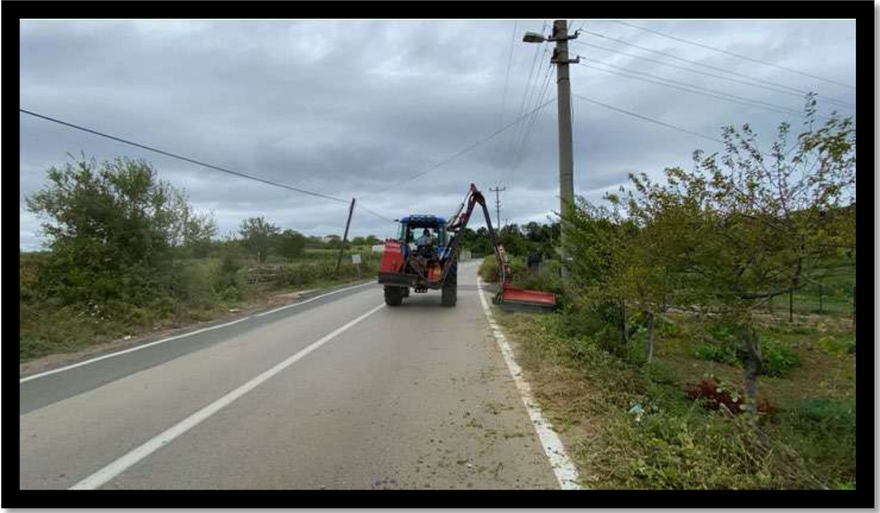
Hacımazlı ve Bağırganlı Mahalleleri Arası Çalı Canavarı Çalışması
