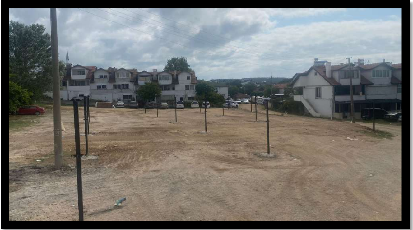
Cebeci Mahallesi Pazar Yeri Direk Montaj Çalışması
