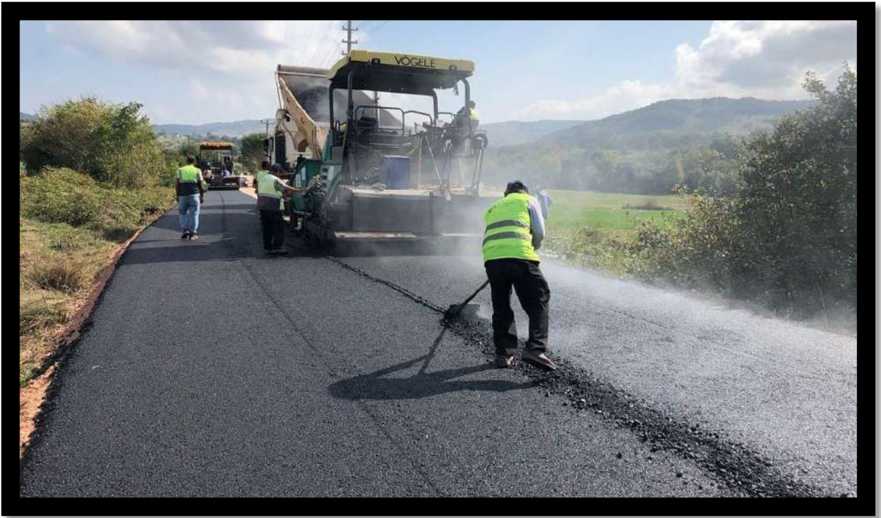
Teksen-Akçaova Mahalleleri Arası Asfalt Yol İmalat Çalışması
