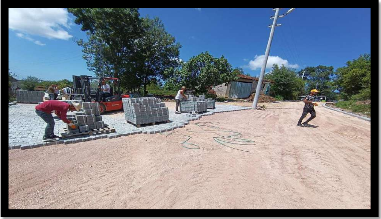
Lokmanlı Mahallesi Parke İmalat Çalışması
