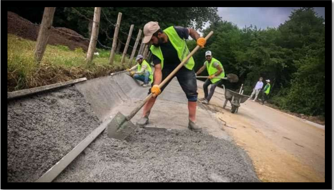
Kabağaç Mahallesi V Kanal İmalat Çalışması
