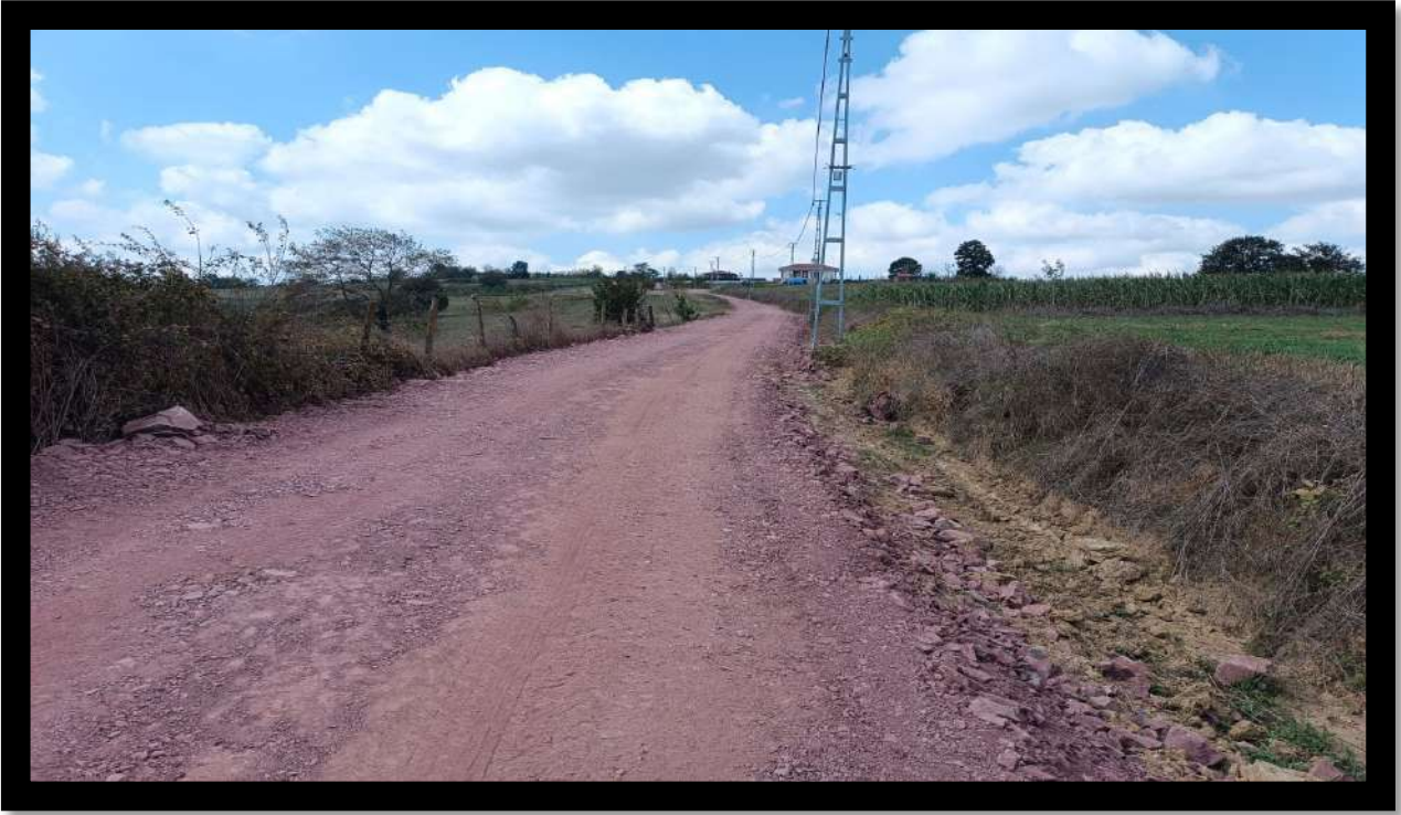
Sarıcaali Mahallesi Stabilize Serim ve Bakım Çalışması
