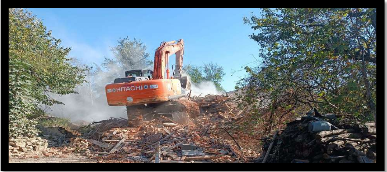
Sinanlı Bilalli Mahallesi Metruk Bina Yıkım Çalışması
