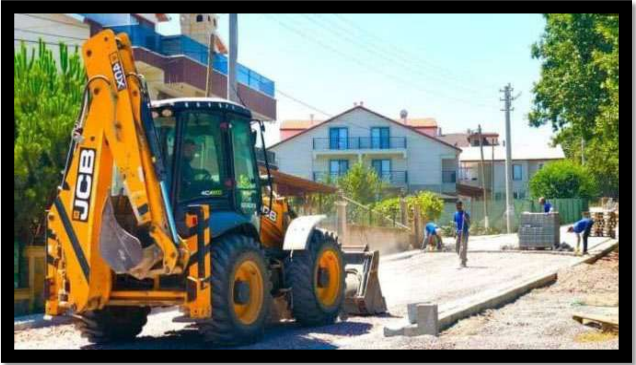
Cebeci Mahallesi Parke İmalat Çalışması
