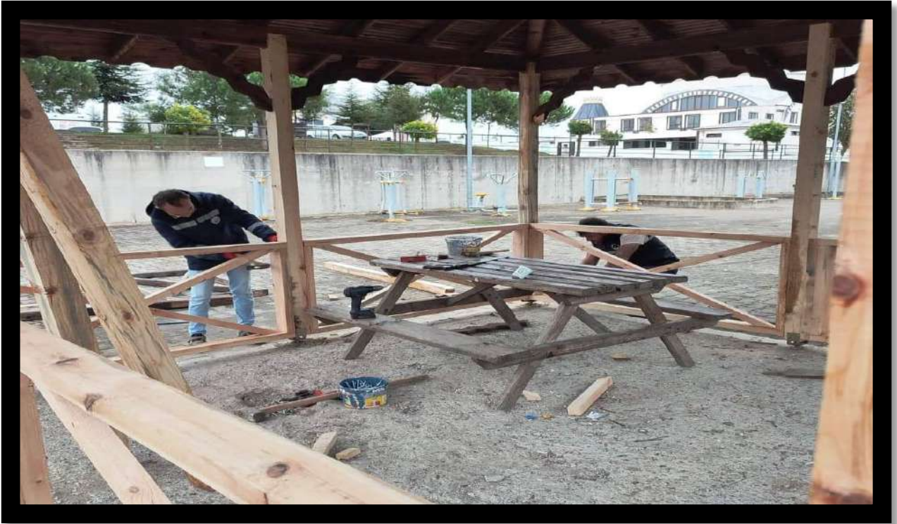
Kocakaymas Mahallesi Cezaevi Lojmanı Kamelya Bakım Onarım
