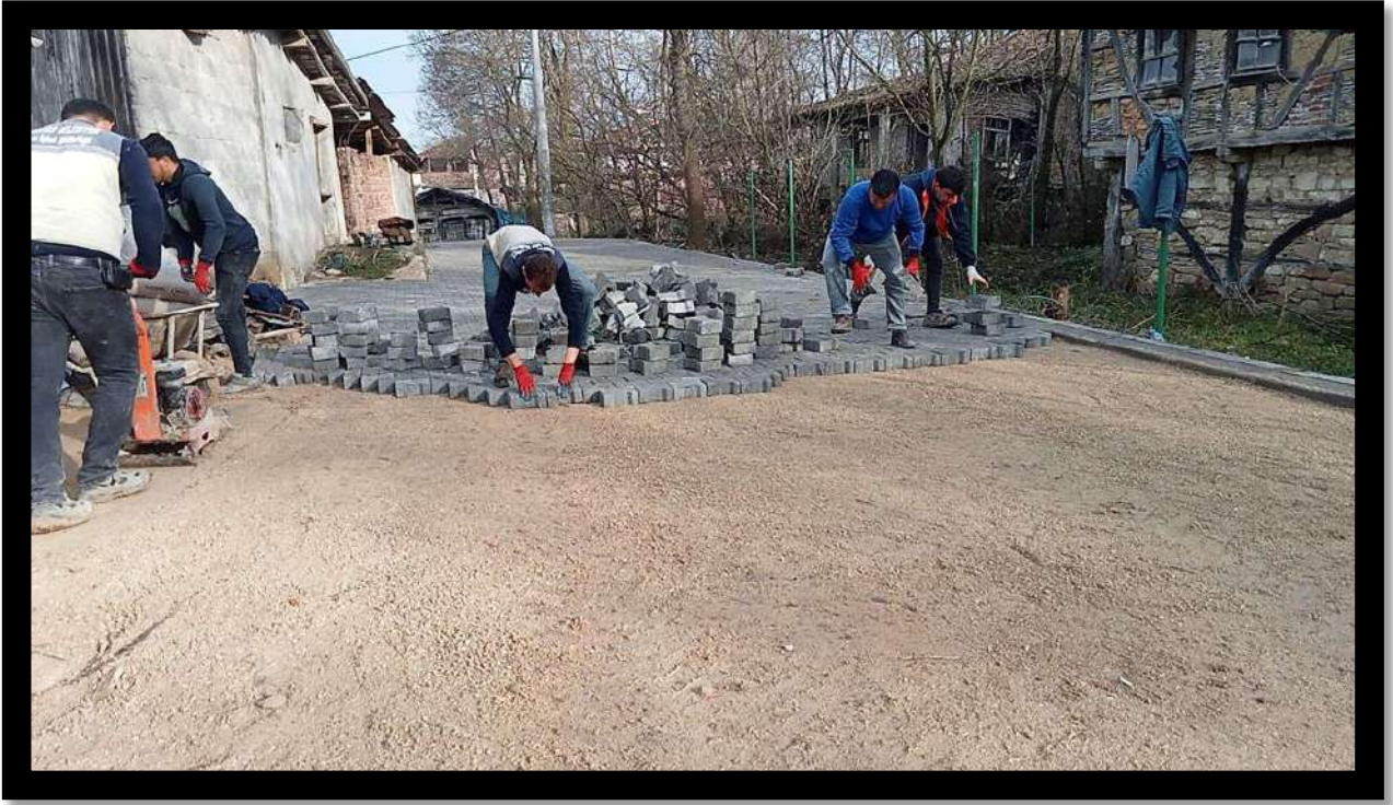
Topluca Mahallesi Parke İmalat Çalışması
