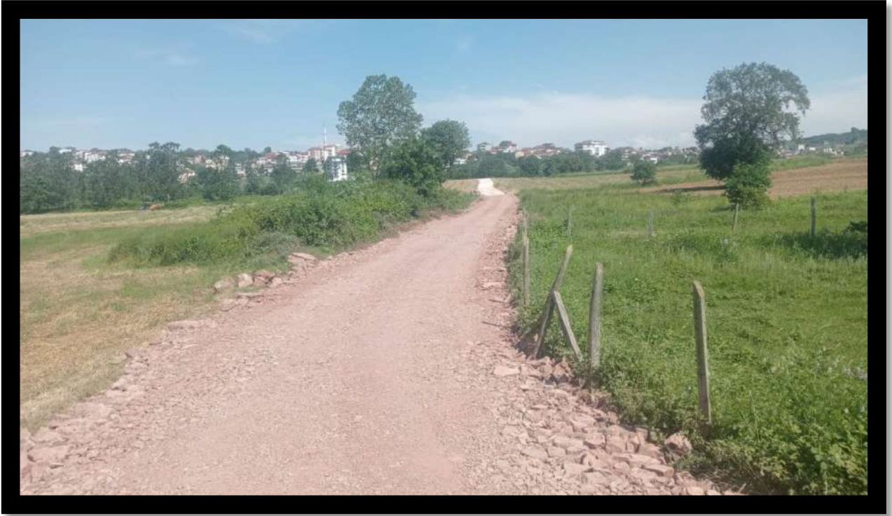
Orhan Mahallesi Stabilize Serim ve Bakım Çalışması
