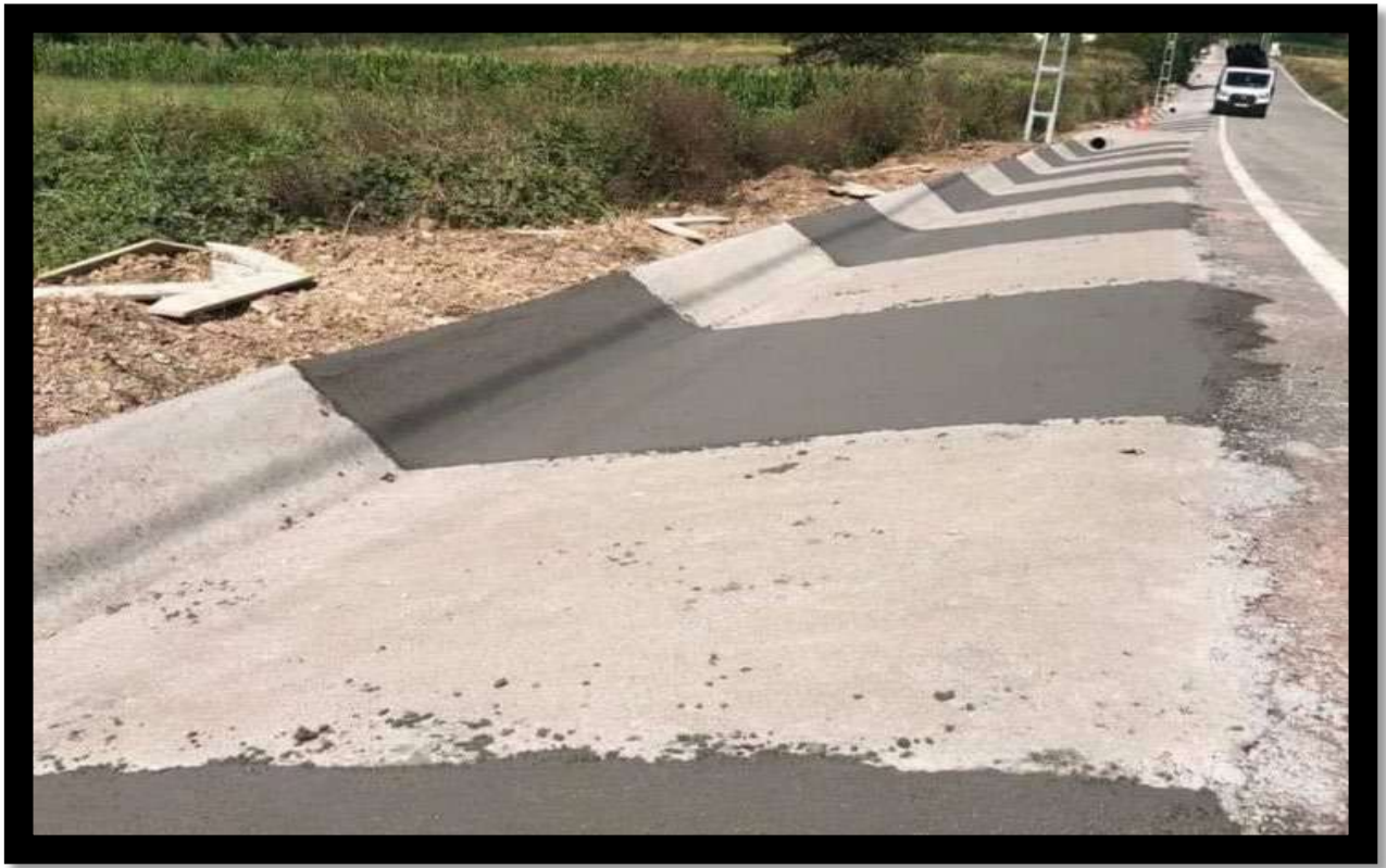
Kırkarmut Mahallesi V Kanal İmalat Çalışması
