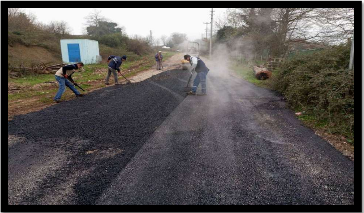
Kaymaz Araman Mahallesi Asfalt Bakım Onarım Çalışması
