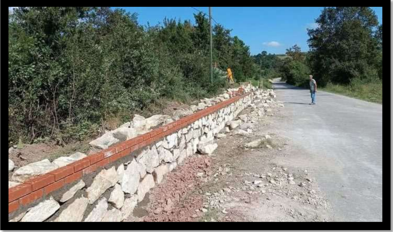
Ahmethacılar Mahallesi Mezarlık Taş Duvar İmalat Çalışması
