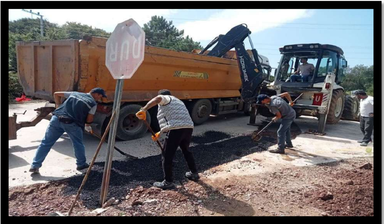
Doğancılı Mahallesi Asfalt Bakım Onarım Çalışması
