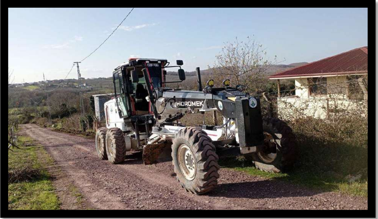
Camkonak Mahallesi Arazi Yolu Tesviye Çalışması
