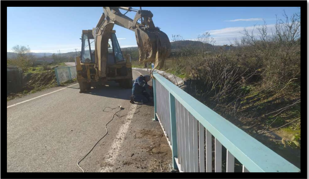
Akıncı Mahallesi Köprü Korkuluk İmalat Çalışması
