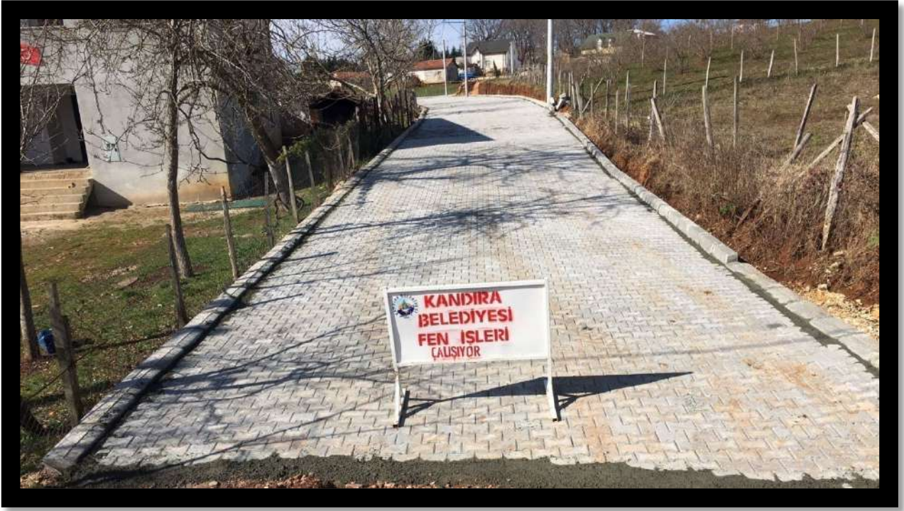
Karaağaç Mahallesi Parke İmalat Çalışması
