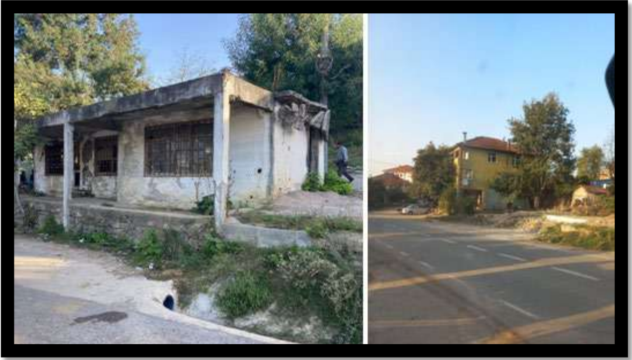
Kaymaz Araman Mahallesi Metruk Bina Yıkım Çalışması
