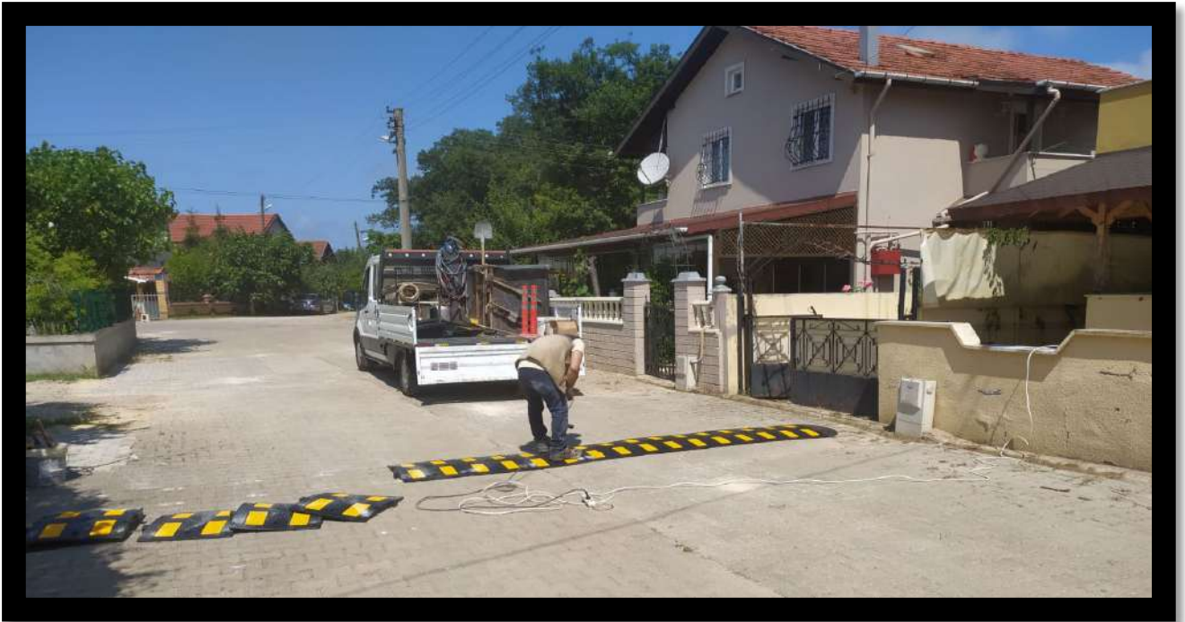
Kefken Mahallesi Merkez Mevkii Kasis Montaj Çalışması
