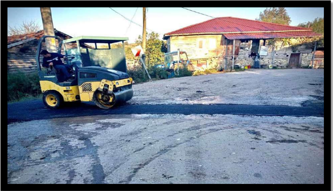
Üğümce Mahallesi Asfalt Bakım Onarım Çalışması
