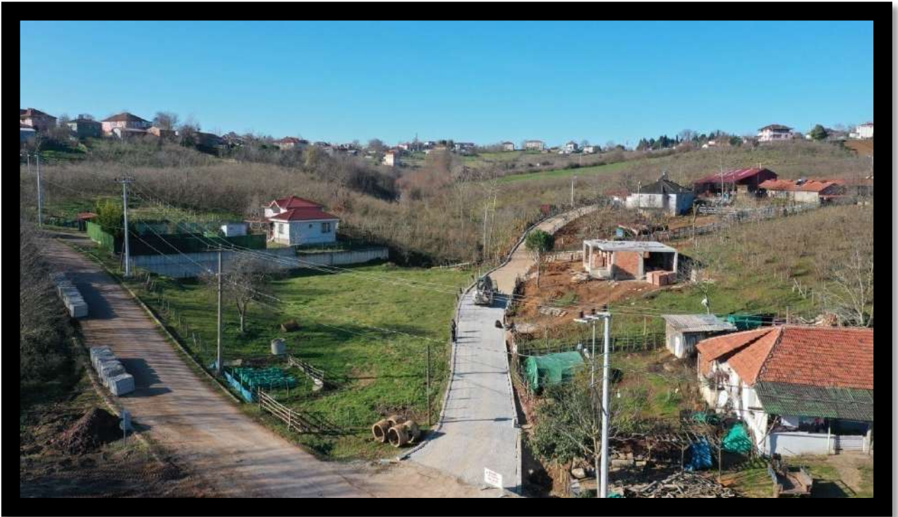
Karaağaç Mahallesi Parke İmalat Çalışması
