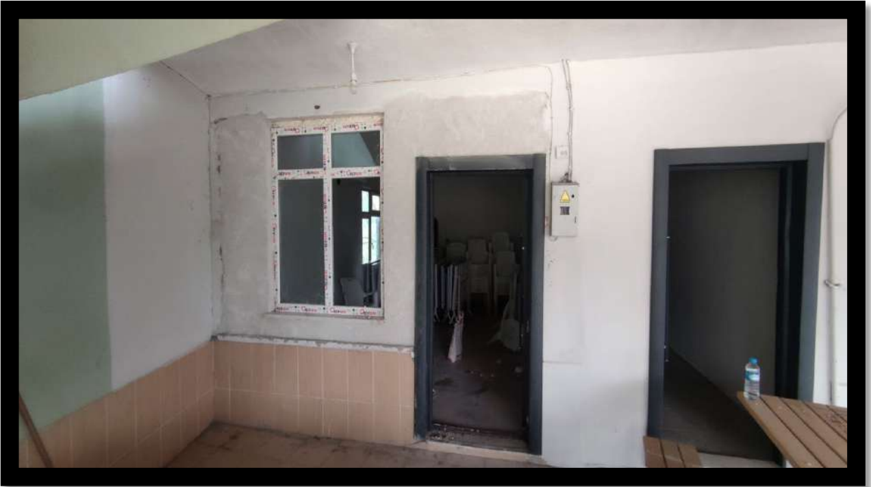
Sucuali Köy Konağı Sıva Tamirat Çalışması
