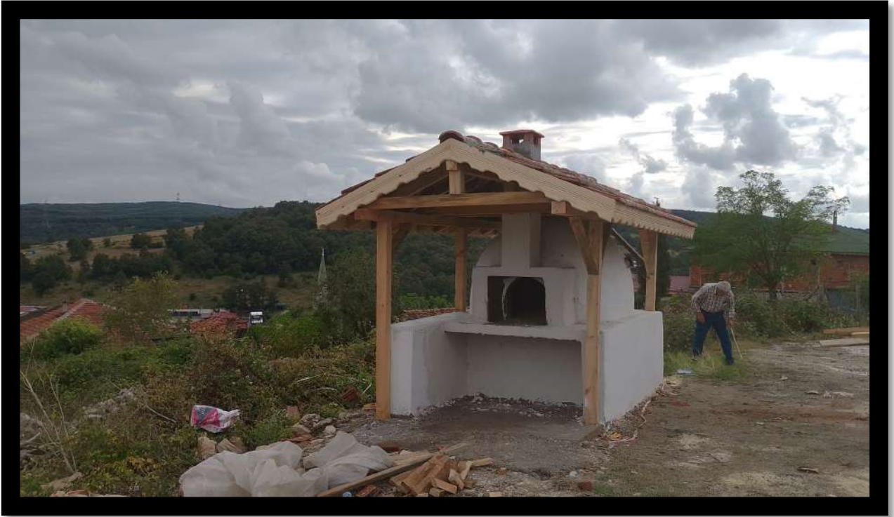
Çakmaklar Mahallesi Fırın İmalat Çalışması
