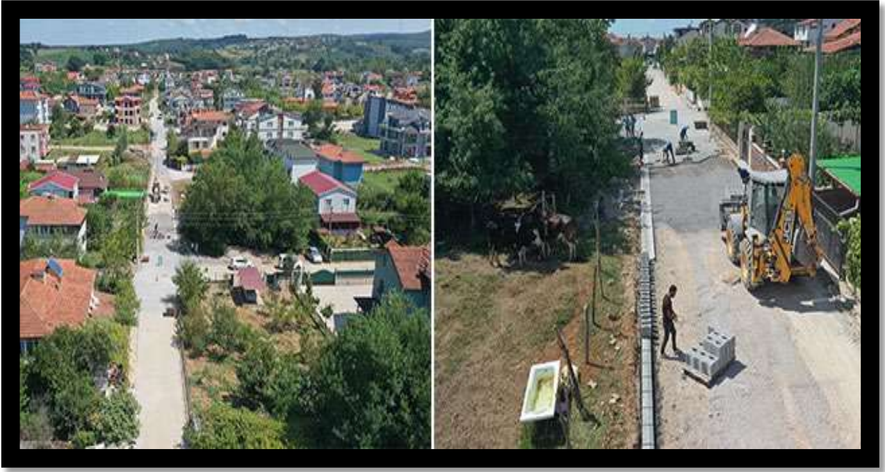
Cebeci Mahallesi Parke İmalat Çalışması
