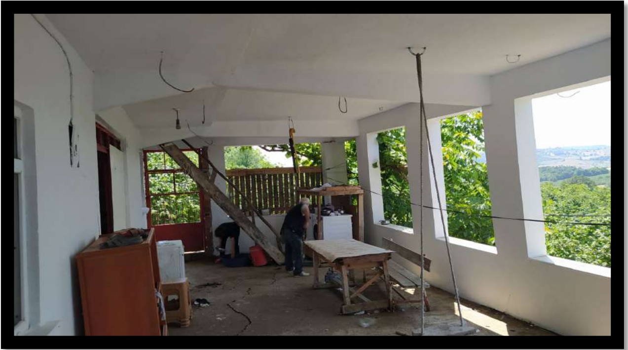
Hacılar Mahallesi Gariban Evi Boyama Çalışması
