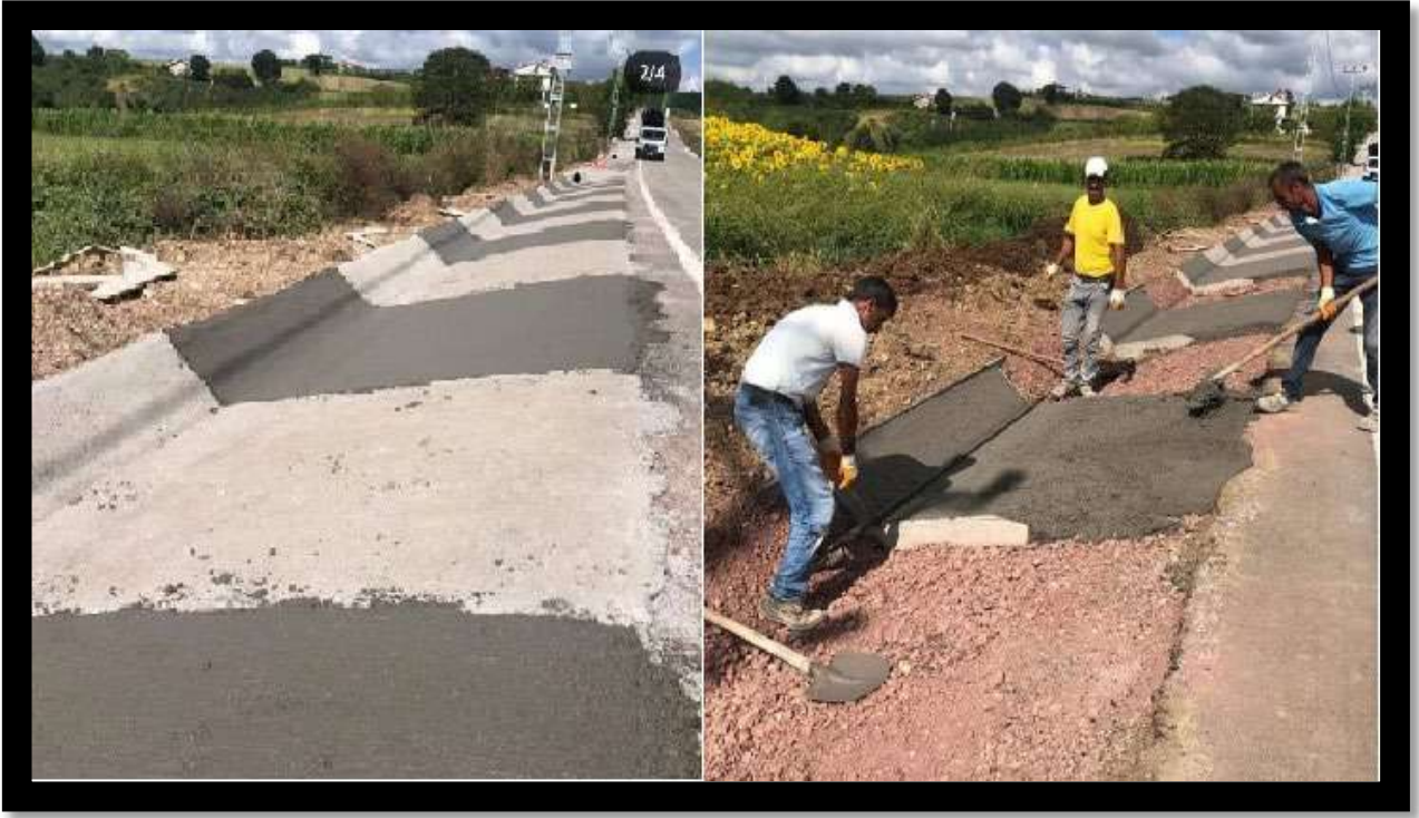
Kırkarmut Mahallesi V Kanal İmalat Çalışması
