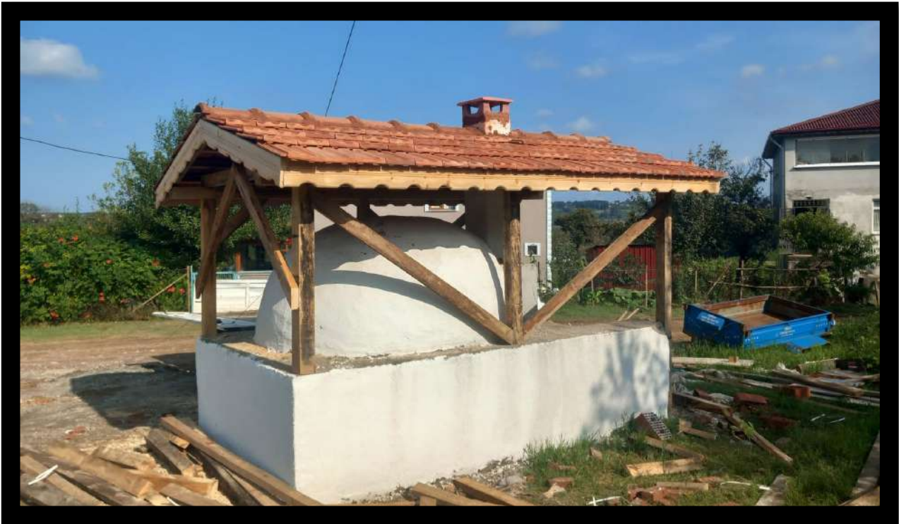
Karaağaç Mahallesi Sakalhoğlu Mevkii Fırın İmalat Çalışması
