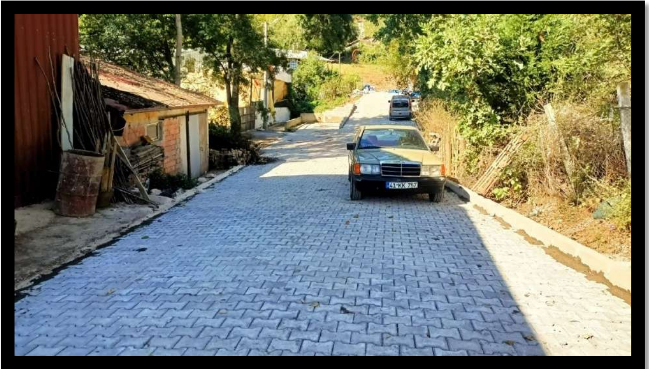
Yusufca Mahallesi Parke İmalat Çalışması
