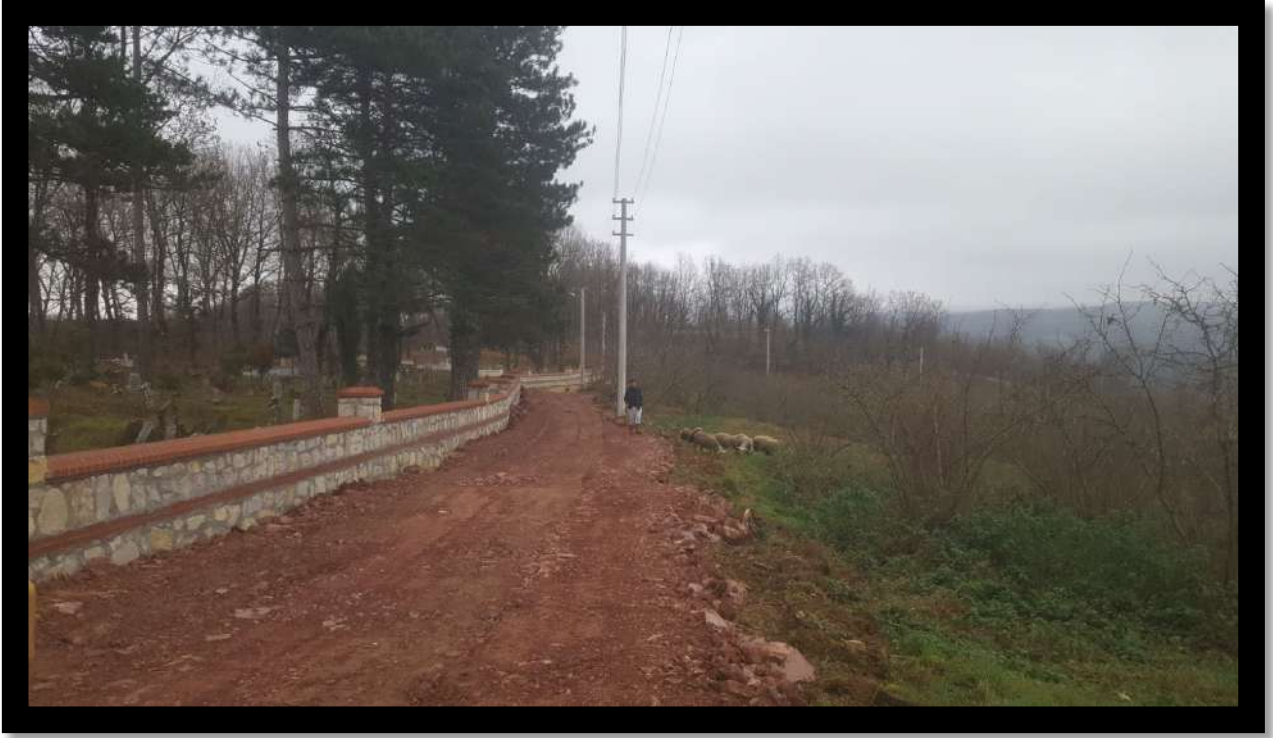
Teksen Mahallesi Stabilize Serim ve Bakım Çalışması
