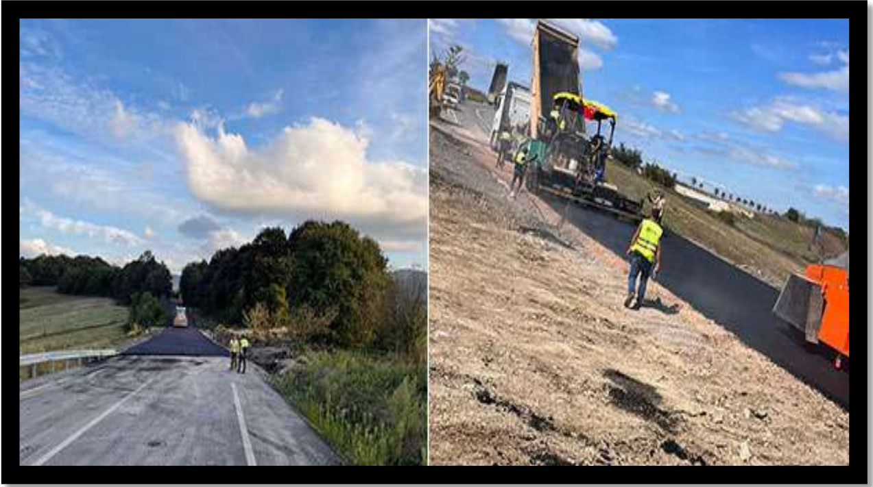
Akçakese Mahallesi Asfalt Yol İmalat Çalışması
