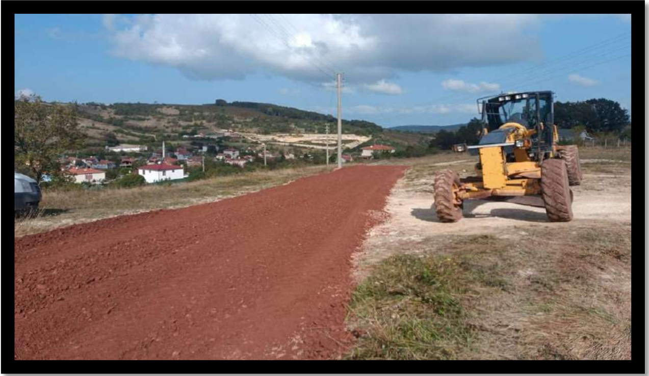
Yağcılar Mahallesi Stabilize İmalat Çalışması
