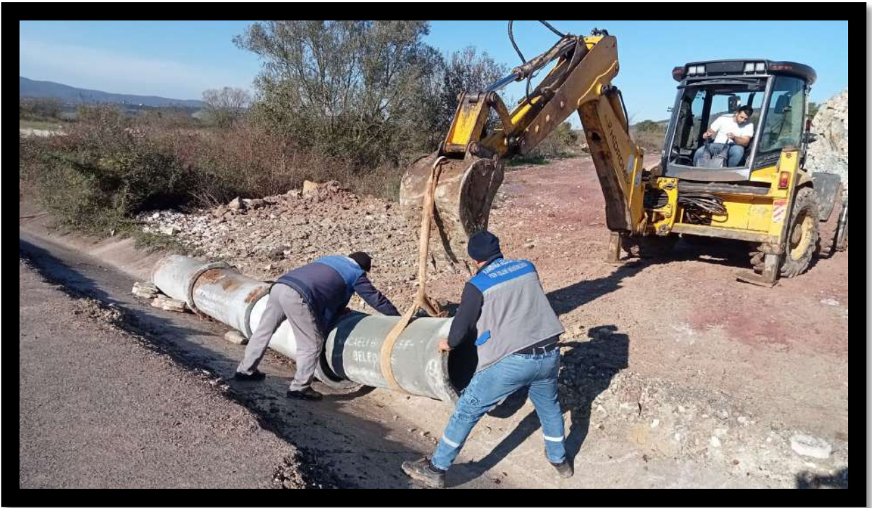
Akçaova Mahallesi Büz Koyma Çalışması
