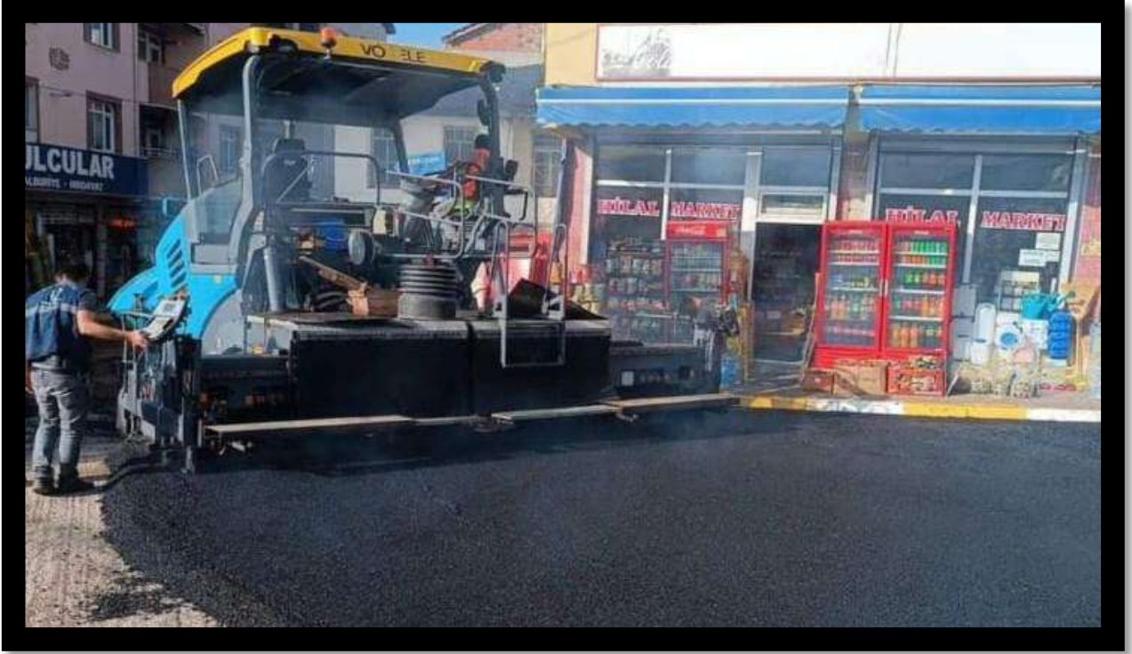
İlçe Merkezi Asfalt Yol İmalat Çalışması
