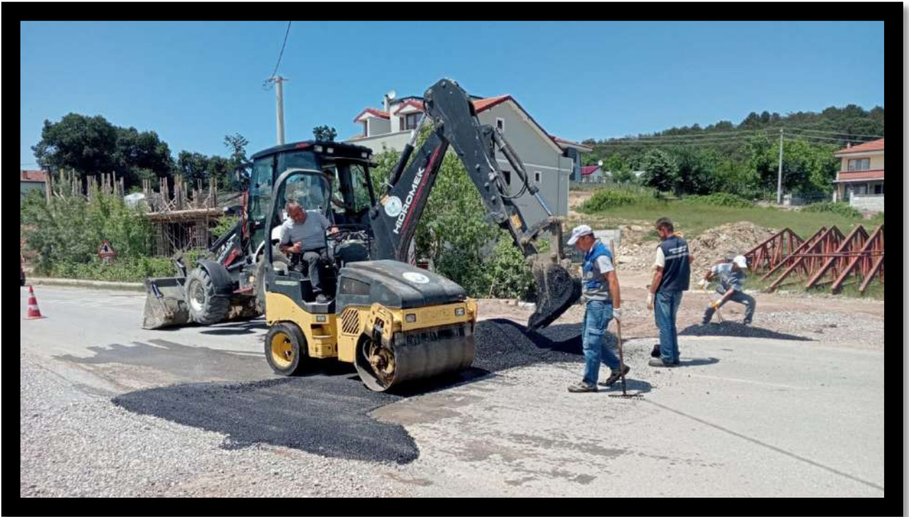
Kefken Mahallesi Asfalt Bakım Onarım Çalışması
