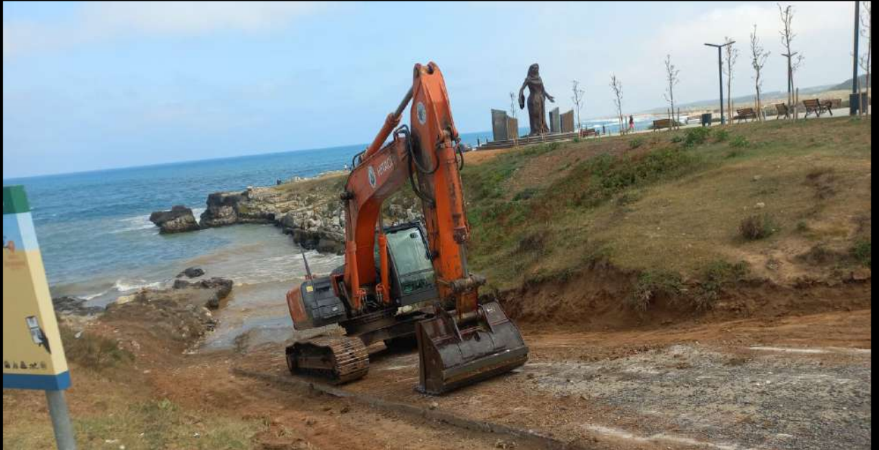
Babalı Mahallesi Ekskavatör Çalışması
