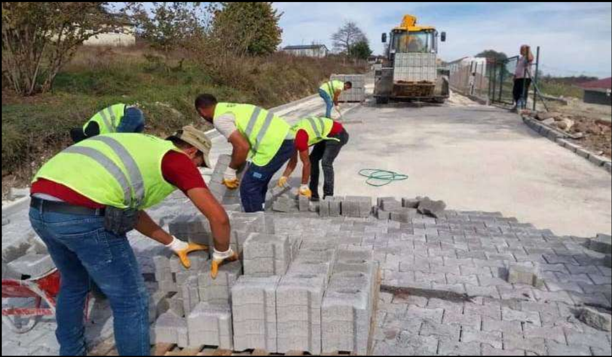
Kefken Mahallesi Parke İmalat Çalışması
