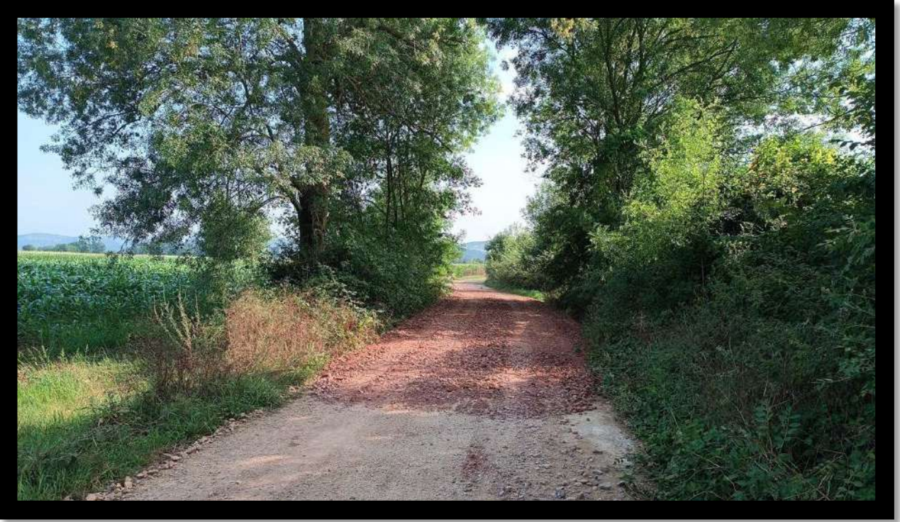
Akbal Mahallesi Stabilize Serim ve Bakım Çalışması
