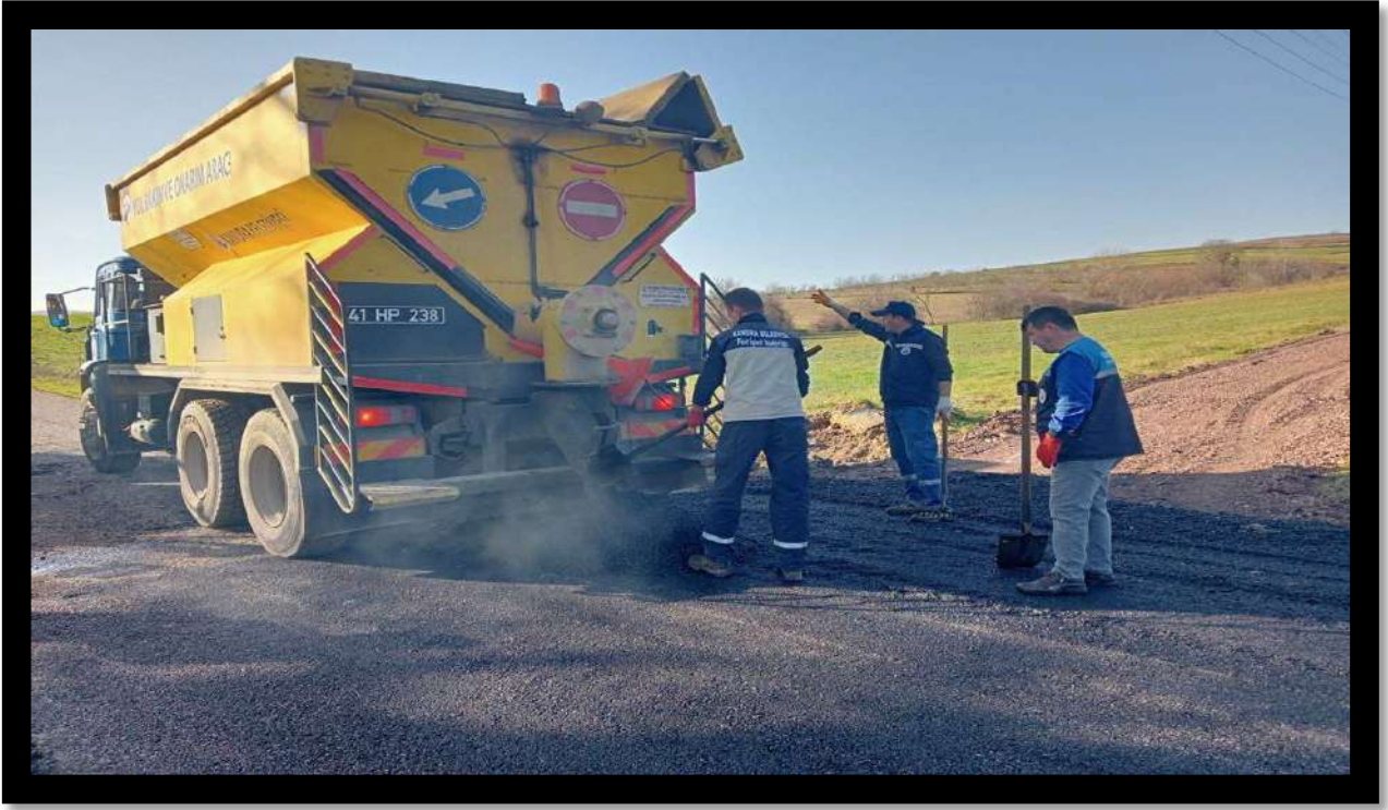
Topluca Mahallesi Asfalt Bakım Onarım Çalışması
