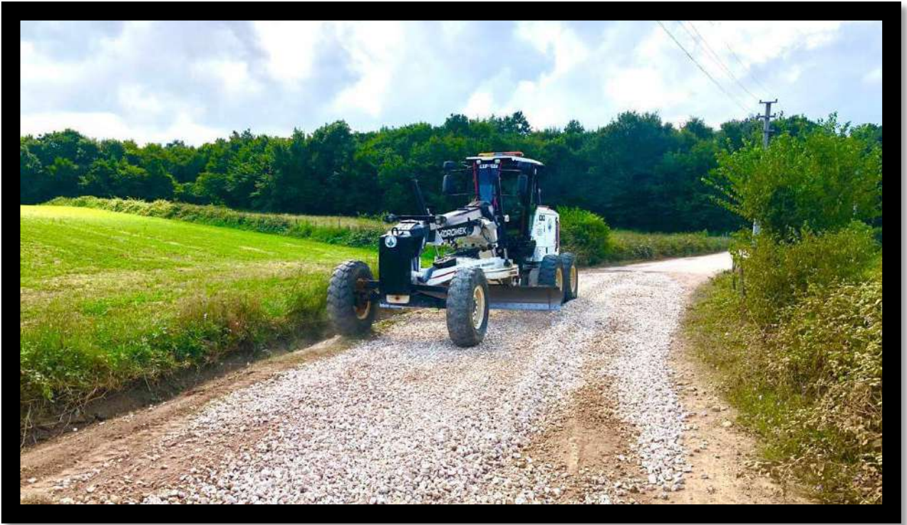
Kefken Mahallesi Arazi Yolu Tesviye Çalışması
