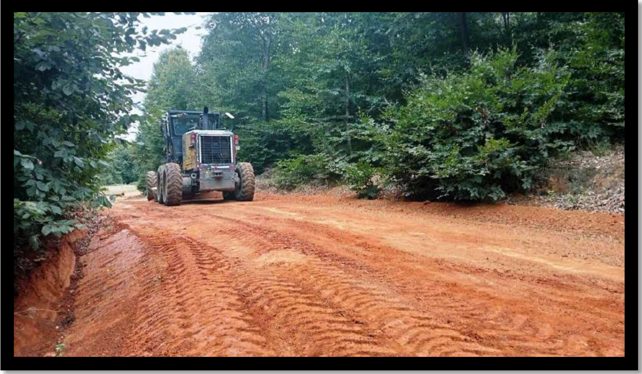
Avdan Mahallesi Arazi Yolu Tesviye Çalışması
