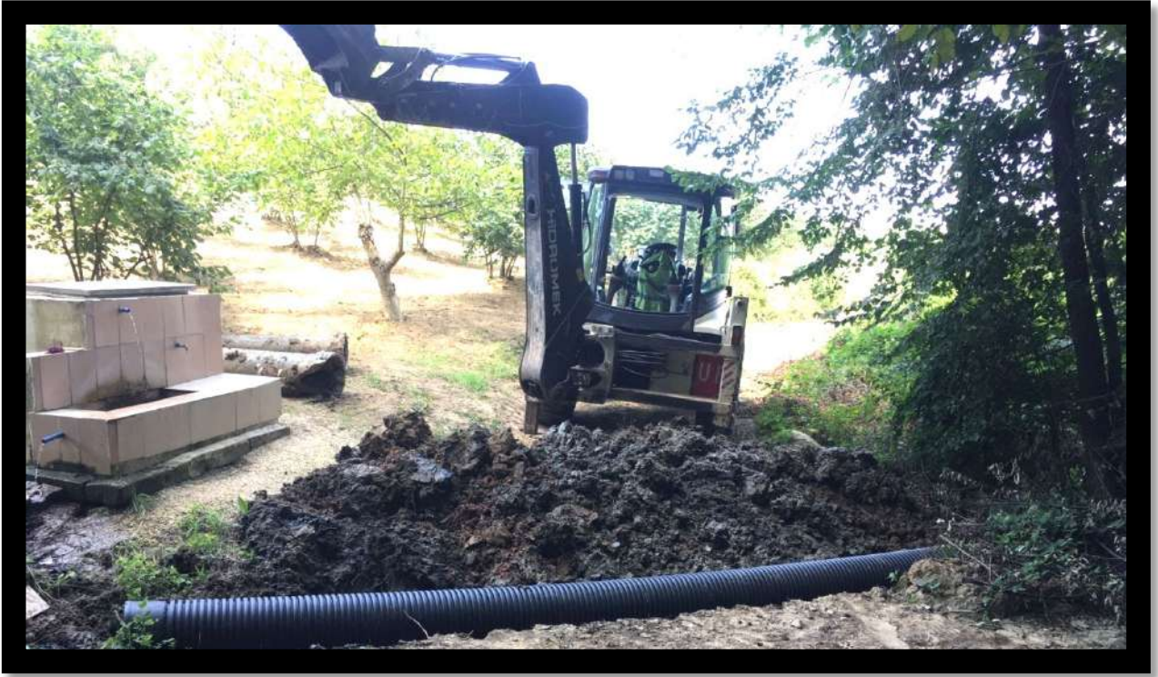
Pelitpınarı Mahallesi Koruge Boru Koyma Çalışması
