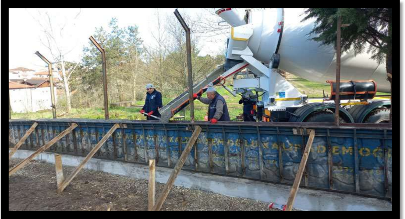
Akdurak Mahallesi İhata Duvarı İmalat Çalışması
