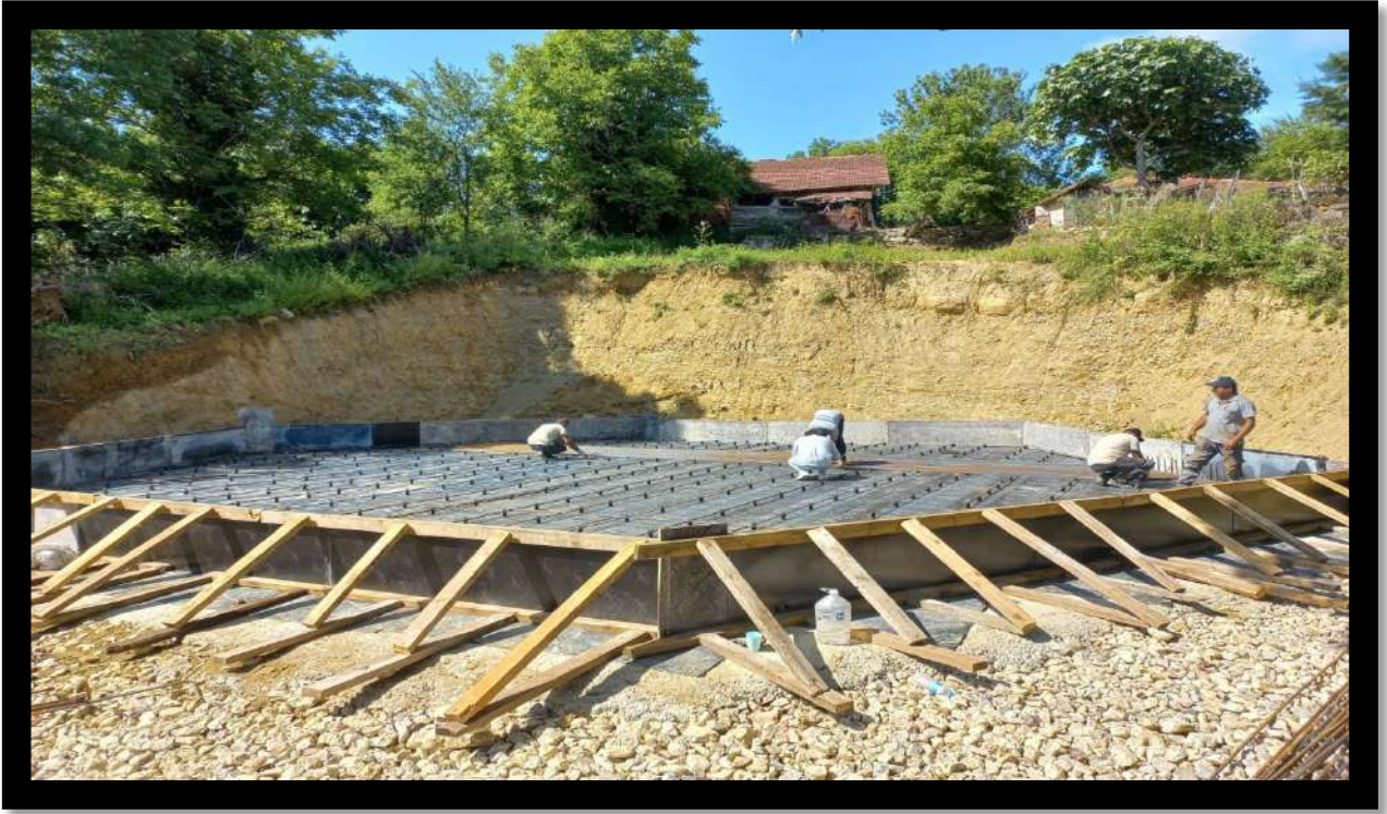
Cakırcaali Mahallesi Cicili Camii Temel Atma Çalışması
