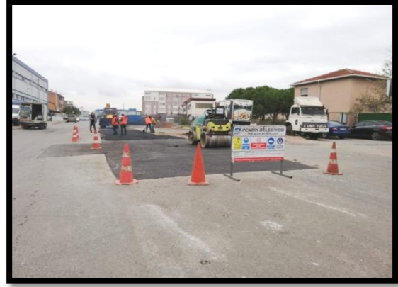
Asfalt Yama Çalışması
