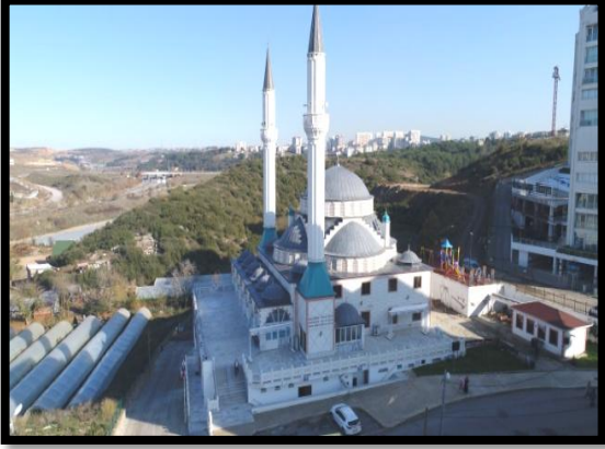
Şeyh Şabanı Veli Camii Kireş Tadilatı
