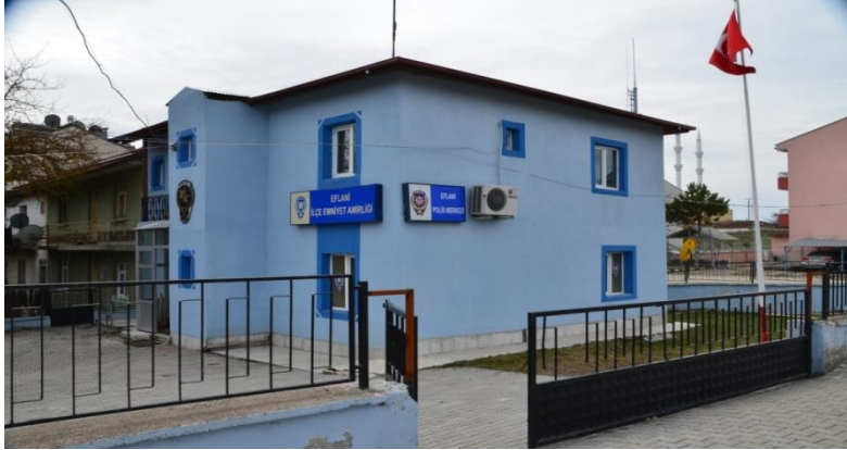
Eski Hizmet Binası
