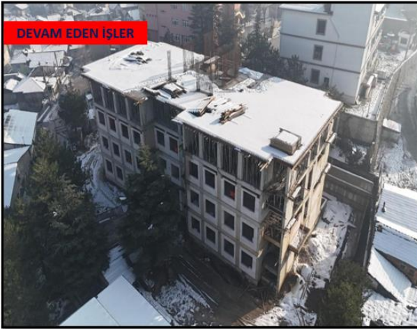
FEVZİ ÇAKMAK 24 DERSLİKLİ LİSE BİNASI YAPIM İŞİ
