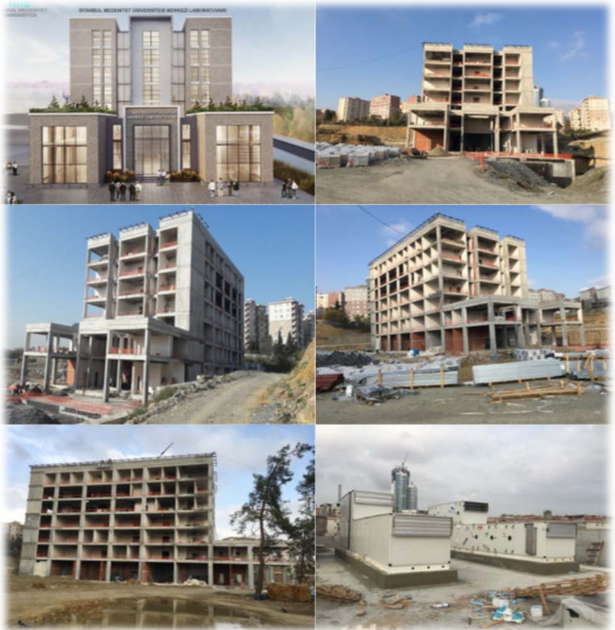
Resim: Üniversitemizin Merkezi Laboratuvarı Binası İnşaatı ile Altyapı ve Çevre Düzenlemesi İşinden Görünüm
