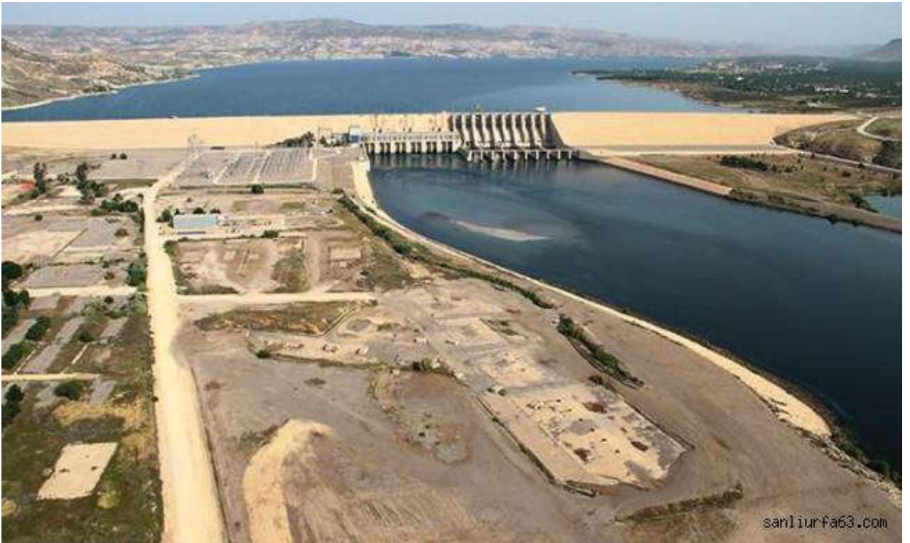
Birecik Barajından görünüm
