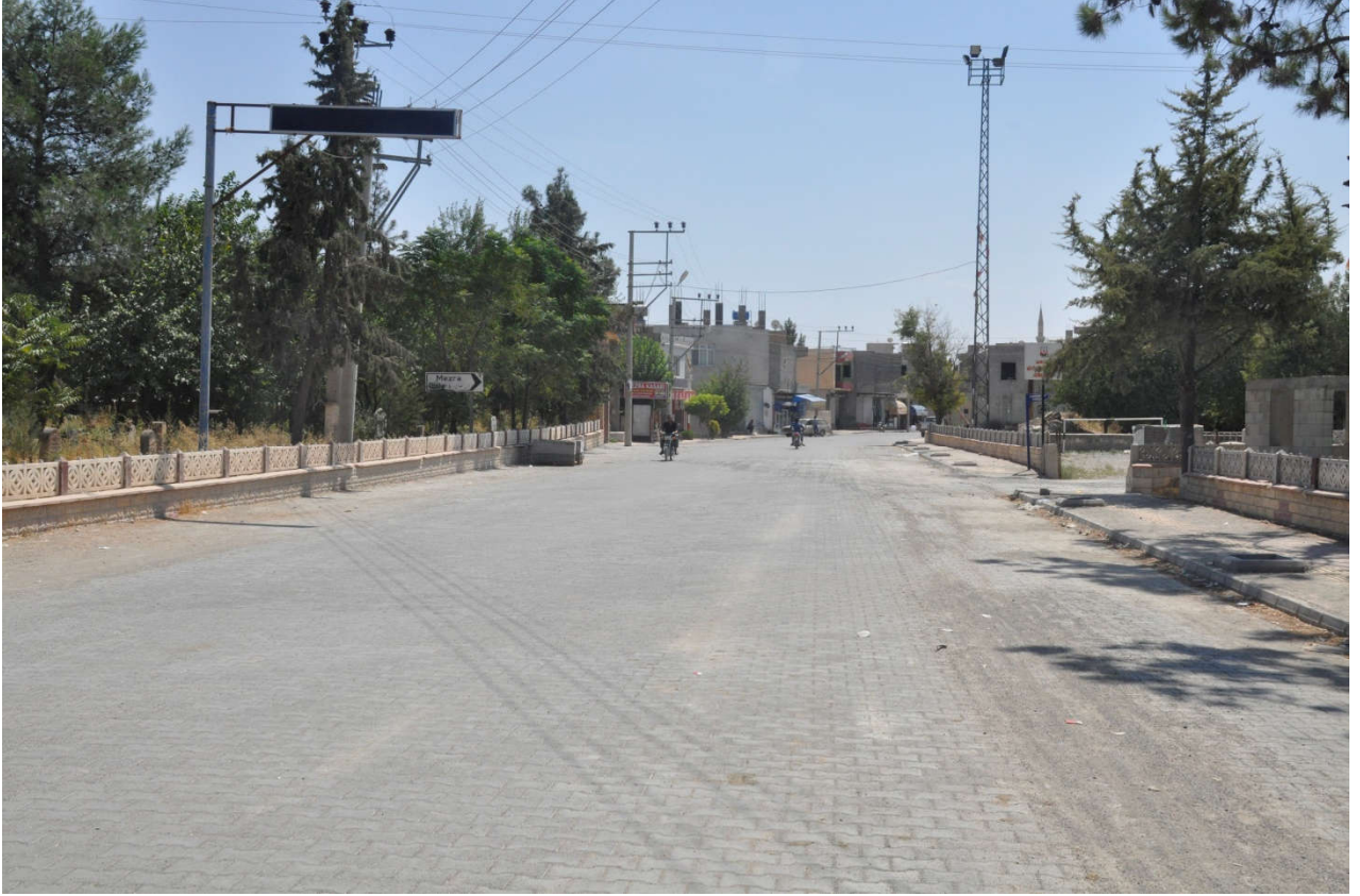
Kilit Parke Çalışmaları
