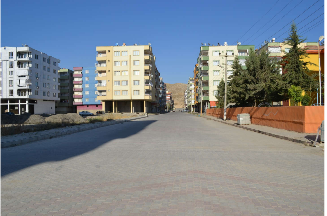
Kilit Parke Çalışmaları
