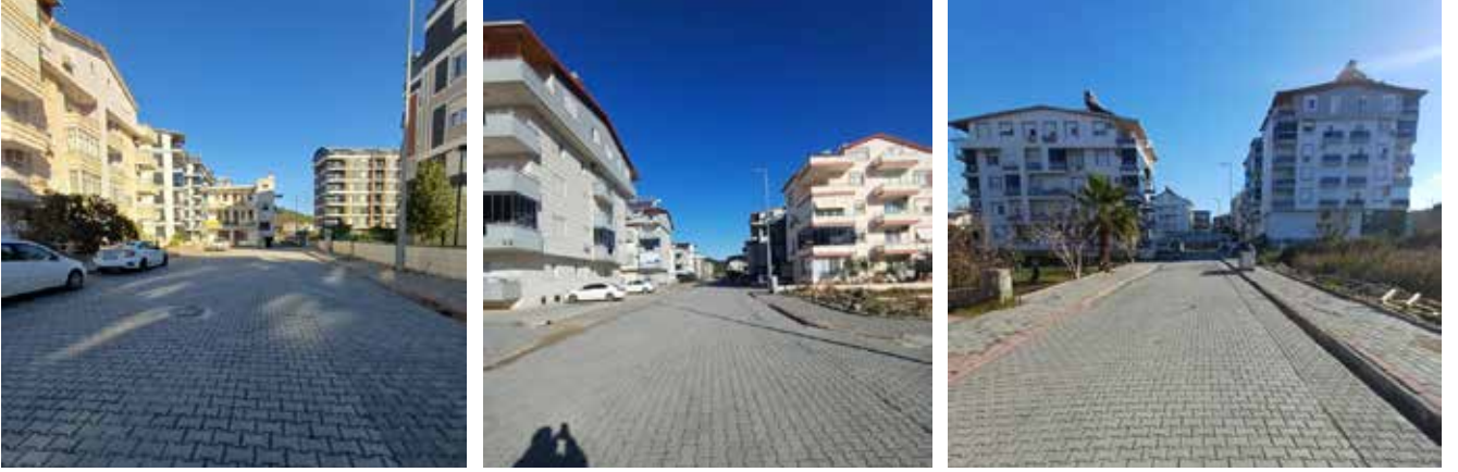
Pazarcı Mahallesi Armutçuk Sokak Parke Yol Yapım Sonrası
