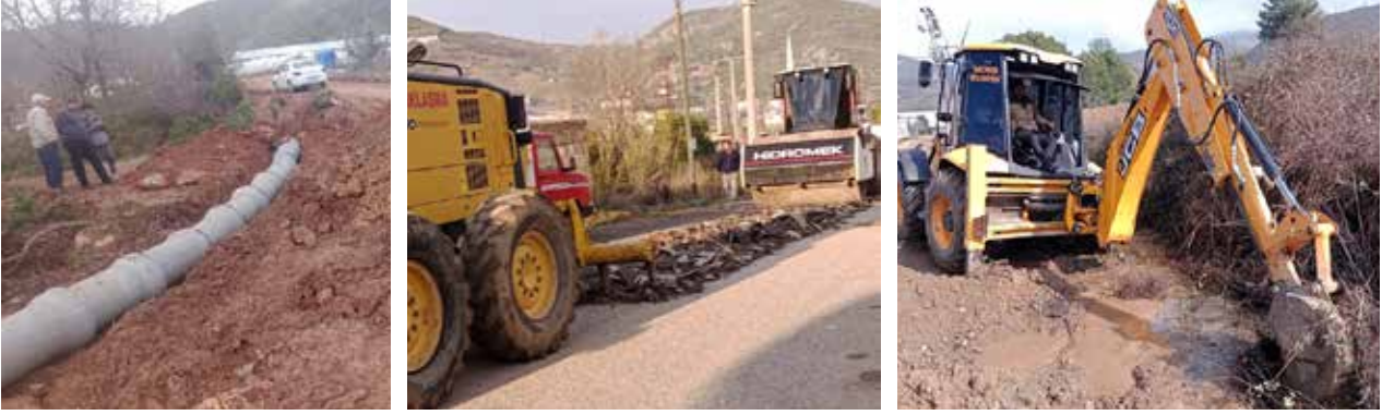
Muzkent Mahallesi Büz Çalışması
