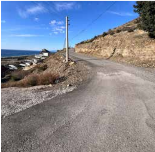
Koru Mahallesi Yol Yapım Çalışması
