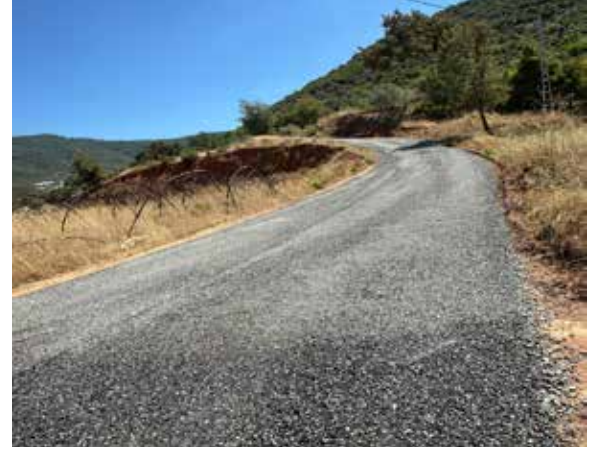
Muzkent Mahallesi Asfalt Serim Çalışması
