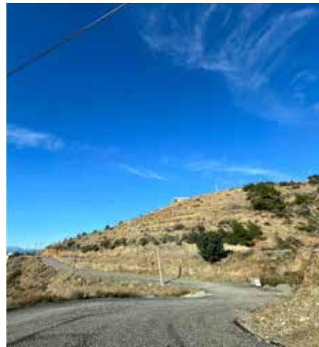
Koru Mahallesi Yol Yapım Çalışması
