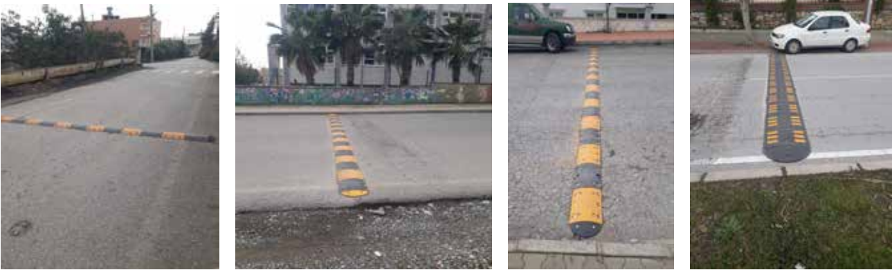
Gazi, Pazarcı, Beyobası ve Yeni Mahallede Kasis Yapım Çalışması
