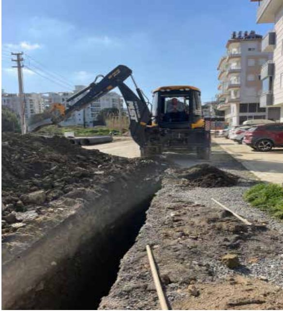
Pazarcı Mahallesi Asmaaltı Caddesi Yağmur Suyu Hattı Çalışması
