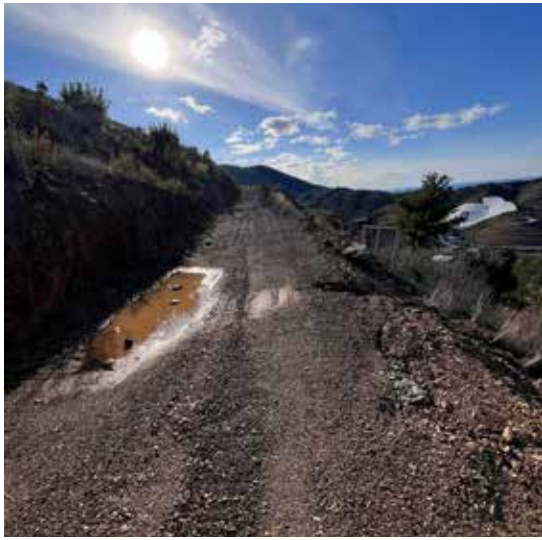
Ekmel Mahallesi Yol Açma Çalışması
