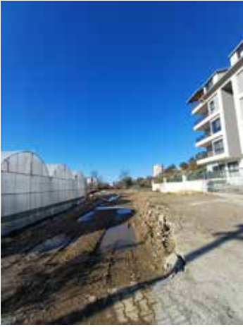
Pazarcı Mahallesi Yol Açma Çalışması
