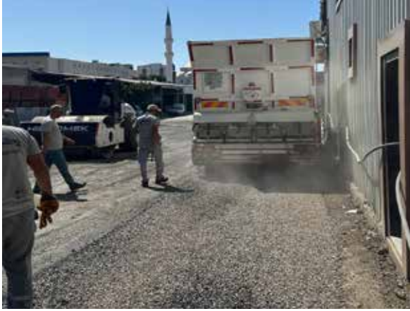
Sanayi Sitesi Asfalt Serim Çalışması
