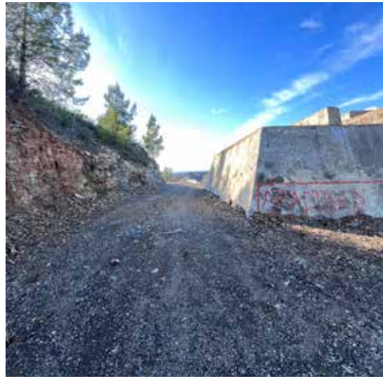
Ekmel Mahallesi Yol Açma Çalışması
