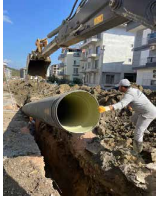
Pazarcı Mahallesi Asmaaltı Caddesi Yağmur Suyu Hattı Çalışması
