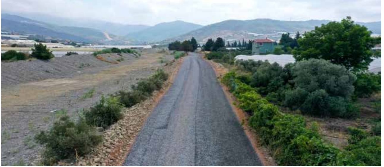
Hasdere Mahallesi Asfalt Serim Çalışması
