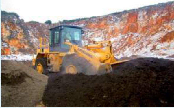
8-İlçemiz Döküm Sahasına Gelen Hafriyatlar Düzenli Olarak İş Makinesi ile Düzeltilmektedir.
