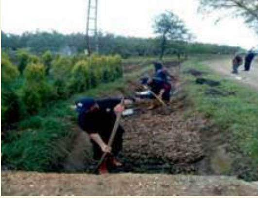
ORHANGAZİ POMPA İSTASYONU SULAMA KANALLARI TEMİZLENMESİ VE BAKIMI
