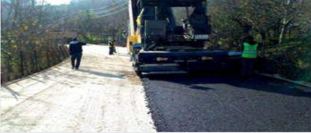
Asfalt çalışmaları sırasında güvenlik ve trafik önlemleri
