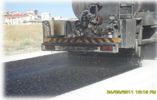
-Soğuk Asfalt (Satuh Kaplama) Çalışması-
