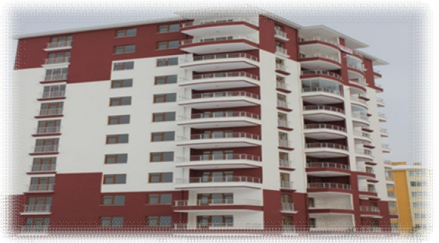
İnşaat Bitim Aşamasında
