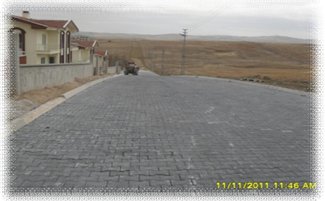
Kilitli Beton Parke Yol Kaplaması
