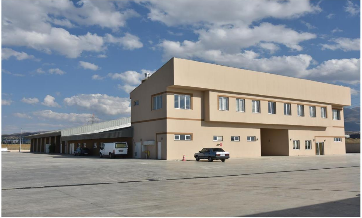
Resim 10: Kapalı Garaj ve Güvenlik Binasından Görünüm
