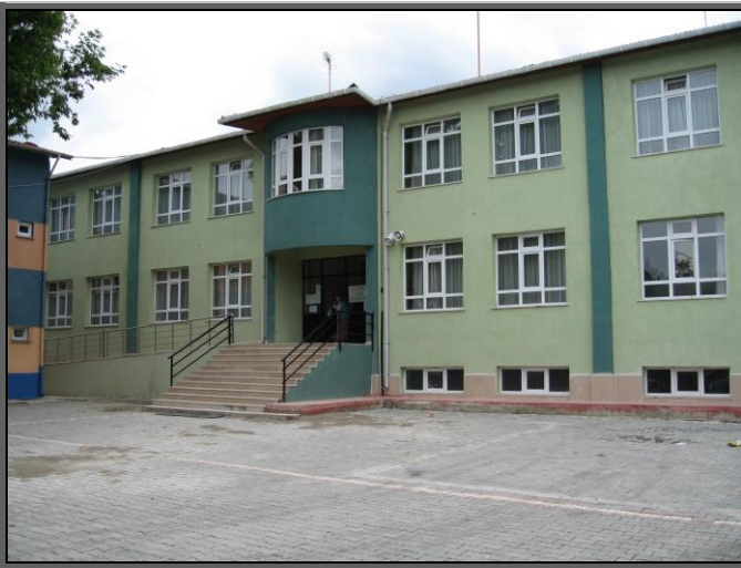
( Boyabat Atatürk İ.Ö.Okulu 12 Ek Derslik İnşaattı )
