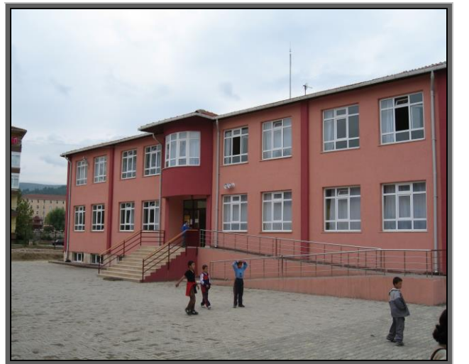
( Boyabat Fatih İ.Ö.Okulu 12 Ek Derslik İnşaattı )
