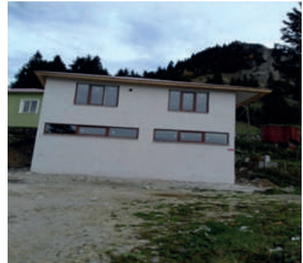
Tonya İlçesi Erikbeli Yayla camii imamevi, şadırvan ve wc yapılması
