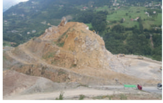
Maçka- Başar, Bağışlı Kıрма Eleme, Hazır Beton Ve Mekanik Plent Tesisi
