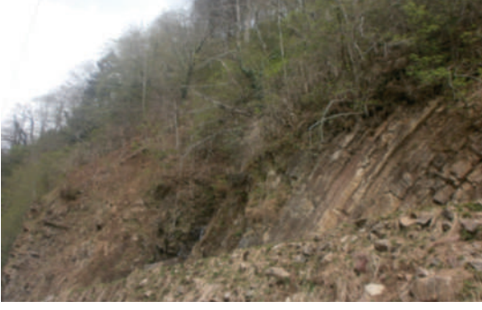
Hayrat-Yeniköy Mahallesi Andezit-Bazalt Ve Kıрма- Eleme Tesisi
