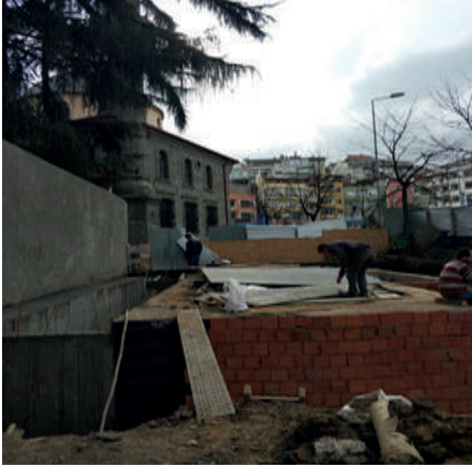
Hacıkasım camii şadırvan ve wc yapımına 12/11/2017 tarihinde başlandı. Çalışmalar devam ediyor.
